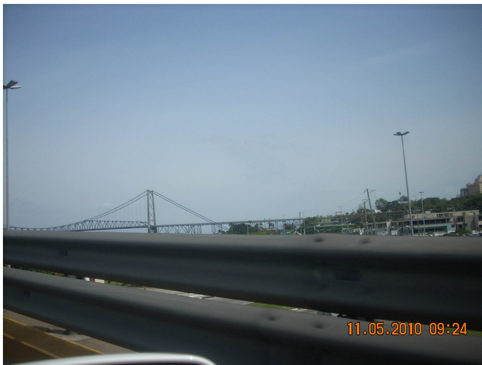
Figura 73 - Vista da Ponte Hercílio Luz a partir da ponte Colombo Salles, com os guard rails de 1,20 metros em primeiro plano.
