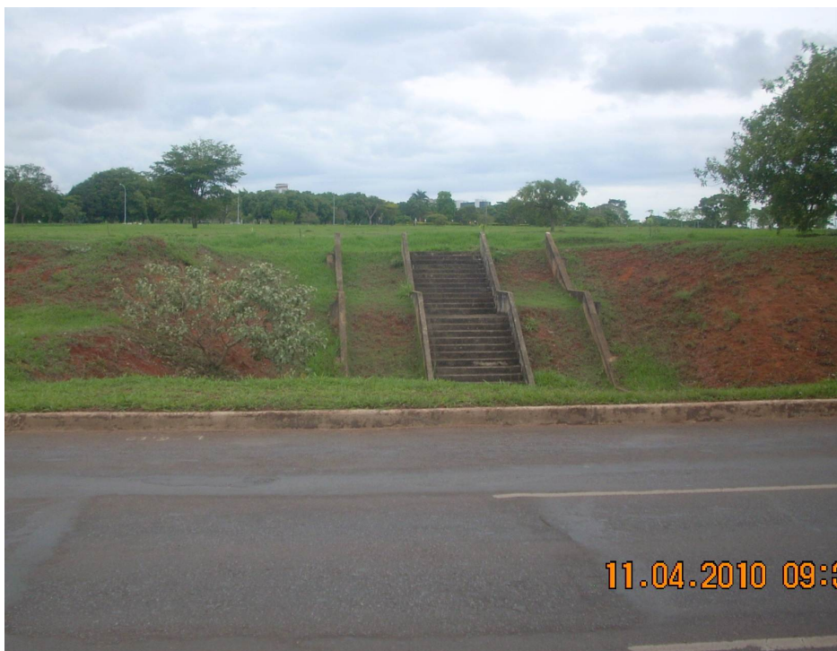
Figura 64 - Vista da escada colocada no outro lado da via em frente ao Pier 21, como via de acesso do pedestre ao estacionamento planejado que ocuparia toda esta área verde pertencente ao plano piloto e desenhada para a livre circulação e uso dos cidadãos de Brasília.
