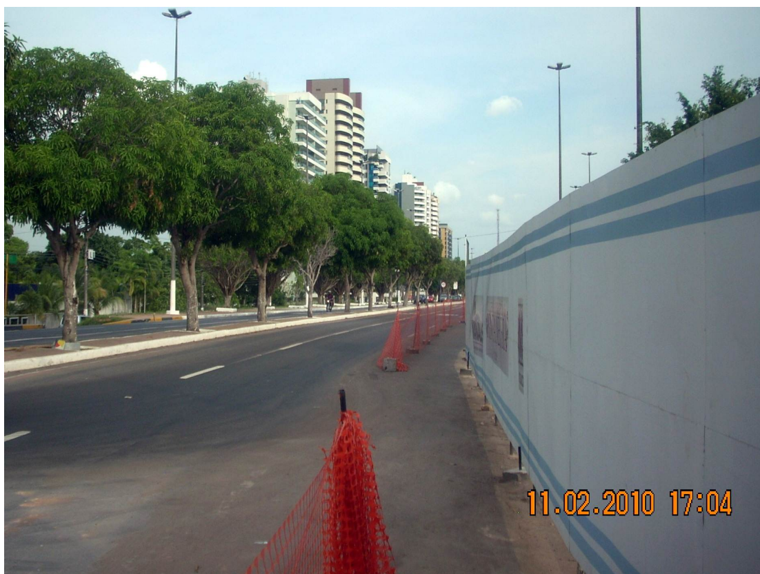
Figura 43 - Ponta Negra hoje, os tapumes encobrem a área que já foi desocupada e onde se iniciam as obras da nova área de lazer. Ao fundo a parede de prédios que margeia a ponte negra, retirando assim a paisagem de mata original da área e que permitia aos cidadãos fazer “a fuga do urbano, no urbano”.
