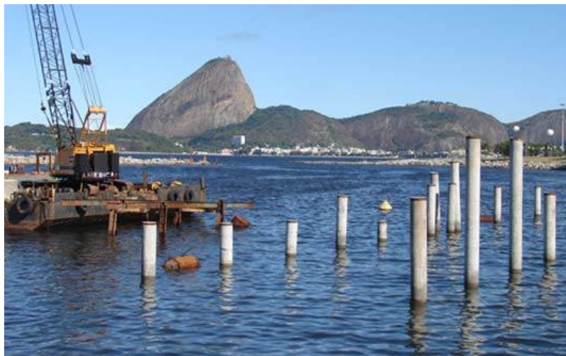
Figura 66 – Estacas para construção da Garagem náutica não retiradas da Marina da Glória que desfiguram a paisagem, apesar do embargo da obra e ordem judicial de retirada imediata. Disponível em < http://g1.globo.com/Noticias/Rio/0,,MUL24203-5606,00-EMBARGO+DE+OBRAS+NA+MARINA+DA+GLORIA+NAO+INVIABILIZA+PROVAS+DO+PAN.html >
