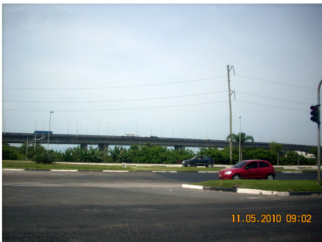
Figura 70 - vista panorâmica da ponte Colombo Salles, apresentando o contexto urbano em que ela está.
