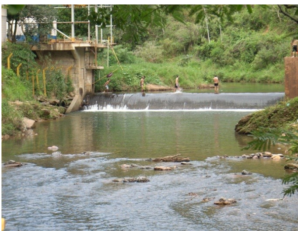
Barragem- Ribeirão da Prata - Raposos/MG.
