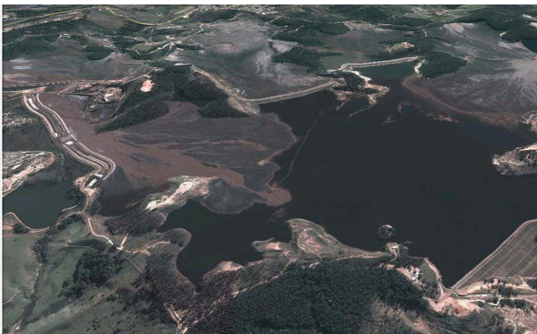
FIGURA 7.2 – Imagem orbital do Google Earth em 2011. Verifica-se a extensão da barragem do Pontal.
