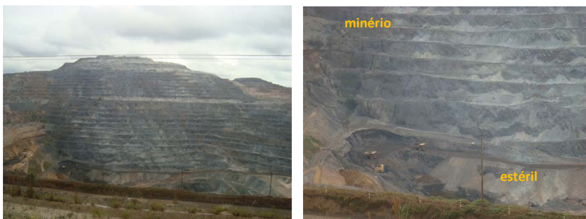
FIGURA 6.6. Fotografias registradas no trabalho de campo em 2011 referentes a cava da mina de Conceição. Observe a parte mais escura no corte, que corresponde ao minério de ferro, rico em hematita, a parte mais clara, ao estéril.
