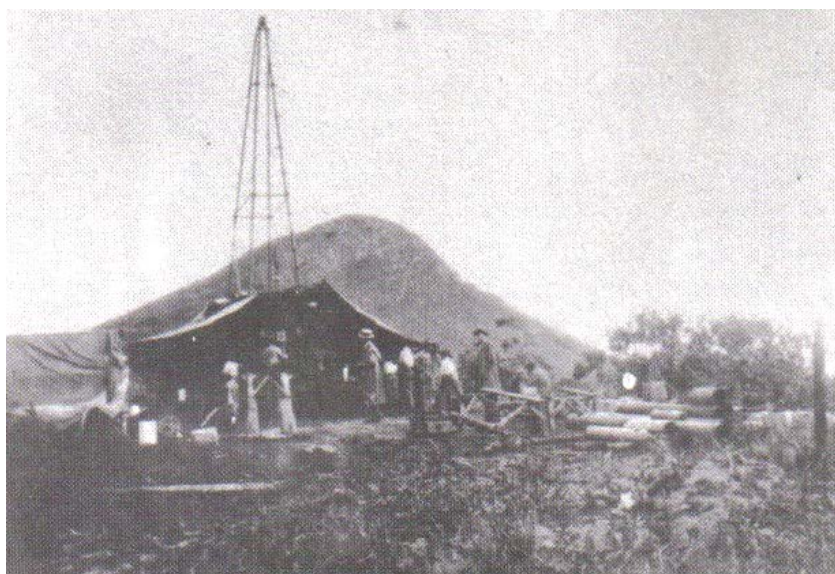
FIGURA 6.4. Foto ilustrativa do livro da CVRD demonstrando a prospecção mineral nas proximidades do Pico do Cauê, 1920-1930. Observe em primeiro plano a perfuratriz utilizada na exploração do minério.
