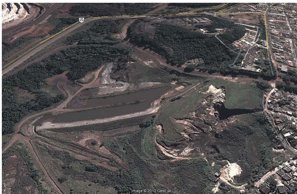
FIGURA 7.3 – Imagem orbital do Google Earth ano 2011 das barragens Cambucal I (A) e II (B). Nota-se a presença de processos erosivos a jusante das barragens, podendo contribuir para a instabilidade dos barramentos.
