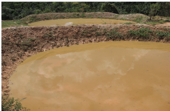
FIGURA 13 - Acúmulo de água em barraginhas com argila em suspensão, indicando erosão dos solos
