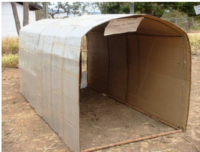
FIGURA 2: Aviário móvel com telhado de papelão revestido com lâmina Tetra Pak® Fonte: Arquivo da pesquisa, 2011.
