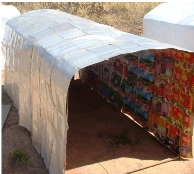
FIGURA 3: Aviário móvel com telhado de lâmina Tetra Pak® Fonte: Arquivo da pesquisa, 2011.
