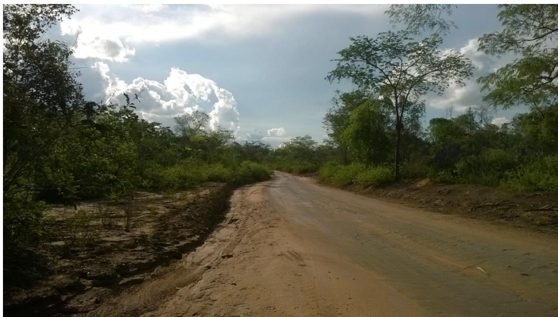
Foto 9. Obras realizadas como o uso da retroescavadeira– Manutenção de estradas vicinais.
