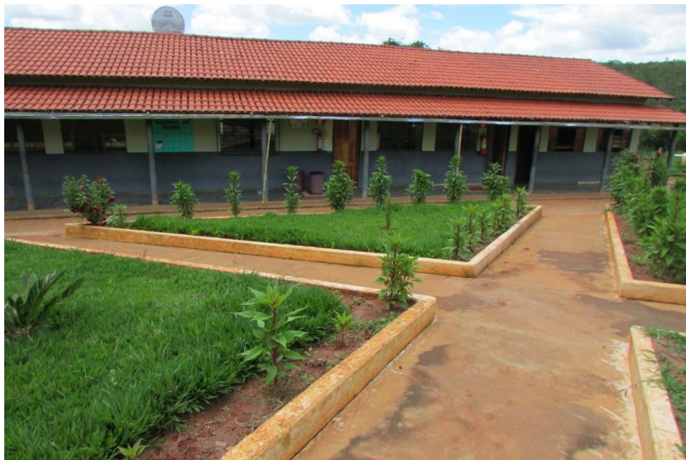
Foto 1. Estrutura Física da Escola Família Agrícola de Veredinha – Pátio e salas de aula.
