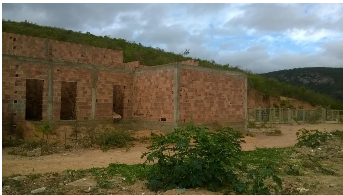
Foto 8. Estrutura Física do Abatedouro de Gado – Prédio e curral.
