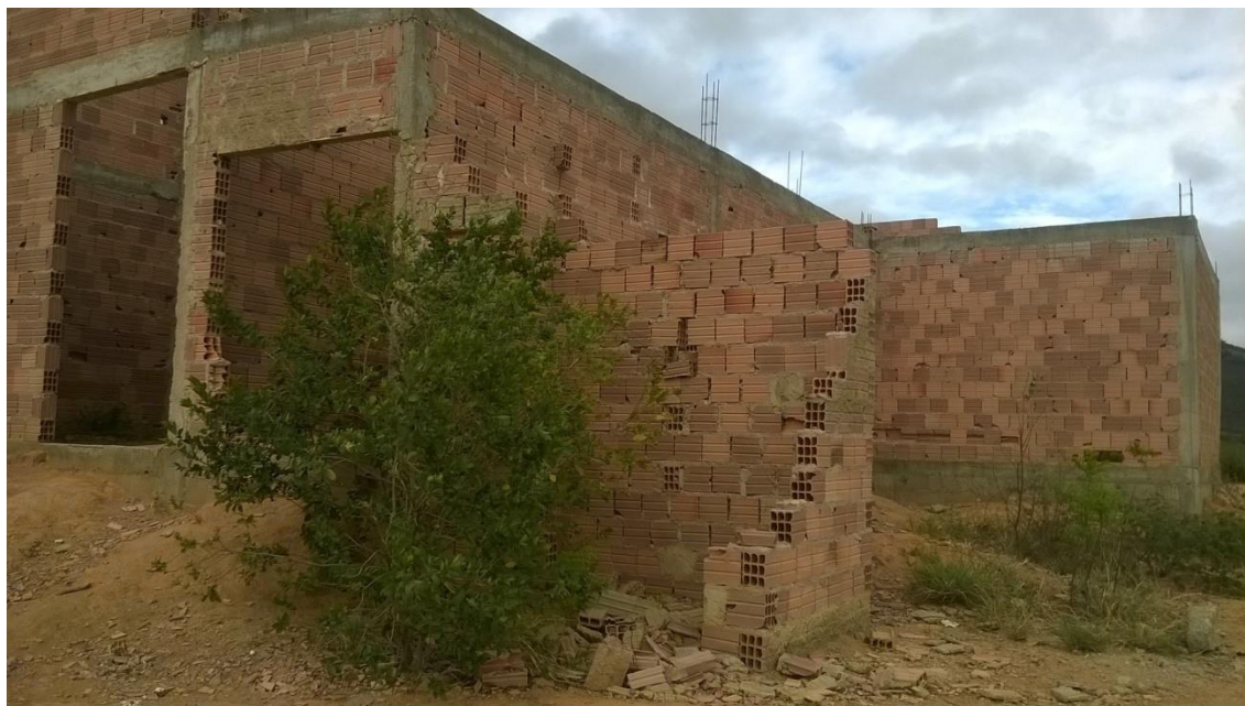
Foto 7. Estrutura Física do Abatedouro de Gado – Prédio.
