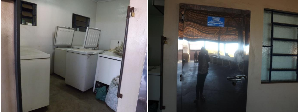
Figura 17. Espaço de armazenagem de produtos da feira livre de Datas. À esquerda sala com refrigeradores e a direita uma câmara de frios
