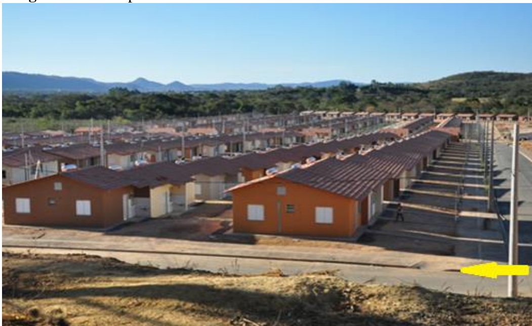
Figura 15 – Rampa de acesso à rua no Residencial Montes Claros
