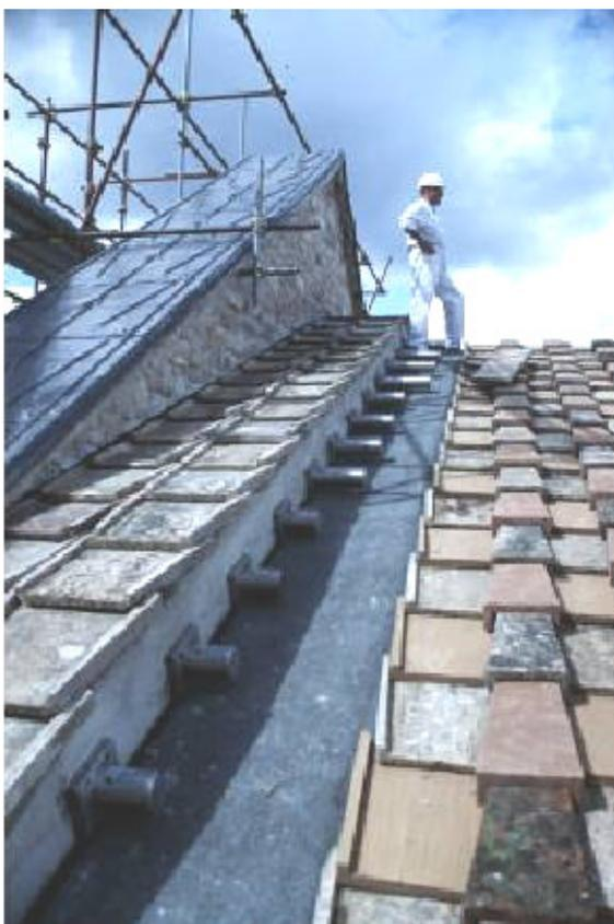
FIGURA 3.36 – Atuadores no topo do telhado da Basílica de São Francisco de Assis.
