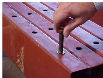
(b) Parafuso com cabeça sextavada e rebite tubular com rosca interna
