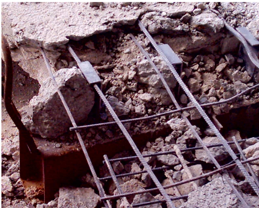
Figura B.3 – Detalhes da armadura e dos conectores na viga do Tipo II
