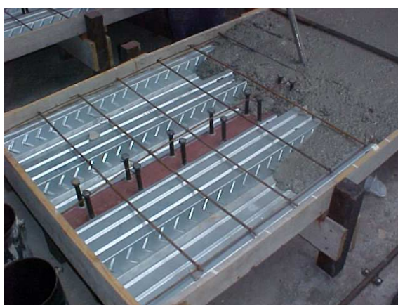
Figura 3.16 – Concretagem da viga mista
