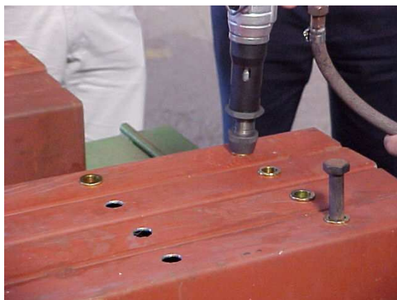
c) Instalação dos rebites nos furos da viga
