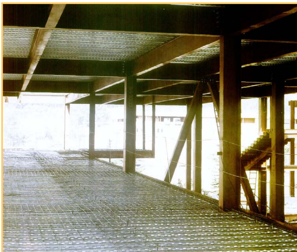
FIG. 1.2 – Modulação típica para formas metálicas convencionais (Catalogo CODEME)
