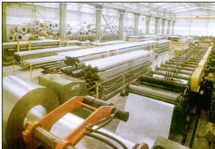
FIG 3.19 – Sistema para conformação de fôrmas metálicas
