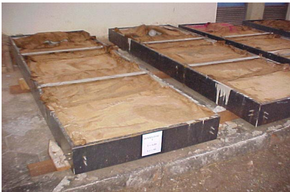
FIGURA 2.3 – Detalhe da cura do concreto utilizado nos modelos
