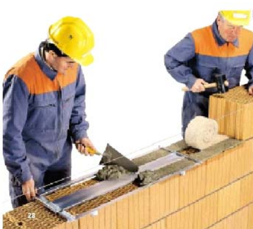
FIGURA 18 – Colocação da argamassa e isolante térmico em blocos não retificados. Fonte: “Catalogo 2003 Wienerberger, France” citado por CAVALHEIRO (2004)
