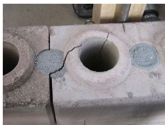
(d) junta rompida fora da flexão pura mp 44i
