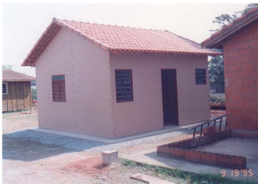
FIGURA 33 – Casa construída no pátio de testes do IPT, para certificação de sistema construtivo composto de blocos encaixáveis
