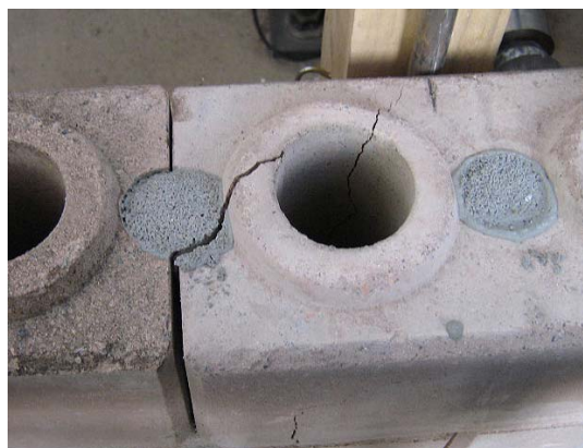
(e) trinca fora das linhas de carregamento
