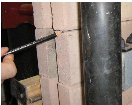
(a) abertura da junta, na região de flexão pura
