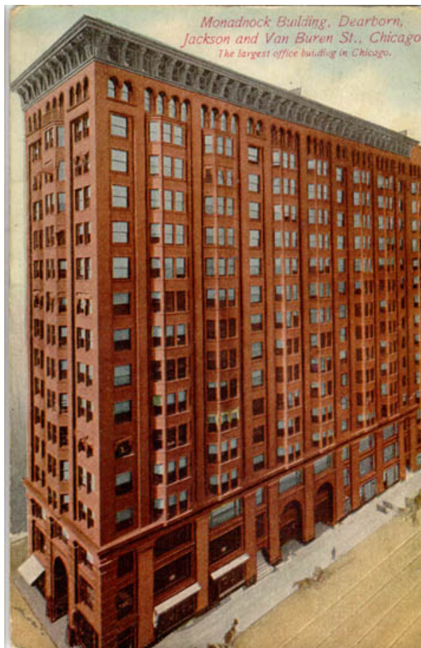
FIGURA 15 – Edifício de 16 pavimentos, construído em alvenaria resistente (estrutural), na cidade Chicago – USA, em 1891. Fonte: www.rootsweb.com
