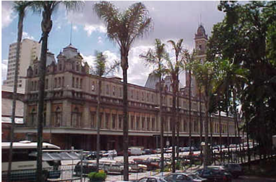
FIGURA 12 – Estação da Luz na cidade de São Paulo com paredes e arcos em alvenaria. Fonte: www.encyclópédia.com.br
