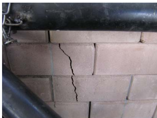
(c) trinca de face 3
