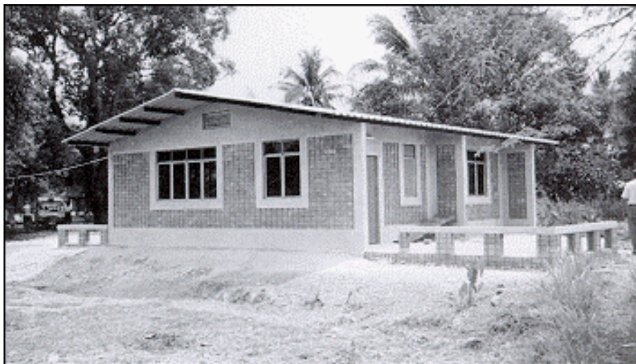
FIGURA 30 – Casa construída com blocos de concreto encaixáveis, na Tailândia. Fonte: TISTR (1994)
