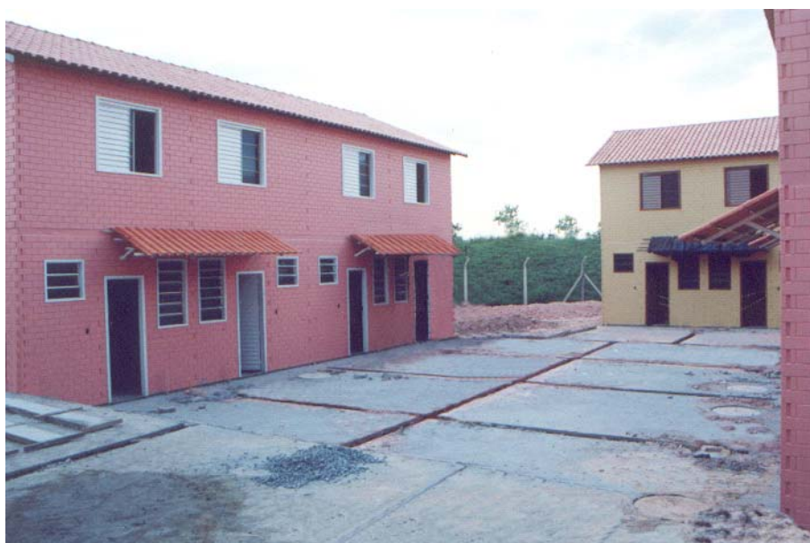
FIGURA 35 – Parte do conjunto habitacional Granja de Freitas III com 146 unidades geminadas construídas para a Prefeitura de Belo Horizonte - MG
