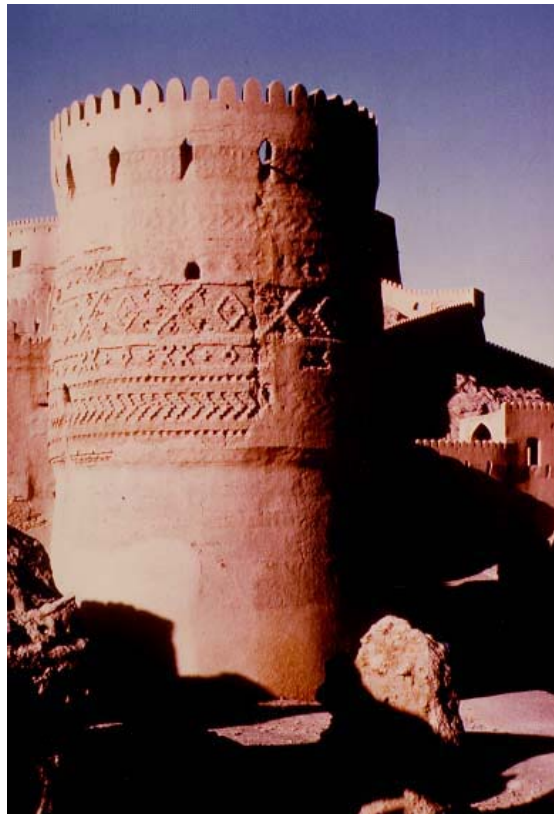
FIGURA 6 – Torre construída em terra crua, na cidade Bam no Iran. Fonte: www.webitalianet.com
