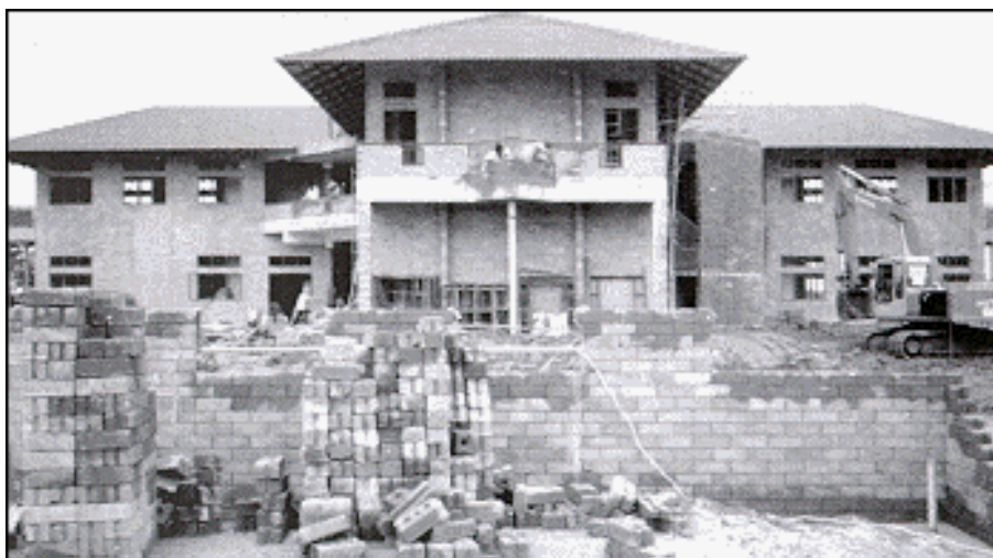
FIGURA 31 – Prédio escolar em Chiang-mai na Tailândia. Fonte: ITERBEKE (1994)
