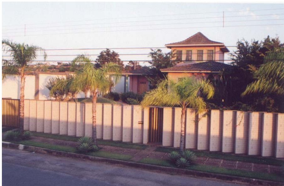
FIGURA 38 – Casa-laboratório, construída em 1993 em Belo Horizonte - MG
