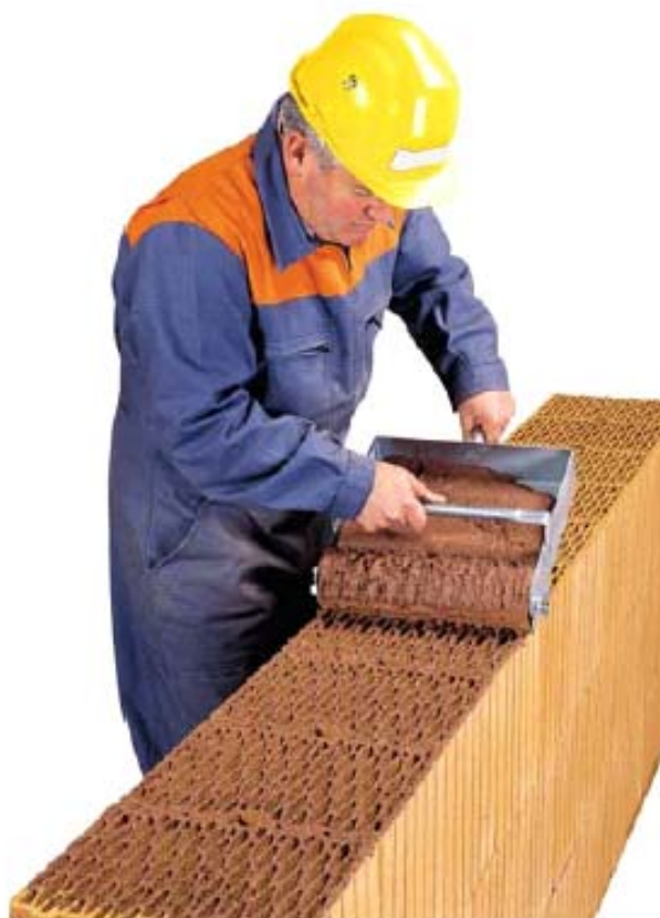
FIGURA 17 – Colocação da argamassa em blocos retificados - Alvenaria rolada. Fonte: “Catalogo 2003 Wienerberger, France” citado por CAVALHEIRO (2004)
