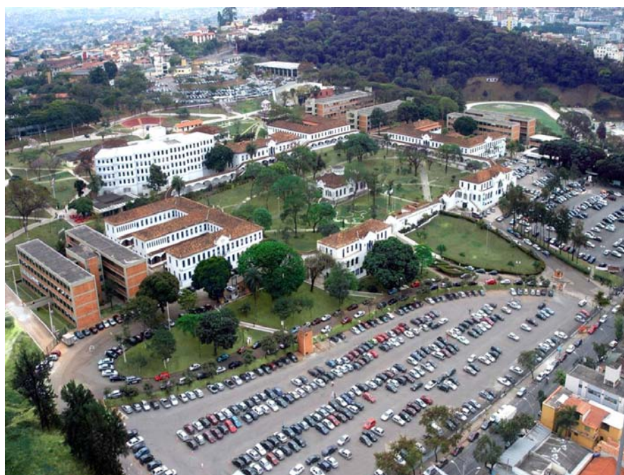
FIGURA 14 – Campus da PUC Minas, no bairro Coração Eucarístico em Belo Horizonte. Fonte: www.pucminas.br
