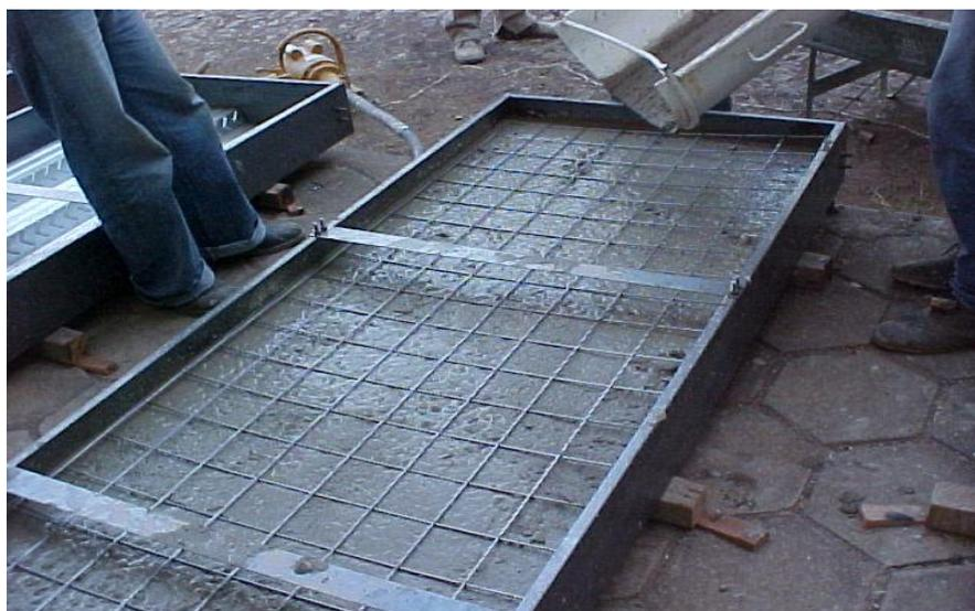
FIGURA 2.2 – Armadura de combate à fissuração de retração e variação térmica
