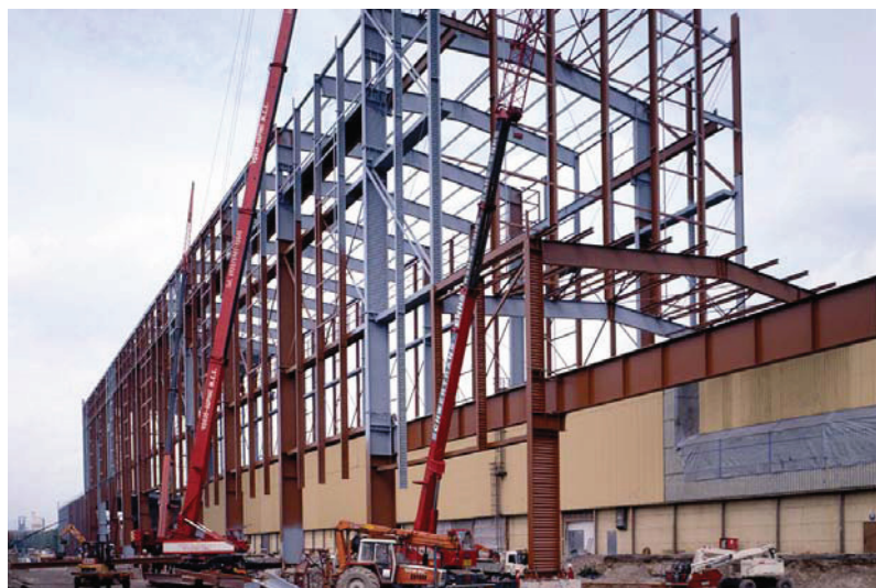
FIGURA 1.9 - Galpão industrial em alma corrugada [PLAIS (2005)]
