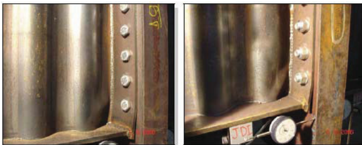
FIGURA 2.24 – Deformação da alma próxima à chapa de topo [GONZAGA (2008)].
