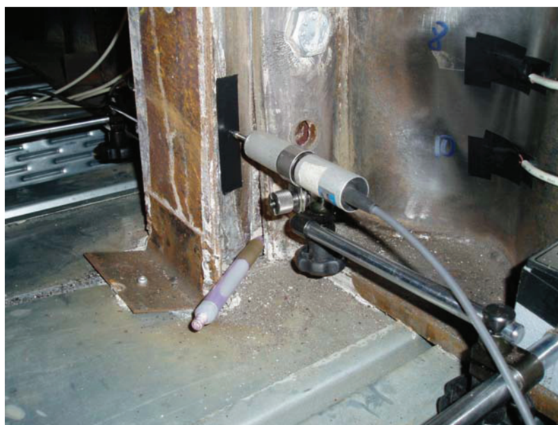
FIGURA 3.10 – Deformação na chapa de topo da ligação
