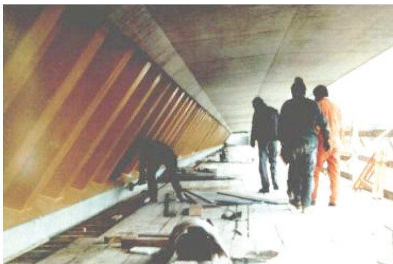
FIGURA 1.3 - Ponte Cognac [PLAIS (2005)]
