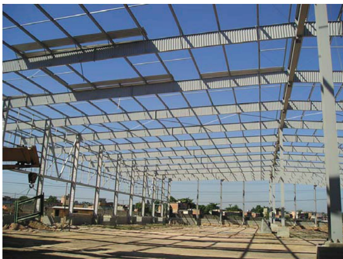
FIGURA 1.13 - Galpão comercial construído pela Codeme [PLAIS (2005)]
