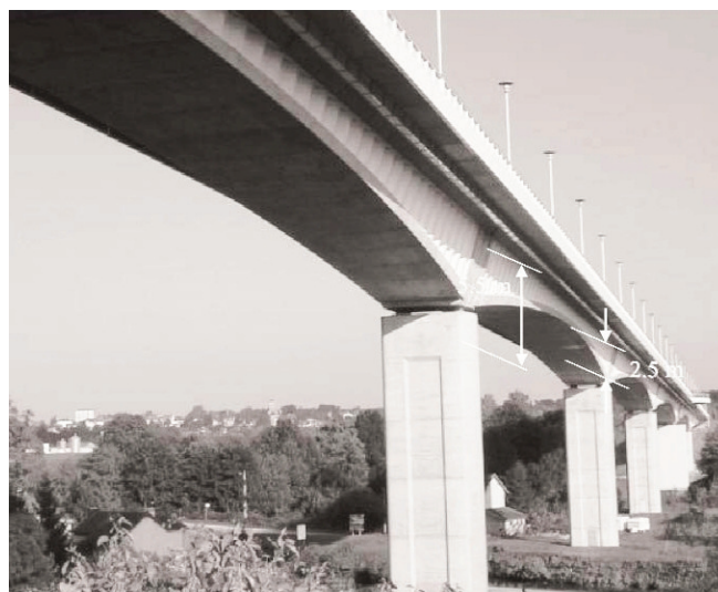
FIGURA 1.6 - Ponte Dole [PLAIS (2005)]
