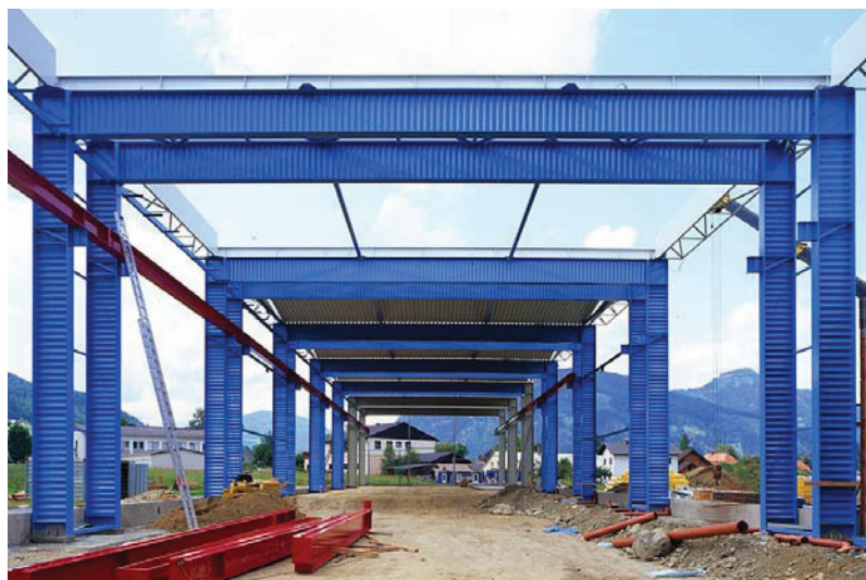
FIGURA 1.8 - Galpão comercial em alma corrugada [PLAIS (2005)]
