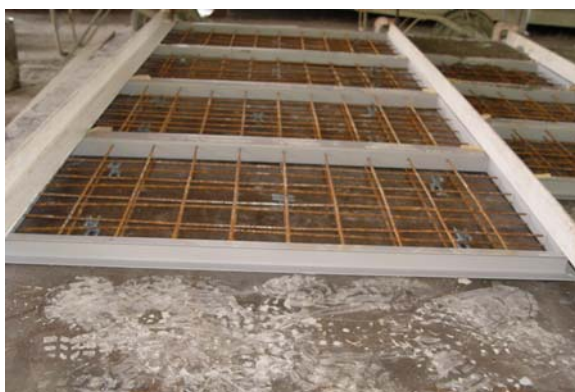
FIGURA 3.15 - Painéis da etapa 3 prontos para concretagem
