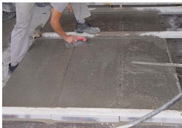
FIGURA 3.14 - Painéis da etapa 2: concretagem em andamento
