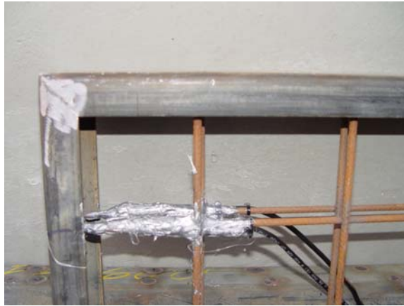
FIGURA 4.22 - Proteção de extensômetros nas telas Q196
