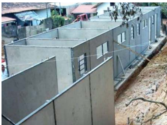
FIGURA 1.2 - Aplicação de painéis de CLE em residências
