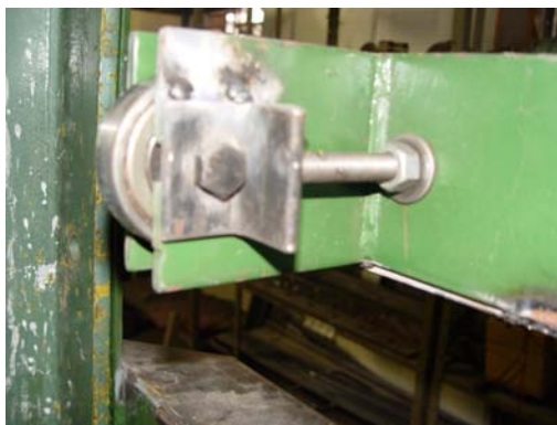
FIGURA 4.11 - Detalhe dos pontos de solda para reforço da ligação
