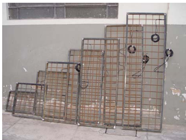
FIGURA 3.1 - Peças metálicas de painéis de CLE: etapa 1
