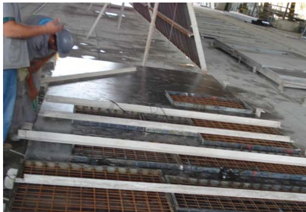
FIGURA 3.13 - Disposição dos quadros metálicos na mesa para a concretagem
