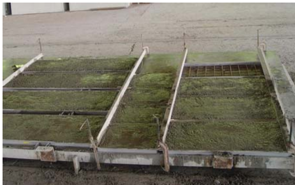
FIGURA 3.16 - Painéis da etapa 3: concretagem em andamento
