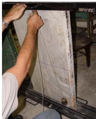
FIGURA 4.16 - Uso do prumo de face para posicionamento adequado ao painel
