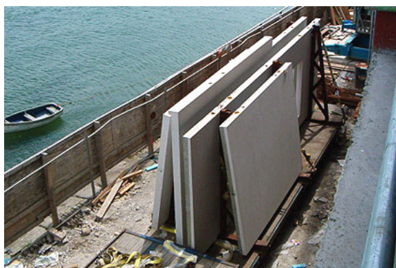
FIGURA 2.3 - Painéis-parede de concreto armado
