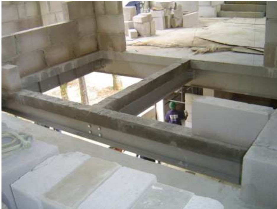
Figura 5.33. Vão dos elevadores. Vista da cinta de concreto e início da montagem da alvenaria em bloco de concreto celular autoclavado (Fonte: arquivo pessoal. Foto obtida em 14/11/06).
