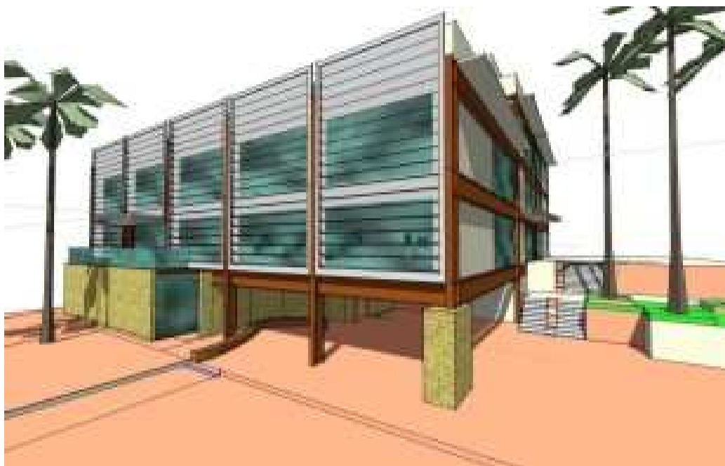
Figura 5.4. Vista lateral direita do edifício (Fonte: arquivo EC-A)
