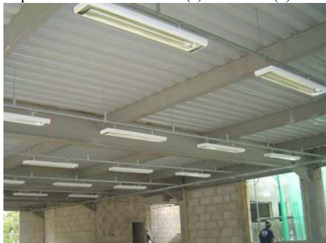
Figura 5.23. Tubulação elétrica aparente. (Fonte: arquivo pessoal. Foto obtida em 09/01/07).
