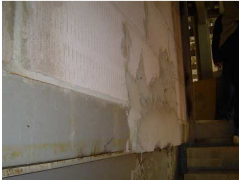
Figura 5.38. Testes de aderência da argamassa no encontro entre alvenaria e as chapas metálicas de contenção do concreto do steel deck (Fonte: arquivo pessoal. Foto obtida em 14/11/06).
