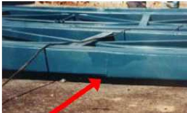
Figura 3.14. Incompatibilidade entre perfis (PRAVIA & BETINELLI, 1998)
