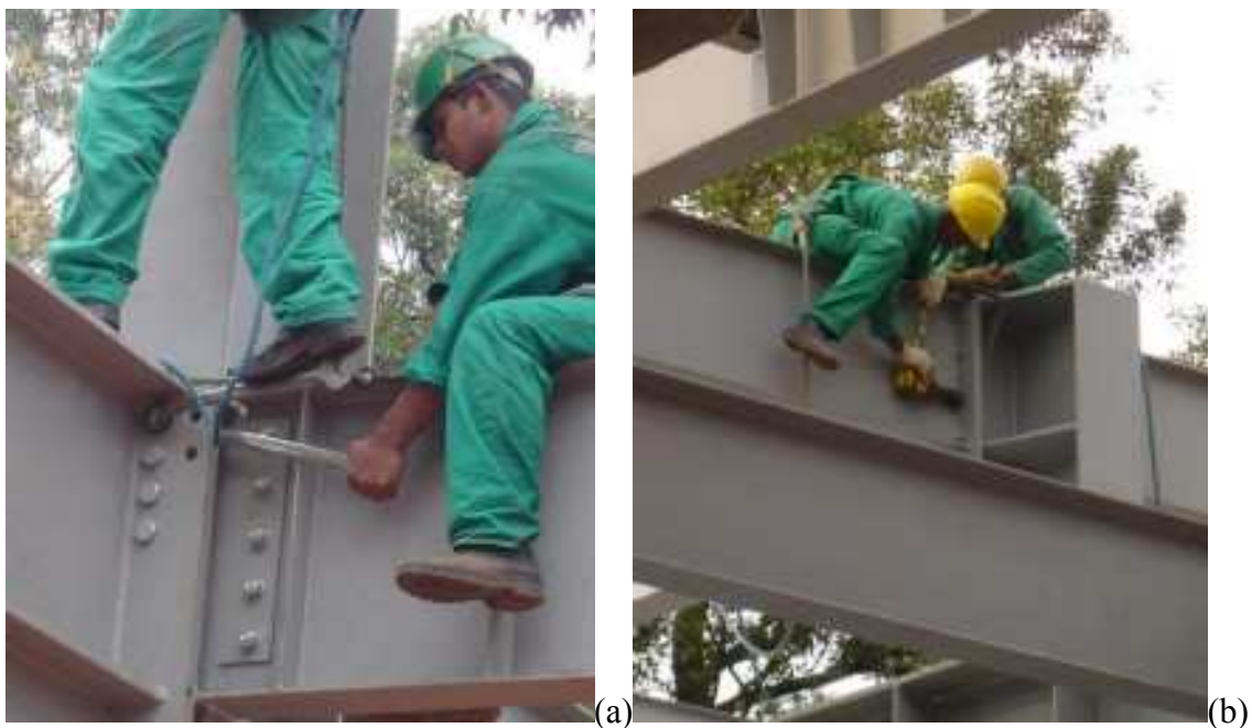
Figura 5.17. Parafusamento realizado manualmente (a) e torqueamento através de ferramentas automáticas (b). (Fonte: arquivo pessoal. Fotos obtidas em (a) 21/09/06e (b)19/09/06)
