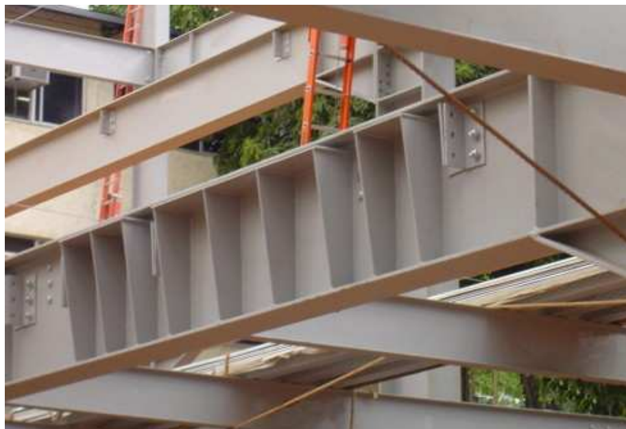
Figura 5.41. Reforço nas vigas onde o piso das áreas molhadas foi rebaixado. (Fonte: arquivo pessoal. Foto obtida em 19/09/06).
