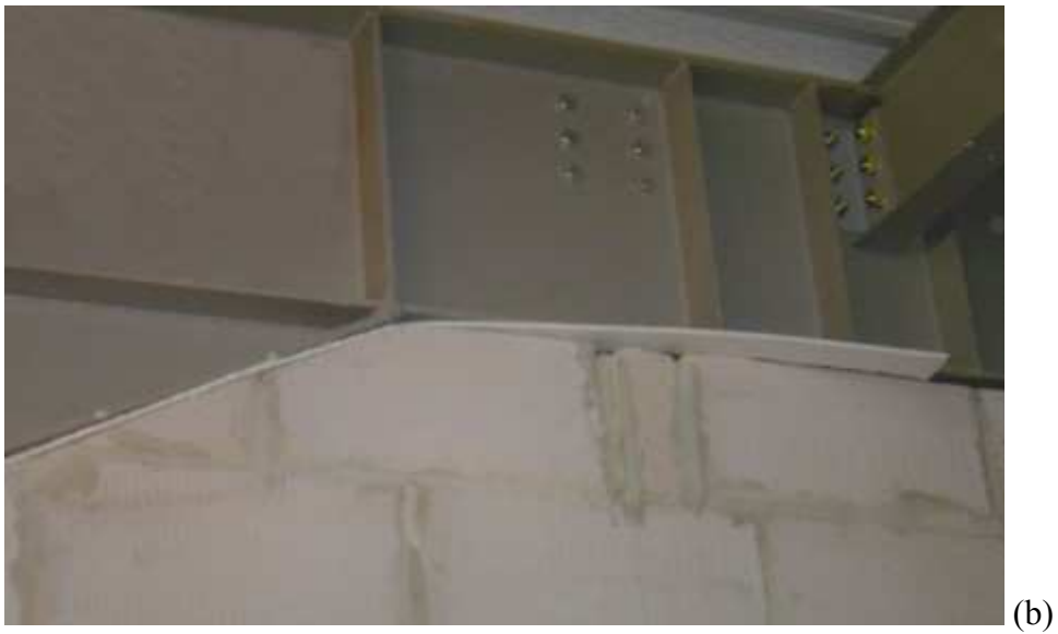
Figura 5.36. Encontro entre a alvenaria e a viga metálica. (a) Chapa metálica soldada e a soldar. (b) Chapa de isopor (Fonte: arquivo pessoal. Fotos obtidas em 09/01/06).
