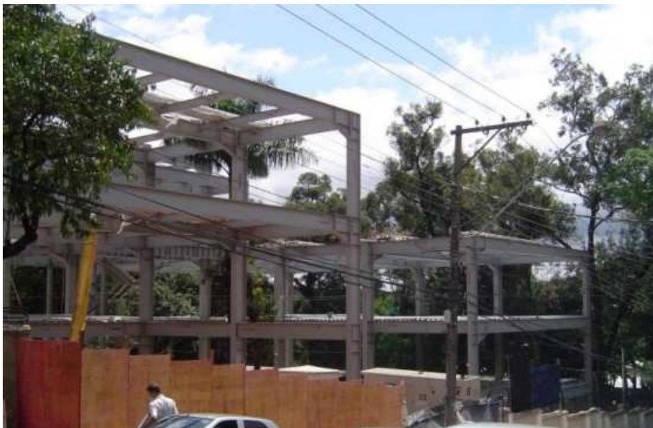
Figura 5.6. Vista da fachada do edifício após montagem da estrutura (Fonte: arquivo pessoal. Foto obtida em 26/09/06)
