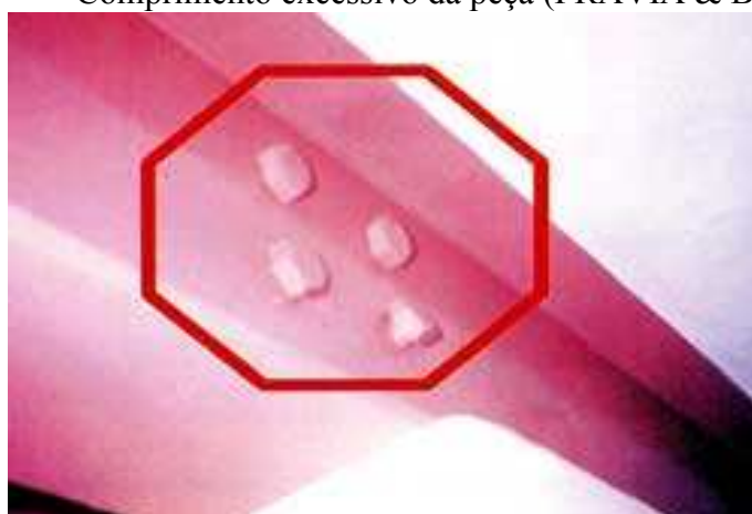
Figura 3.17. Erro na locação do furo (PRAVIA & BETINELLI, 1998)
