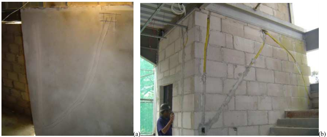
Figura 5.25. Recorte nas alvenarias para passagem das instalações elétricas. (a) Marcação para posterior recorte. (b) Após recorte e passagem da tubulação elétrica. (Fonte: arquivo pessoal. Fotos obtidas em 09/01/07).
