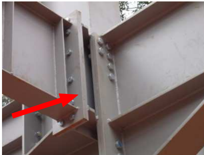
Figura 5.18. Pouco espaço para movimentação das chaves. (Fonte: arquivo pessoal. Foto obtida em 21/09/06)
