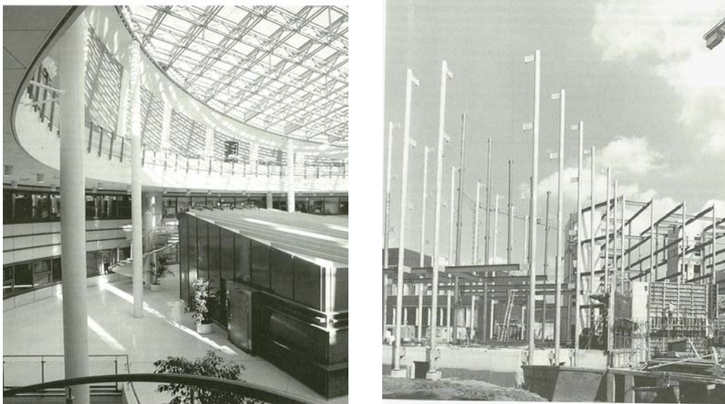
FIGURA 1.1.1 Estruturas em pilares mistos. Fonte CIDECT- Bergmann(1995).
