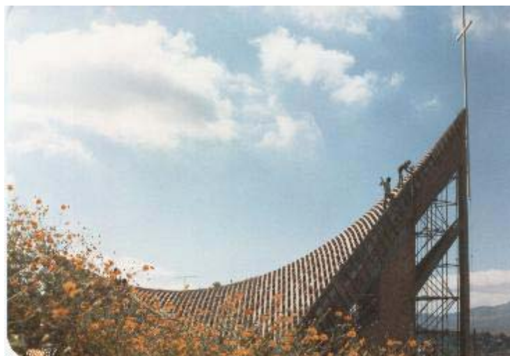
Figura 40.3 – Vista das formas da igreja da Lindéia
