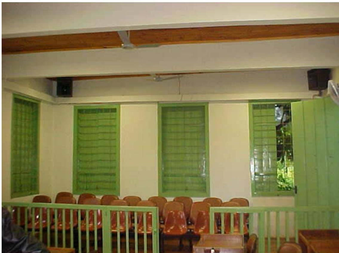
Figura 7.5.1.2 – Vigas dos pórticos com os tirantes perimetrais
