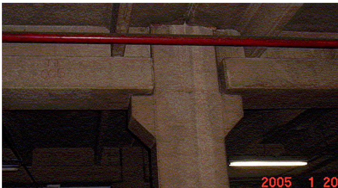
Figura 7.3.5 – Detalhe de console curto de pilar do sistema pré-moldado
