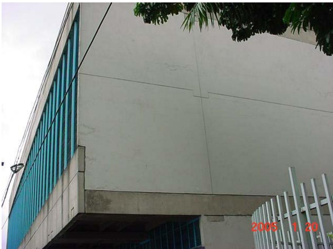
Figura 7.3.4 – Alvenaria íntegra sobre viga do balanço após inserção de juntas
