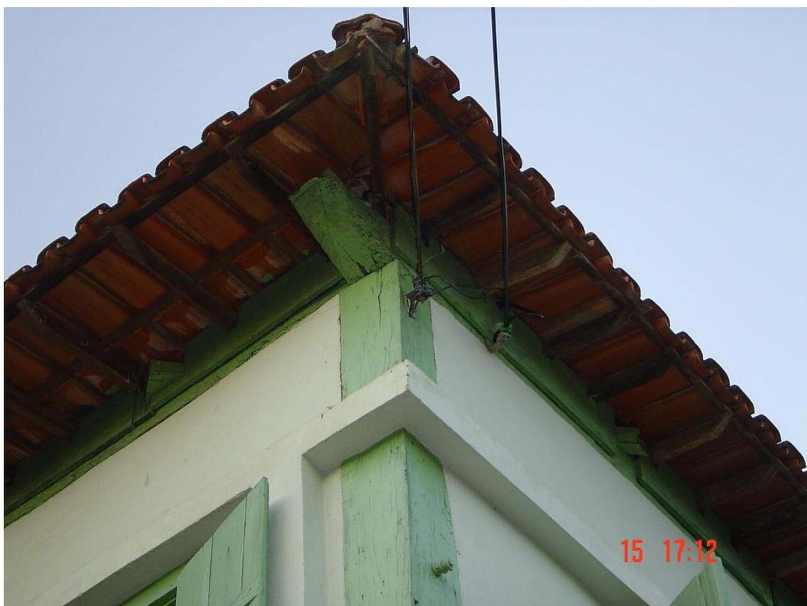
Figura 7.5.1.6 – Detalhe do atirantamento
