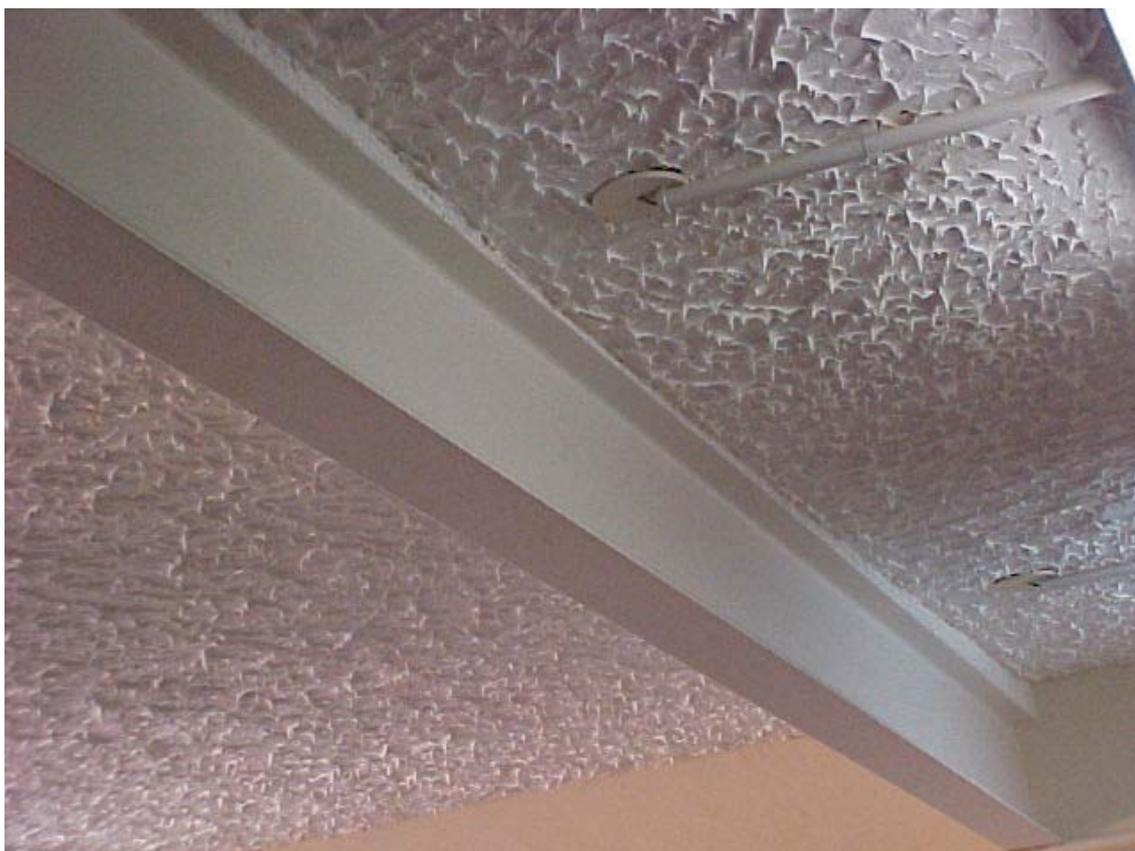
Figura 7.4.1.4 – Viga metálica para conter a deflexão da laje
