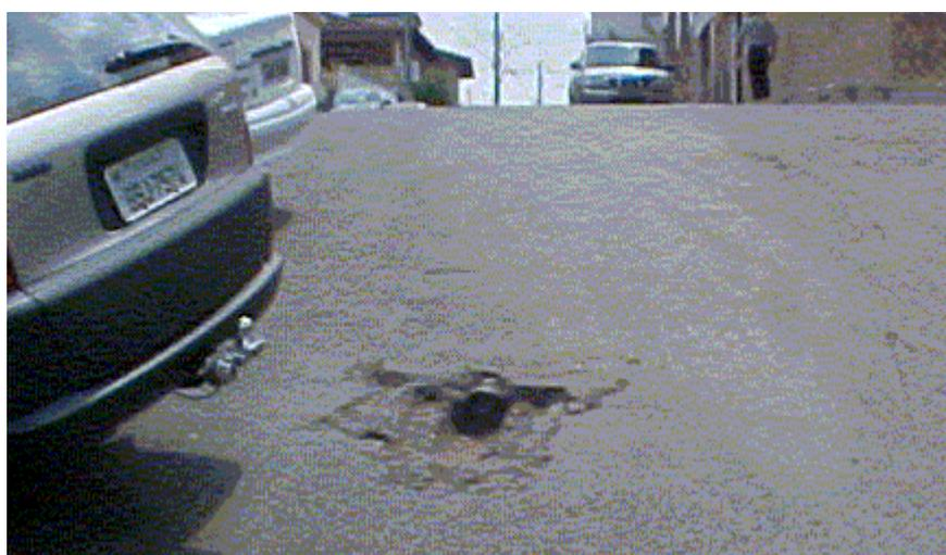
Figura 7.4.1.3 – Extravasador na rede de água pluvial
