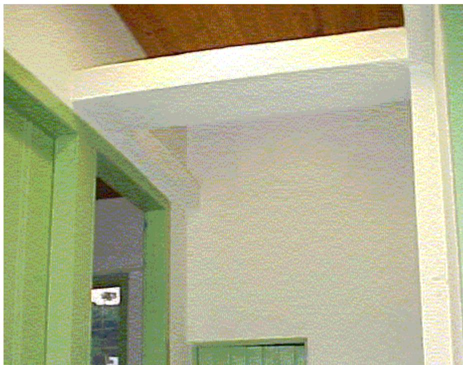
Figura 7.5.1.3 – Detalhe da viga do pórtico e do tirante
