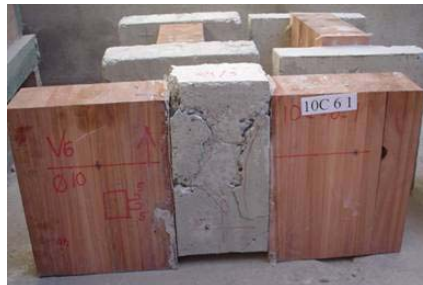
FIGURA 4. 40– Fissuração do concreto nos CPs tipo C
