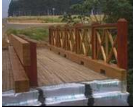
FIGURA 1. 4 – Construção de ponte de MLC – Campus São Carlos - SP
