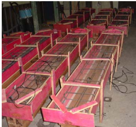
FIGURA 3. 30 – Formas e armaduras das vigas mistas
