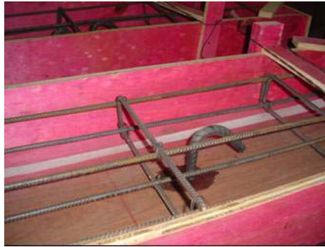
FIGURA 3. 29 – Fixação dos conectores nas vigas mistas
