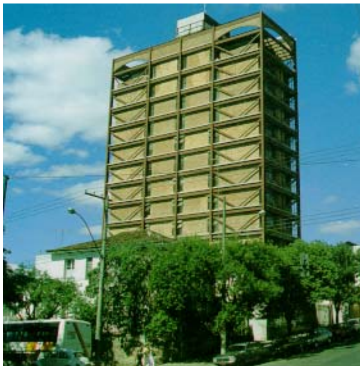
Figura III.39 - Estrutura de aço externa
