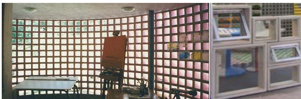
Figura 5.13 - Caixilhos pré-moldados (WINDBLOCK, disponível em www.windblock.com.br ).
