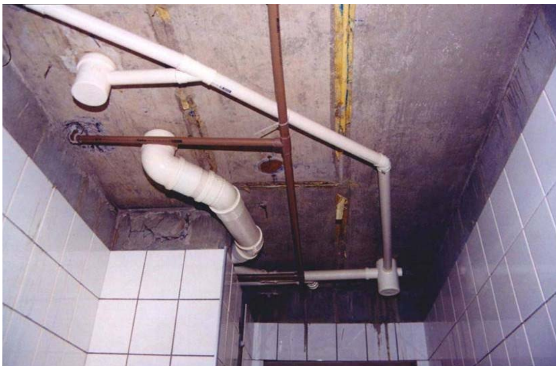
Figura 4.9 - Tubulação hidráulica sob a laje(sistema pex), sem o forro (SANTOS, 2004).
