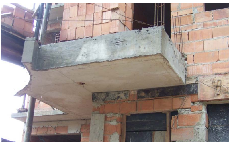
Figura 5.9 - Sacada ancorada em balanço.
