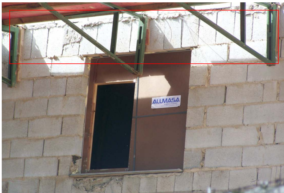
Figura 6.2 - Cinta sob laje em blocos "J" grauteados.
