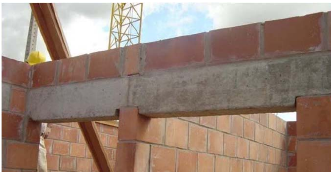
Figura 5.17 - Verga pré-fabricada em concreto armado (SANTOS, 2004).
