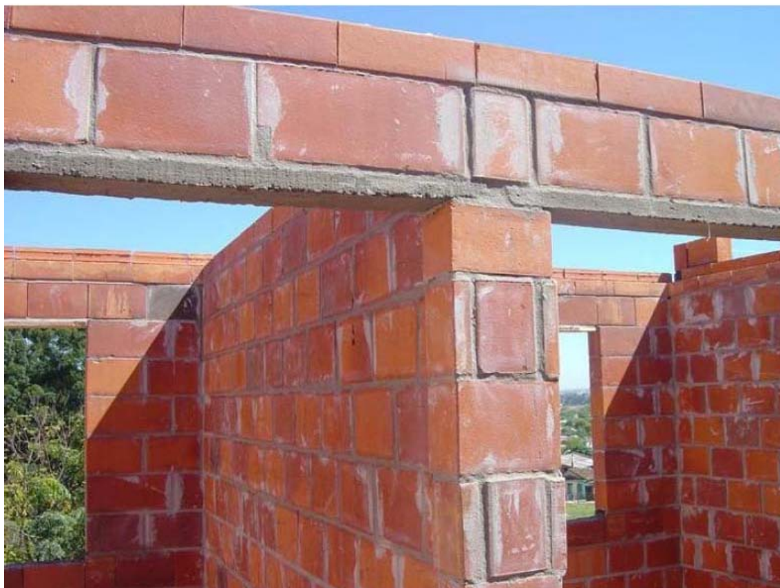
Figura 5.16 - Verga pré-moldada na obra (SANTOS, 2004).
