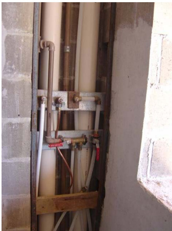
Figura 4.8 - Shaft Hidráulico.
