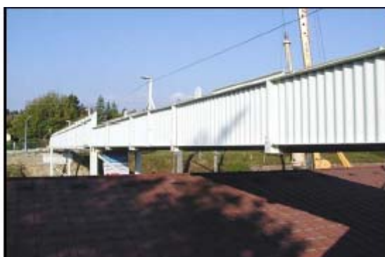
FIGURA 1.8 – Passarela de pedestres em Viena, Áustria [PIMENTA (2008)]
