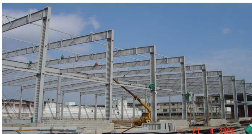
FIGURA 1.9 – Galpão comercial com tesouras e pilares em perfis de almas senoidais Galpão da Cebel fabricado pela Codeme [Codeme Engenharia]
