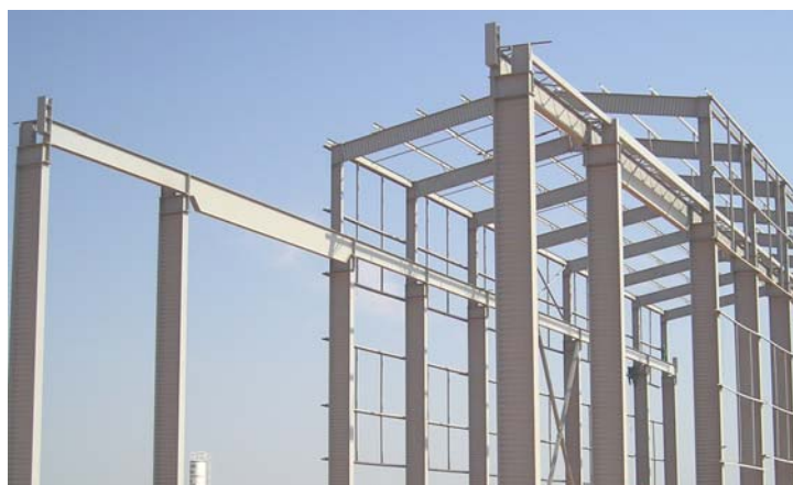
FIGURA 1.11 – Edifício Industrial com vigas em perfis de almas senoidais para processamento de cana de açúcar - João Pinheiro / MG [Codeme Engenharia]
