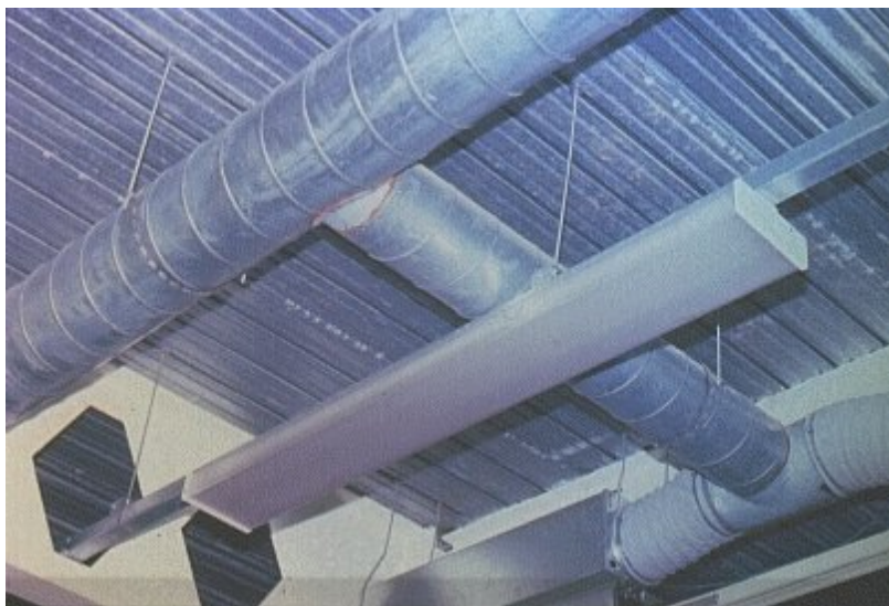
Figura 1.5 – Passagem de dutos pelas aberturas (CORUS, 2009)
