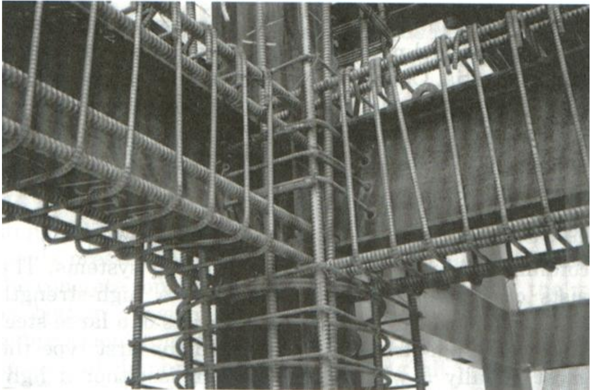
FIGURA 1.1 – Ligação mista viga-pilar resistente a momento fletor [TARANATH (1998)]
