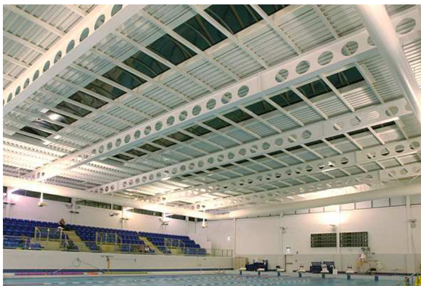
Fulham Broadway Swimming Pool (fonte: www.asdwestok.co.uk , acessado em 10/2010)
