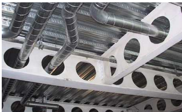
FIGURA 1.3 – Passagem de dutos através das aberturas (fonte: www.asdwestok.co.uk , acessado em 10/2010)
