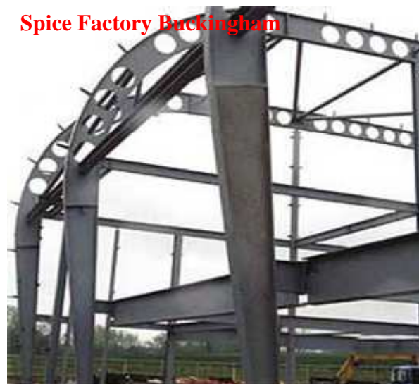
FIGURA 1.9 - Processo de fabricação da viga celular curva e exemplos de aplicação (fonte: www.asdwestok.co.uk , acessado em 10/2010)
