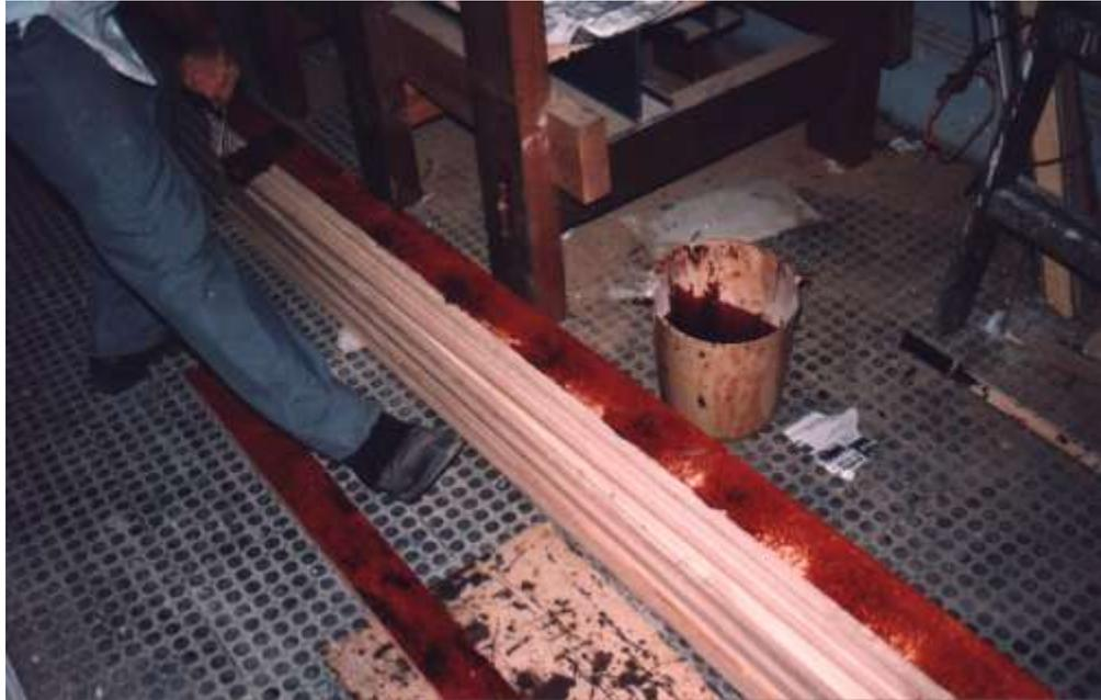
Figura 5.5 – Distribuição da mistura nas lâminas
