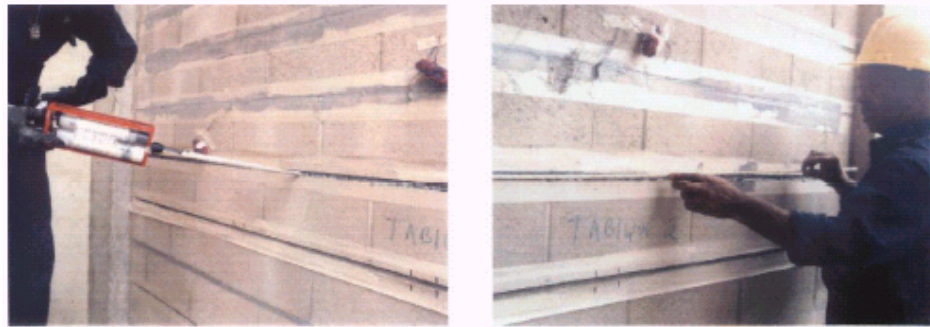
FIGURA 2.25 Reforço estrutural (amostras IM2 e IM3): (a) aplicação da cola à base de epóxi; (b) Instalação das barras com \varnothing 6.25 mm – extraída de TUMIALAN et al. (2003)
