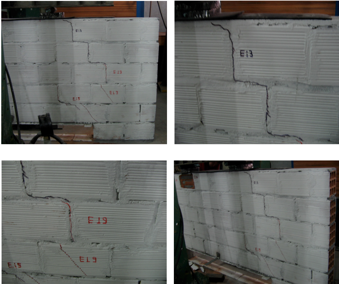
FIGURA 3.29 Evolução das fissuras e modo de ruptura da mini-parede 1 da Série 3.
