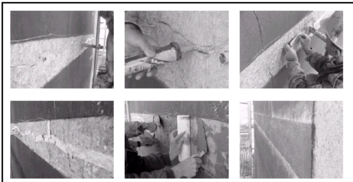
FIGURA 2.11 Execução em obra de recuperação de fissuras “em ponte” (SILVA, 2002).
