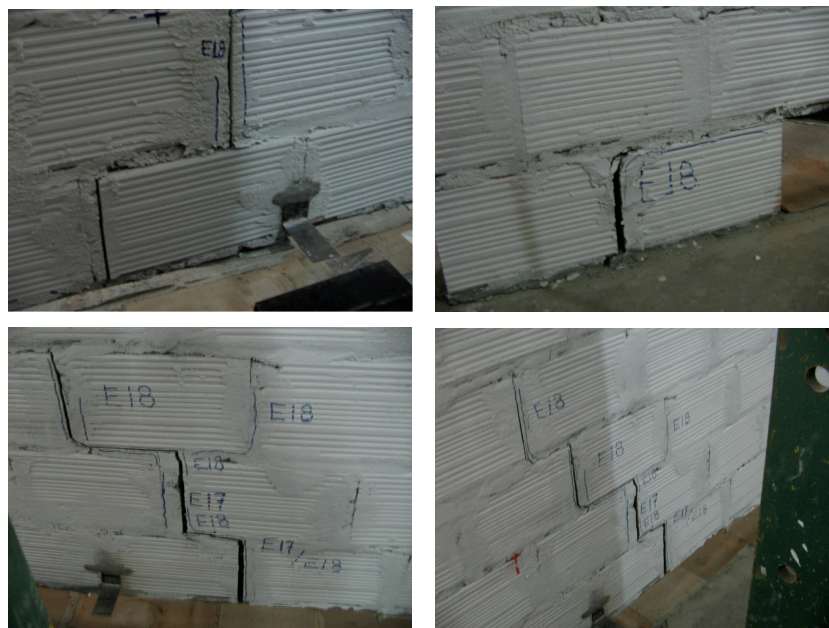
FIGURA 3.34 Detalhes das fissuras da mini-parede 2 da Série 1.
