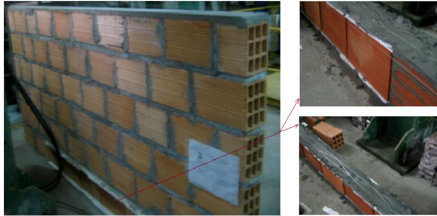
FIGURA 3.16 Detalhe do assentamento dos blocos centrais com isopor para posterior remoção.
