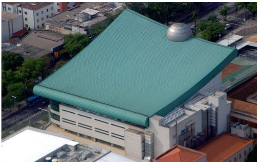
Figura 1.2 – Cobertura contínua com telhas zipadas sem perfurações ou emendas. Centro de eventos Chevrolet Hall em Belo Horizonte/MG.
