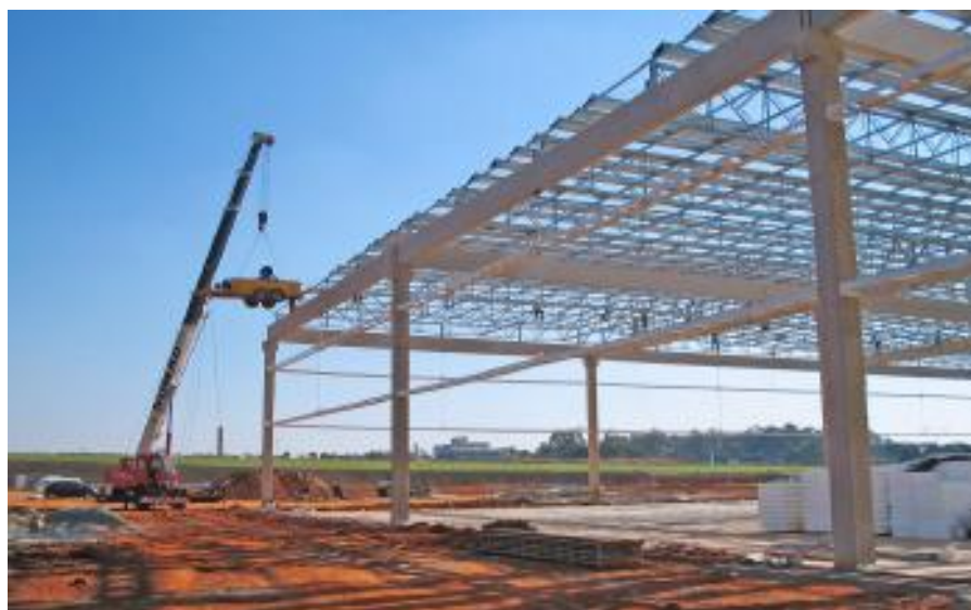
Figura 1.5 – Fabricação das telhas ao nível do telhado.
