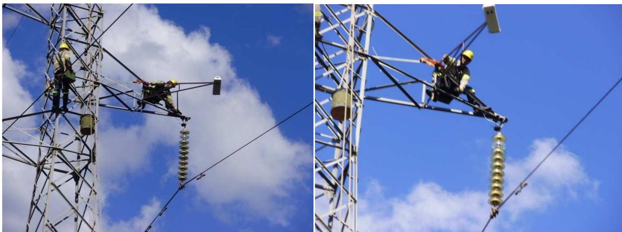
Figura 4.31 – Instalação do sistema de monitoramento do ângulo de balanço (sensor de balanço e câmera).
