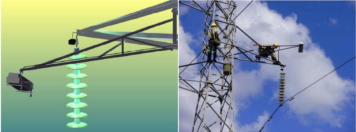
Figura 4.3 – Estrutura auxiliar para suporte da câmera fotográfica.
