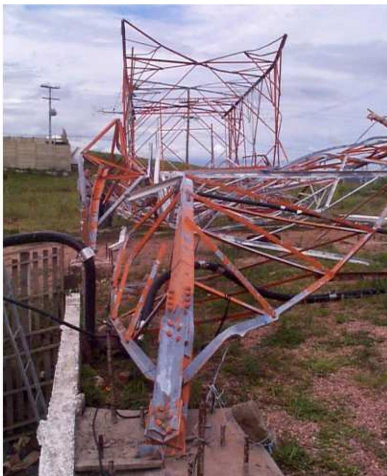
Figura 1.1 – Torre metálica treliçada acidentada na cidade de Porto Alegre (KLEIN, 2004).
