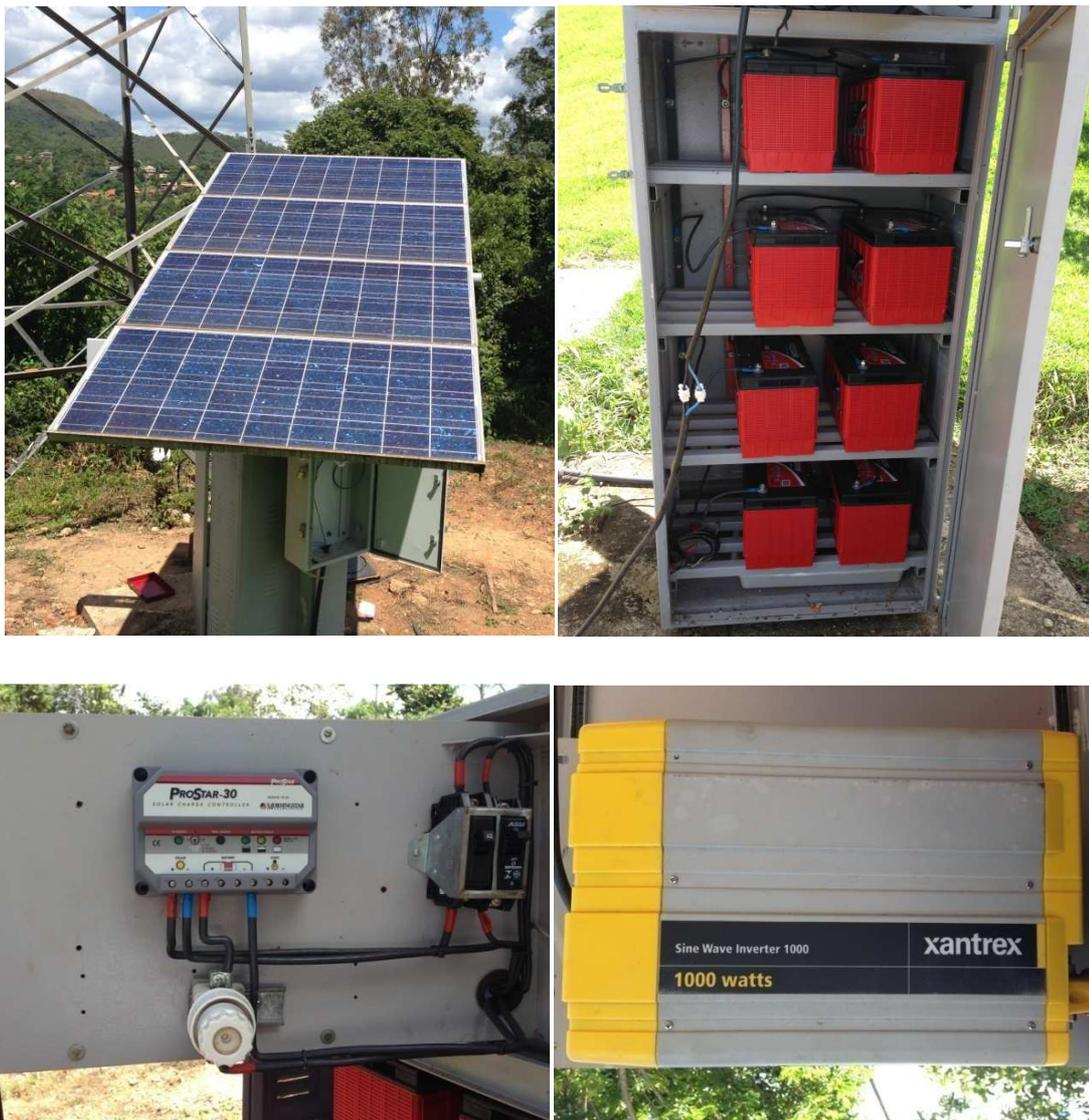
Figura 4.34 – Alimentação do sistema óptico de deformações e temperatura.
