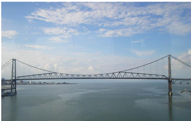
Figura 2.1 – Ponte pênsil Hercílio Luz, Florianópolis (SC)
