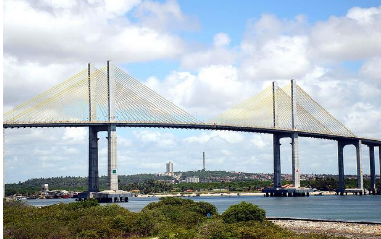
Figura 2.2 – Ponte estaiada Newton Navarro (Ponte de Todos), Natal (RN)
