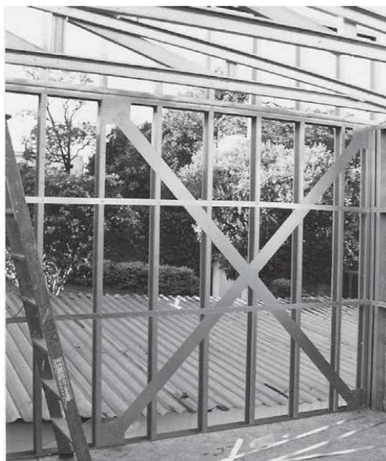
Figura 1.2: Painel com contraventamento em "X" (SANTIAGO *et al.*, 2012).
