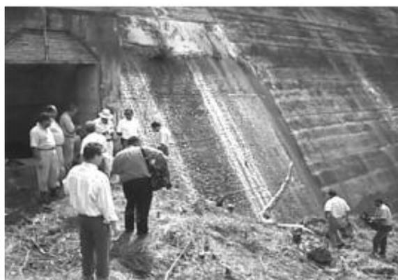
Figura 2.12- Vazamento à jusante da barragem do Rio Descoberto (SOARES et al, 2003).
