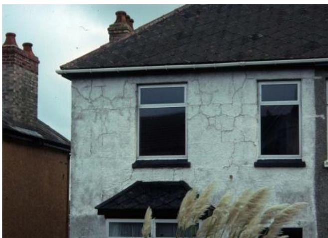
Figura 2.11- Residência em Perranporth (Inglaterra) deteriorada pela presença de sulfeto no agregado, hoje demolida (BROMLEY, 2002).
