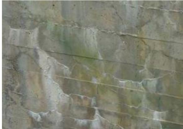
Figura 2.9- Fissuras e manchas na parede da comporta da barragem de Tavascán. (ARAÚJO, 2008 apud GOMIDES 2009)
