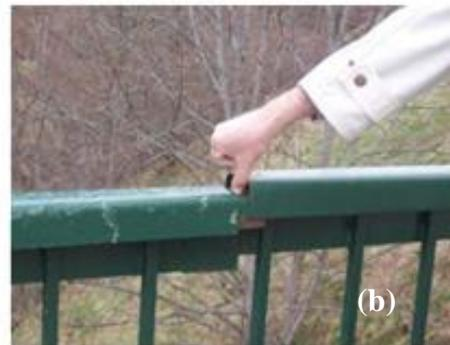
Figura 2.10- Deslocamento estrutural na barragem de Graus. (ARAÚJO, 2008 apud GOMIDES 2009).
