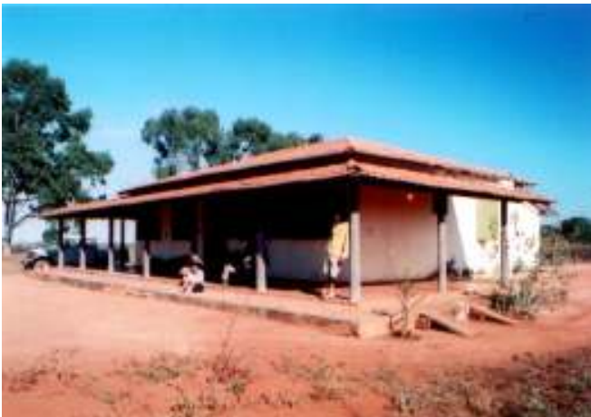
Sede nova da Fazenda Terra Brava, futuro Centro de Apoio à Pesquisa Terra Brava. A edificação é mais recente, sem o uso de estrutura autônoma de madeira e vedações em adobes ou pau-a-pique. Porém a varanda é largamente utilizada. Foto: Vitor Moura
