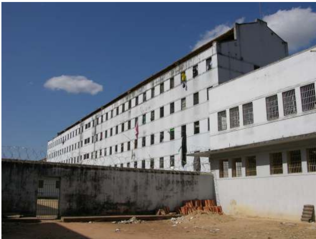
FIGURA 78 – Penitenciária José Maria Alkmim. Vista externa de um dos edifícios que abriga celas individuais. Outro prédio com a mesma configuração e aspecto, fica disposto a aproximadamente 30 m, à esquerda. Em primeiro plano, à esquerda, vê-se o volume, hoje desocupado, onde funcionavam oficinas.
