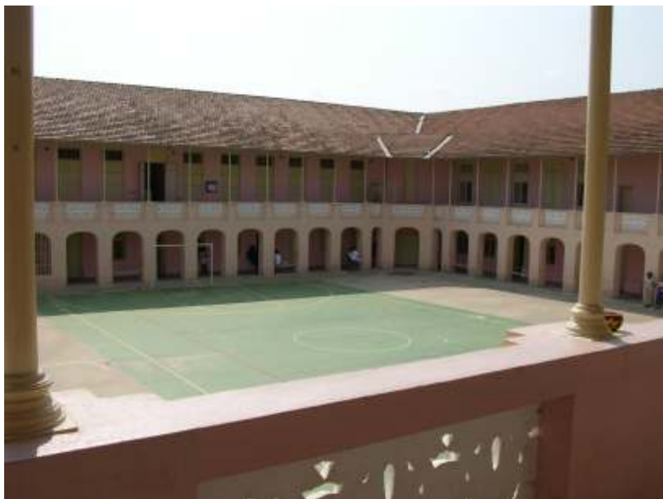
FIGURA 44 - Penitenciária Industrial Estevão Pinto. Vista do pátio interno do prédio original.
