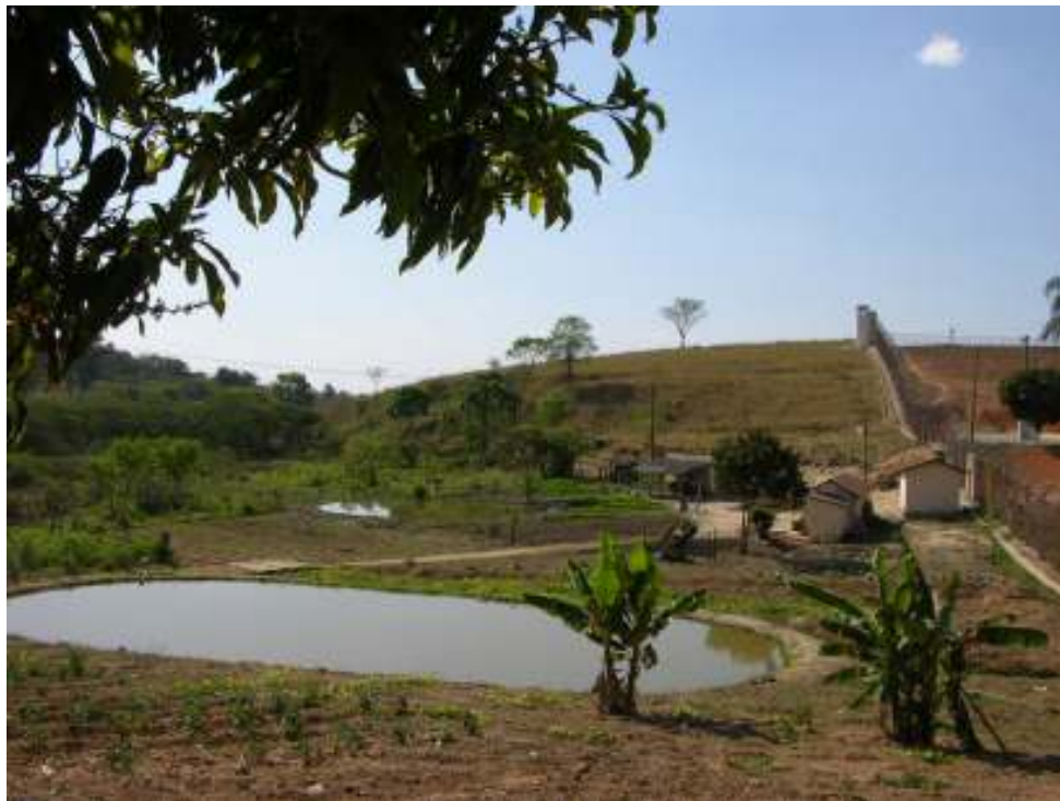
FIGURA 94 - Penitenciária José Abranches Gonçalves. Parte do terreno englobado pelas cercas que delimitam a penitenciária. A aparência é de uma pequena propriedade rural.
