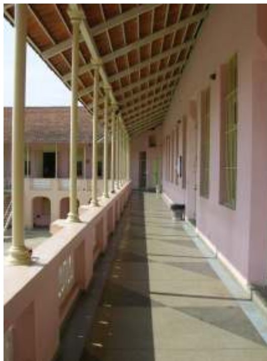
FIGURA 45 - Penitenciária Industrial Estevão Pinto. Varanda de circulação em torno do pátio central.
