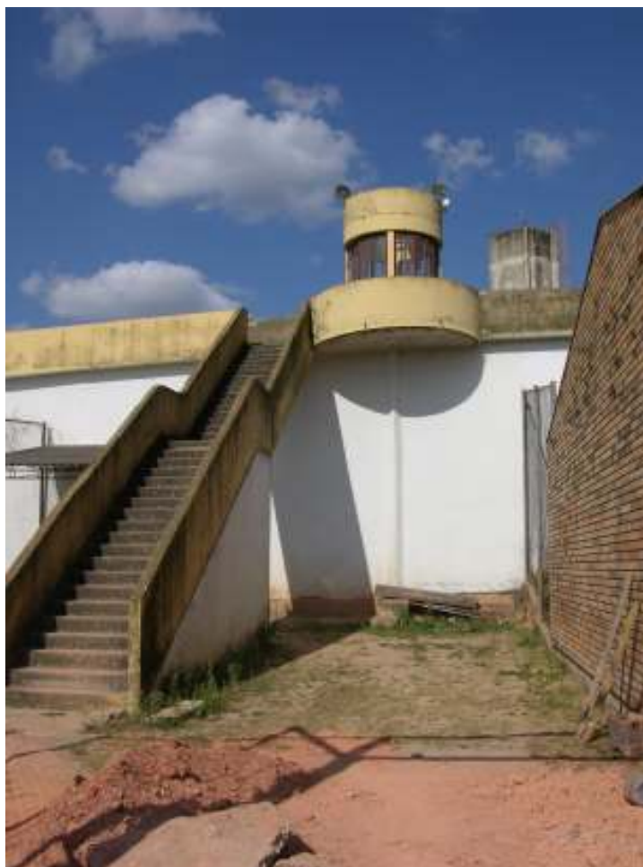
FIGURA 63 – Penitenciária Nelson Hungria. Vista do acesso às guaritas e passarela que as interliga, feito pelo lado de fora da penitenciária, evitando o encontro entre guardas e prisioneiros.
