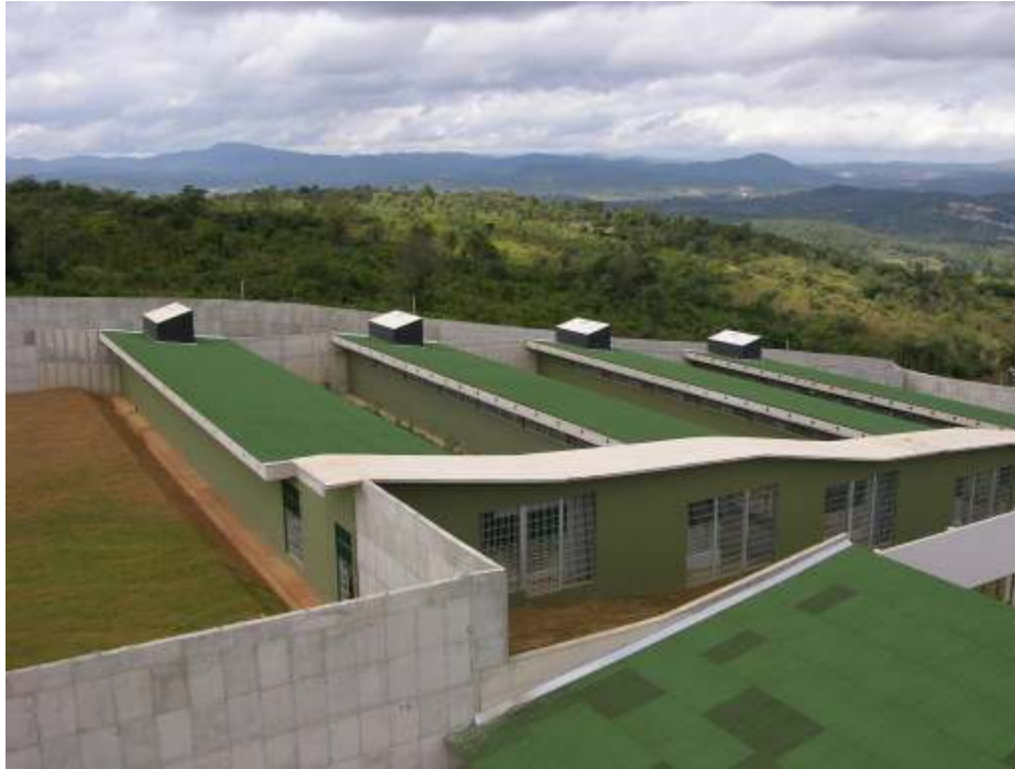
FIGURA 106 – APAC Santa Luzia. Vista dos quatro blocos de celas que integram a unidade de vivência do regime fechado.
