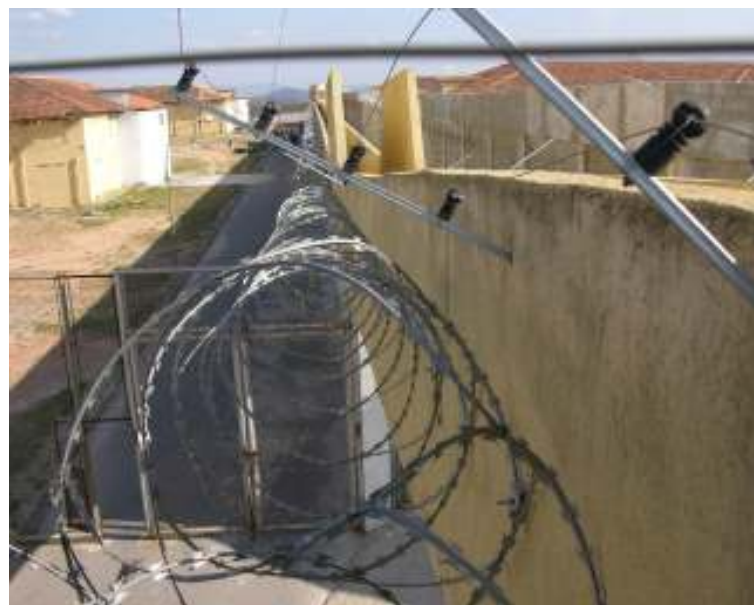
FIGURA 62- Penitenciária Nelson Hungria. Detalhe do coroamento dos muros, onde à concertina se sobrepõem fios eletrificados.
