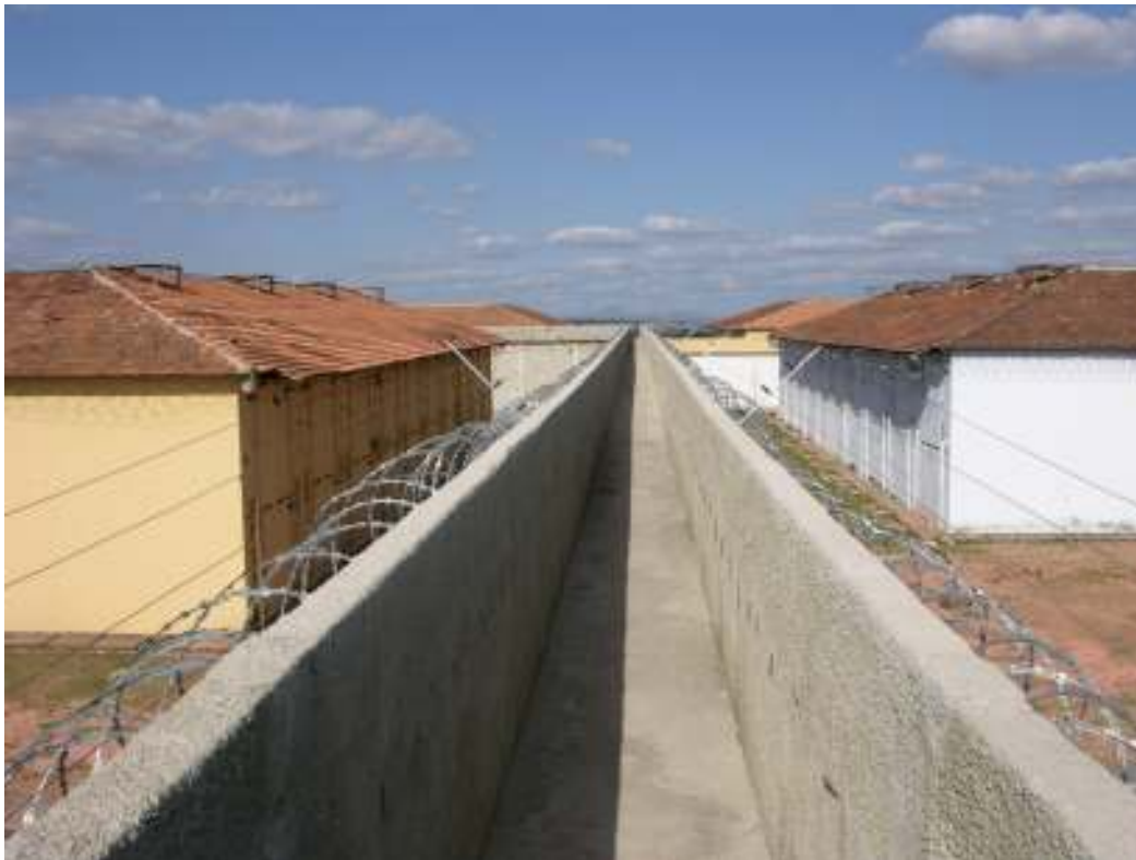
FIGURA 64 – Penitenciária Nelson Hungria. Vista dos pavilhões de celas, a partir da passarela de vigilância que interliga as guaritas. Foto posterior à reforma. Comparar com a FIG. 57.
