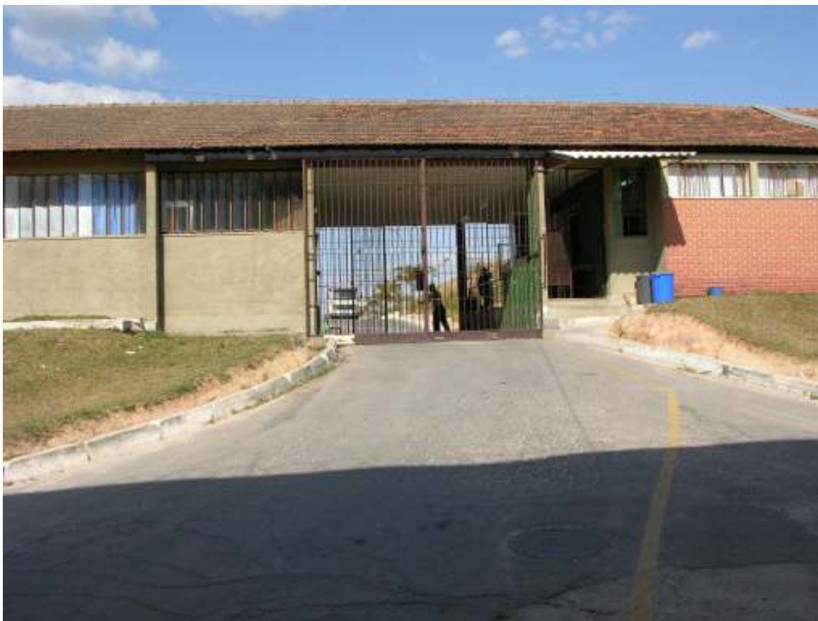
FIGURA 57 – Penitenciária Nelson Hungria. Vista da “gaiola” de controle de veículos e pedestres. Construção localizada intramuros, subsequente ao portão de entrada principal.
