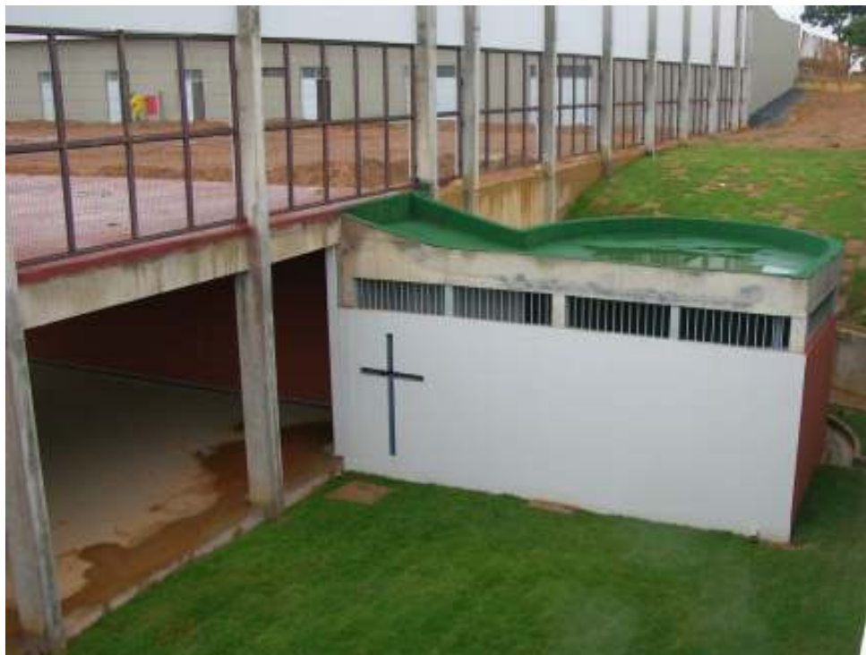
FIGURA 105 - APAC Santa Luzia. Capela do regime fechado. Na lateral esquerda, contíguo à capela, está o refeitório, localizado abaixo do pátio que serve aos blocos de oficinas e apoio do regime fechado.
