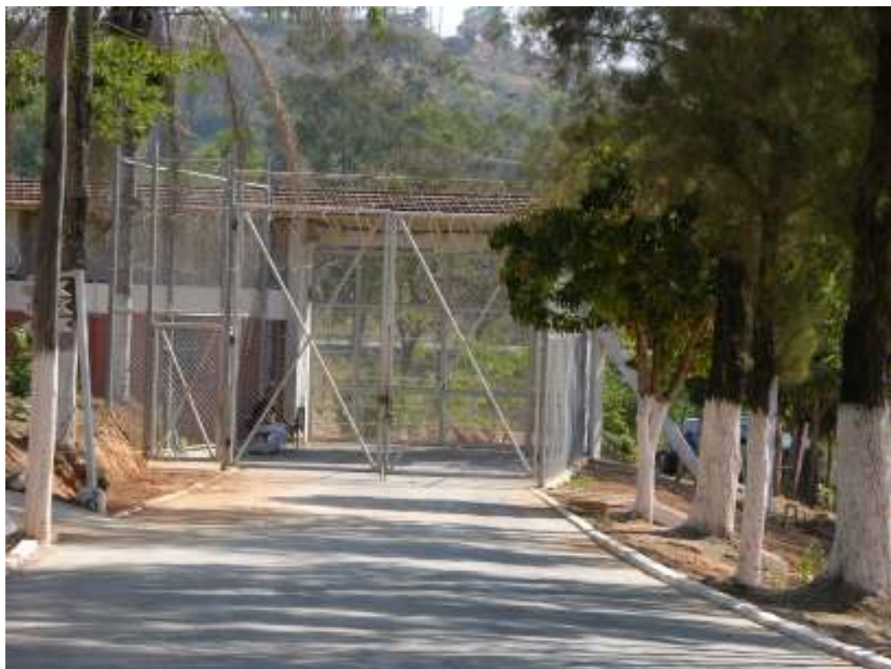
FIGURA 95- Penitenciária José Abranches Gonçalves. Gaiola de controle de veículos. Ao lado, construção para vigias e controle de pedestres.
