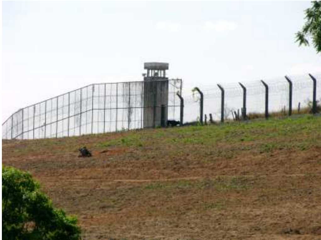
FIGURA 93 – Penitenciária José Abranches Gonçalves. Vista do sistema de fechamento do terreno, com guarita de vigilância ao centro.
