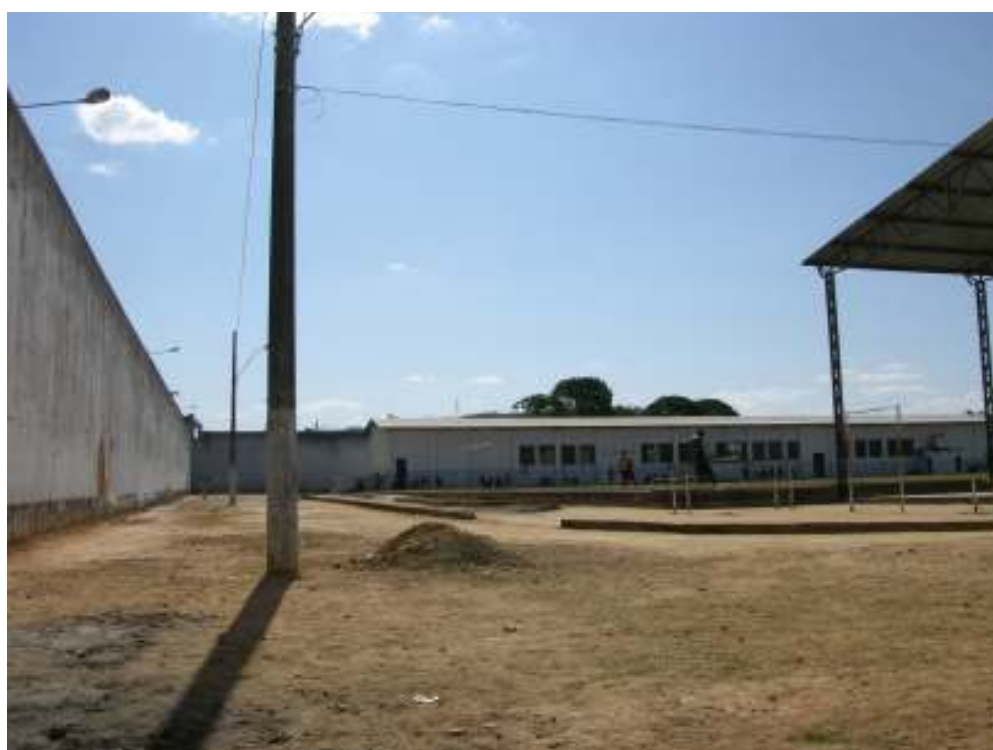
FIGURA 84 – Penitenciária José Maria Alkmin. Espaço em uma das extremidades do terreno, atrás do último pavilhão de celas, onde se localizam o campo de futebol, um barracão estreito e comprido (ao fundo) e alguns aparelhos de ginástica.
