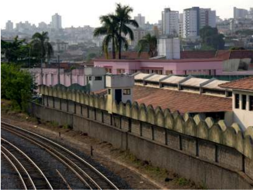
FIGURA 40 – Penitenciária Industrial Estevão Pinto. Em primeiro plano, Centro de Internação Provisória Dom Bosco. No segundo plano (em cor-de-rosa), Penitenciária Industrial Estevão Pinto. Foto tirada da passarela de pedestres que liga o bairro da Floresta ao rio Arrudas, atravessando a ferrovia.
