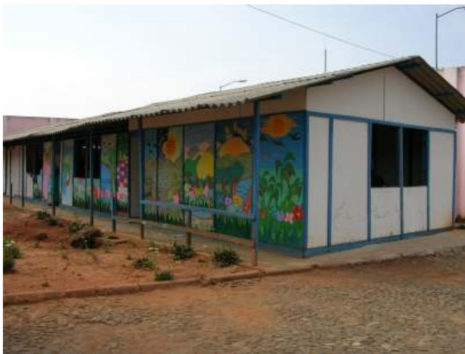
FIGURA 51 - Penitenciária Industrial Estevão Pinto. Barracão de obra reaproveitado para abrigar oficina de artes. Como o barracão deveria ser desmontado após a construção, este não atende nenhuma medida de segurança, sendo posicionado rente ao muro.
