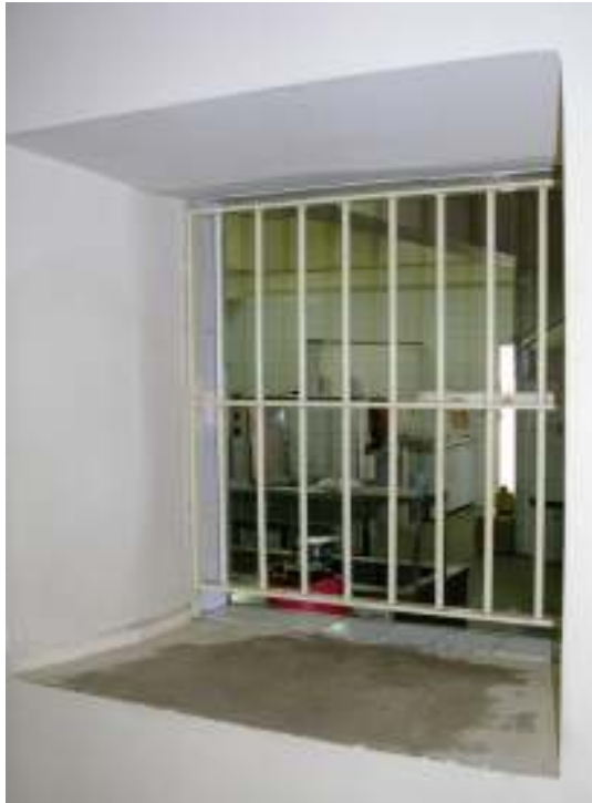
FIGURA 55 – Complexo Penitenciário Feminino Estevão Pinto. Vista do tipo de ligação entre cozinha e refeitórios.
