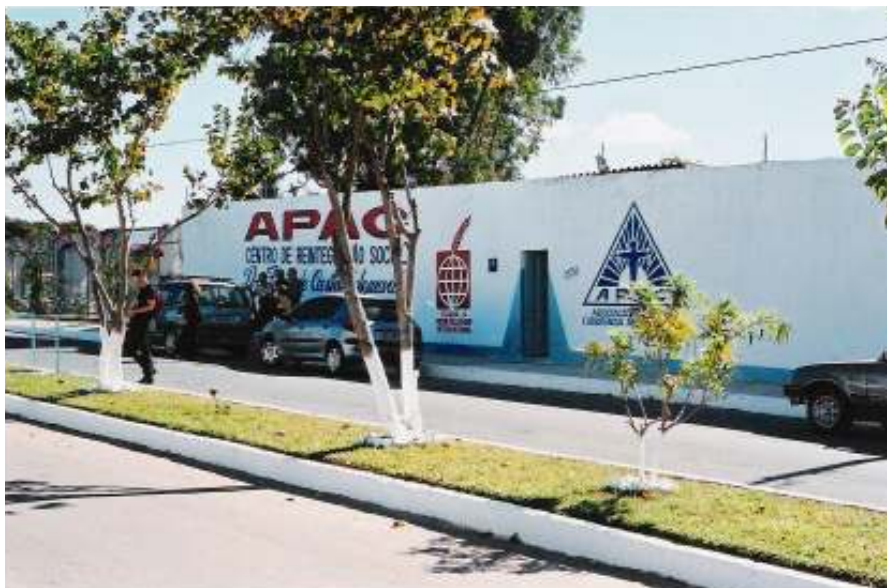
FIGURA 24 – Muro frontal e portão de entrada das instalações da APAC Itaúna. Reparar na ausência dos aparatos de segurança que, geralmente, caracterizam os presídios.
