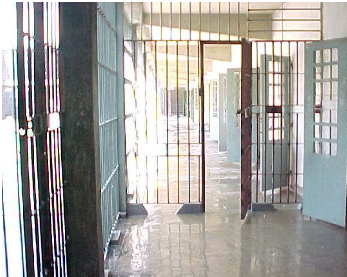
FIGURA 65 – Penitenciaría Nelson Hungria. Vista do interior do pavilhão de celas. À esquerda, uma “gaiola” possibilita o fluxo e a distribuição dos internos, sem contato físico com os funcionários.
