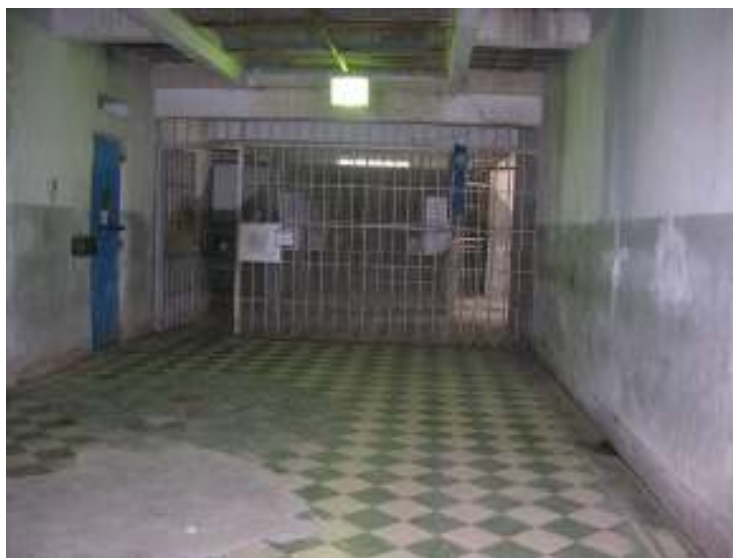
FIGURA 79 – Penitenciária José Maria Alkmim. Vista interna de uma das gaiolas de controle, posicionada no encontro do corredor central com os pavilhões de celas.
