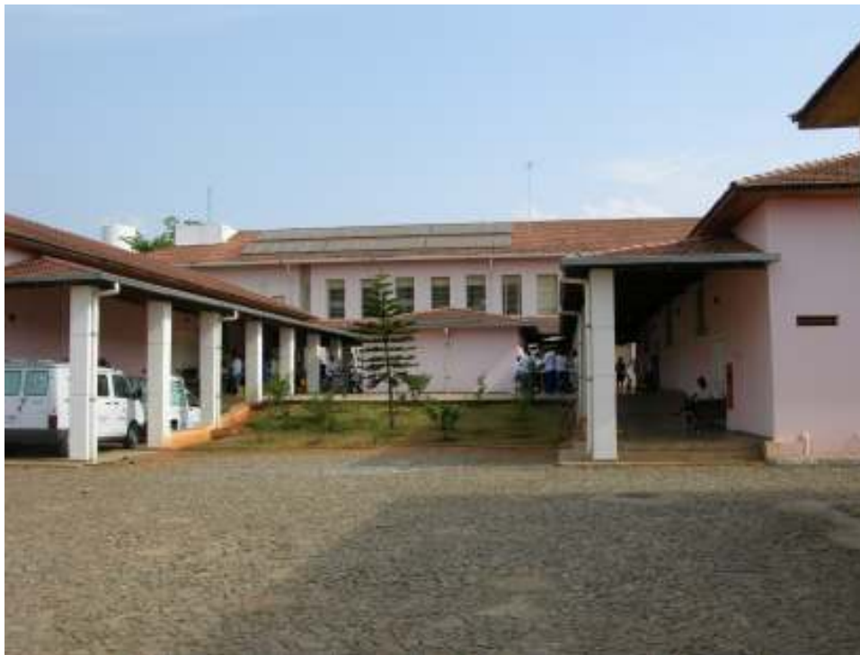
FIGURA 50 - Penitenciária Industrial Estevão Pinto. Em primeiro plano, prédio que abriga oficinas. Ao fundo, edificação principal.
