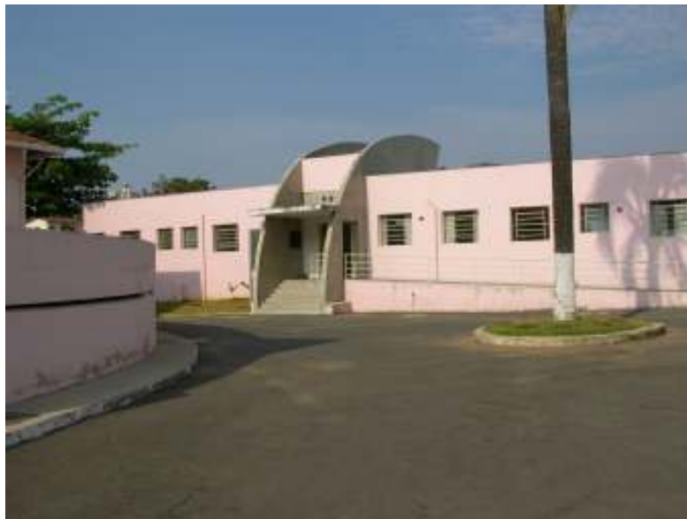
FIGURA 48 – Penitenciária Industrial Estevão Pinto. Edifício que contém um posto médico, uma creche e um albergue. Atentar para o contraste do estilo arquitetônico em relação ao prédio principal.
