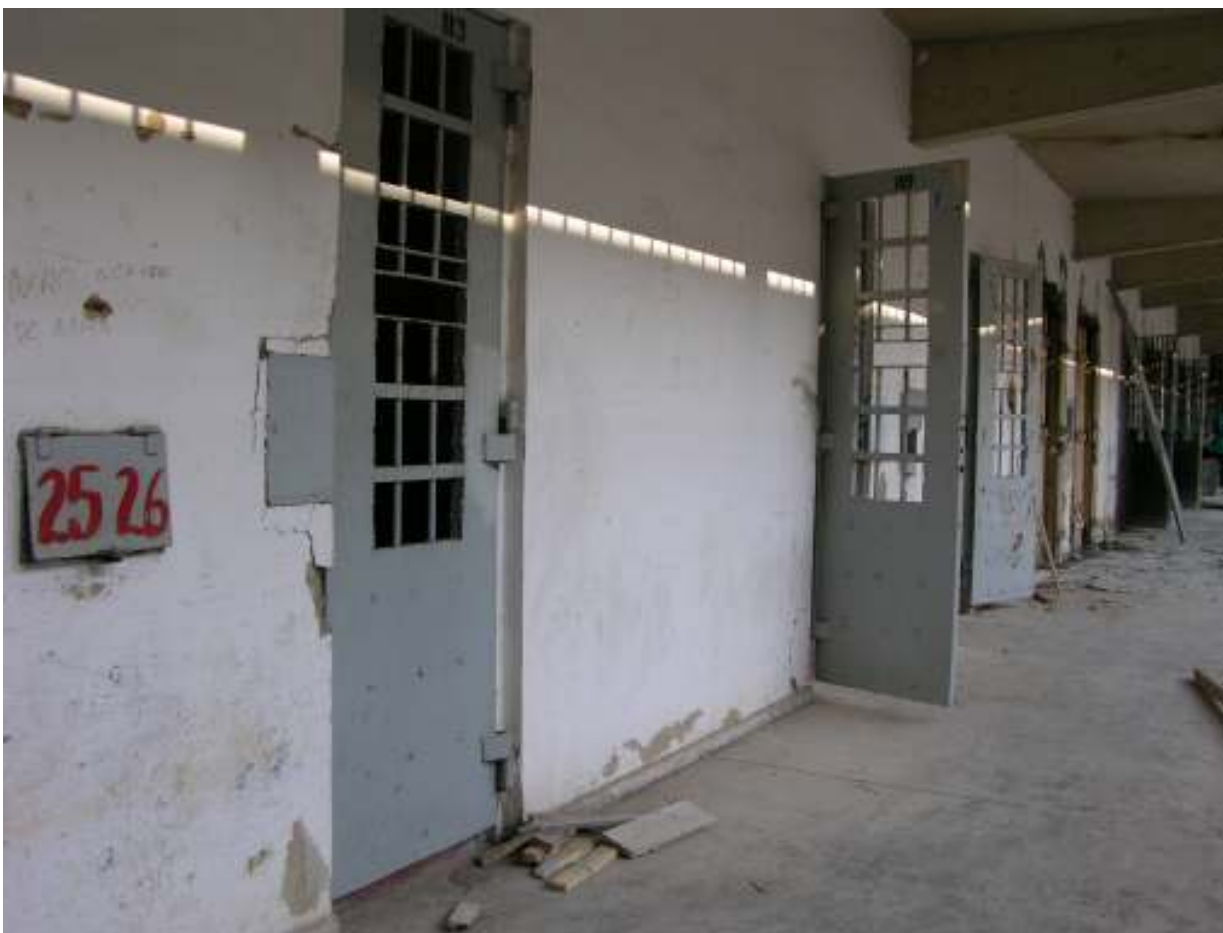
FIGURA 71– Penitenciária Nelson Hungria. Vista do corredor de circulação do pavilhão durante reforma para aumento do número de celas.
