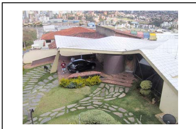
FIGURA 5.52 – Residência de Maria Beatriz – visão panorâmica da região oeste.
