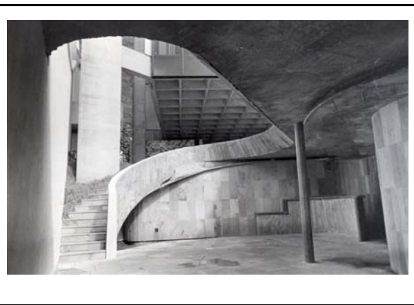
FIGURA 5.43 – Residência Guy Géo – escada de acesso ao depósito.
