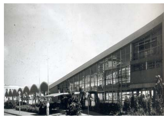
FIGURA 2.11B – Fachada (acesso) da Rodoviária de Londrina, PR, 1950
