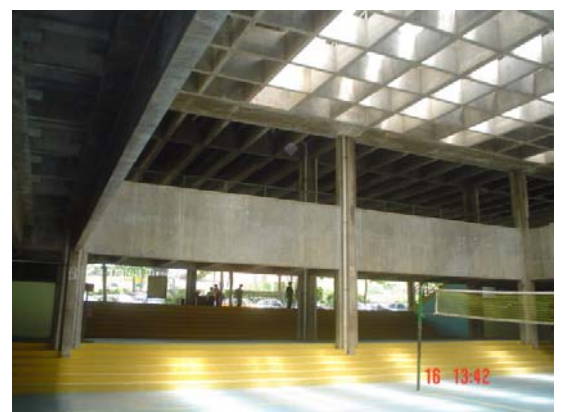
Bloco 3, iluminação zenital
