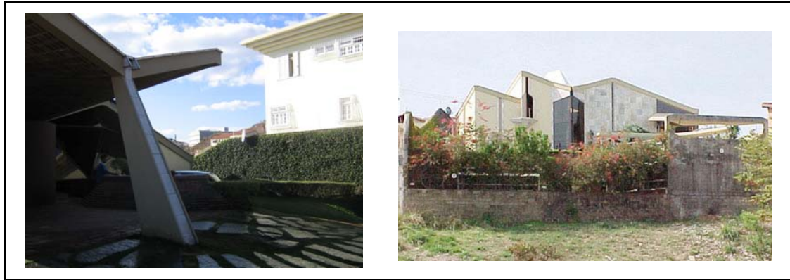
FIGURA 5.81 – Residência Maria Beatriz, fachada sul e noroeste – relação com o entorno..
