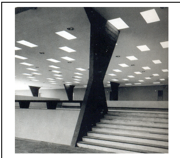
FIGURA 2.14 – Ginásio de Guarulhos (SP), 1960
