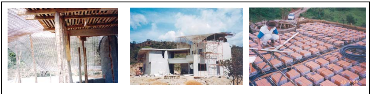
FIGURA 5.90 – Residência Nonada (escoramento, cimbramento e confecção da laje de piso)
