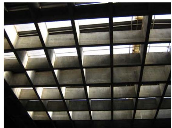
Bloco 3, detalhe da estrutura
