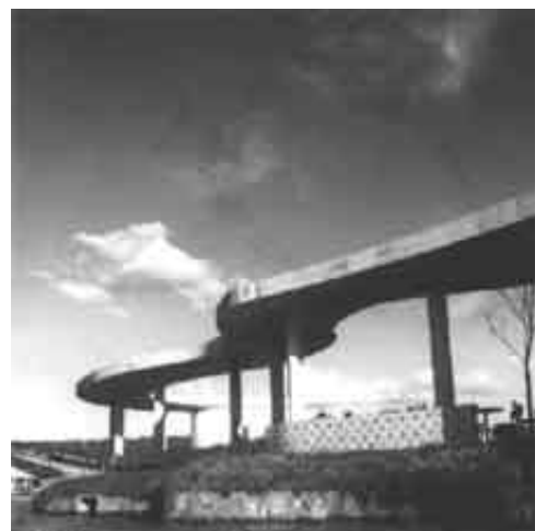
FIGURA 3.39 – Casa do Baile, marquise, 1943
