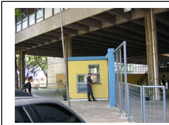
Edificação com gradil e guarita
