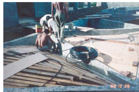
FIGURA 5.56B – Residência de Maria Beatriz – cimbramento para confecção dos conóides.
