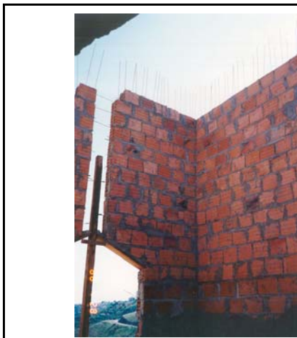
FIGURA 5.54 – Residência de Maria Beatriz – alvenaria cerâmica armada.
