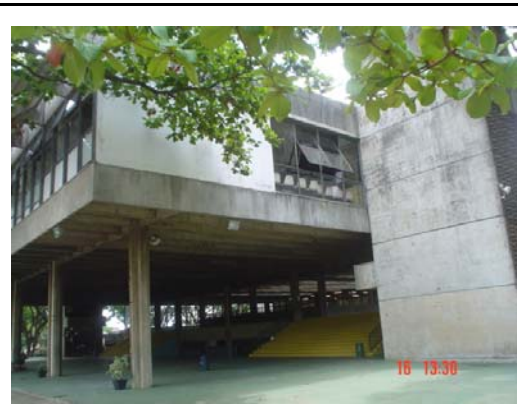
Edificação sem guarita.
