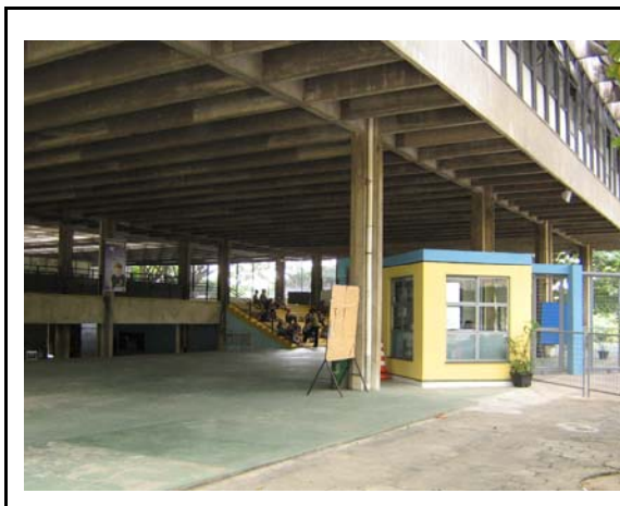
Edificação com gradil e guarita.
