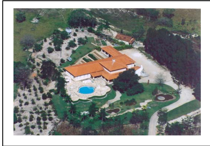
FIGURA 5.95 – Fazenda Esmeraldas (vista aérea, arq. William Abdalla)
