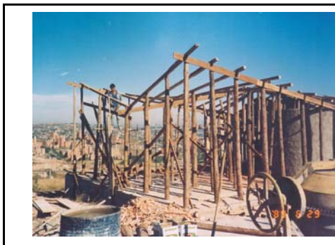
FIGURA 5.56A – Residência de Maria Beatriz – cimbramento para confecção dos conóides.
