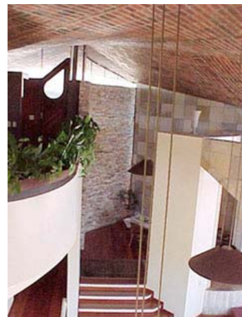
FIGURA 5.55 – Residência de Maria Beatriz – cobertura em parabolóides hiperbólicos.
