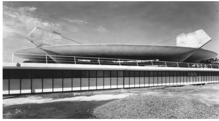
Figura 14 – Embasamento e estrutura da cobertura do ginásio. Foto José Moscardi.
