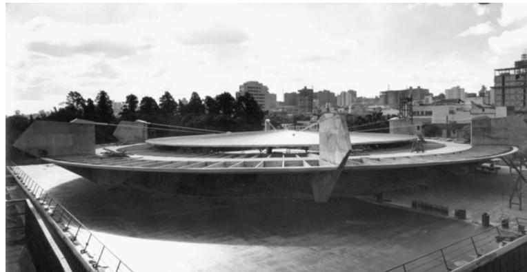
Figura 15 - Cobertura do ginásio. Foto José Moscardi.
