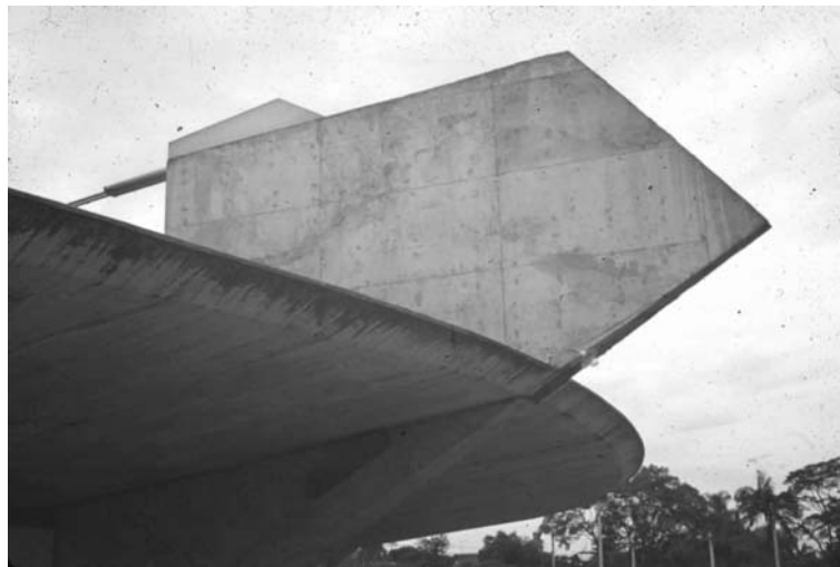
Figura 17 - Detalhe da estrutura da cobertura do ginásio. Foto José Moscardi.
