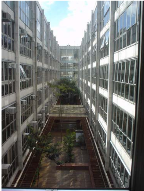
Figura 101 - Aspecto das fachadas internas. Foto do autor.
