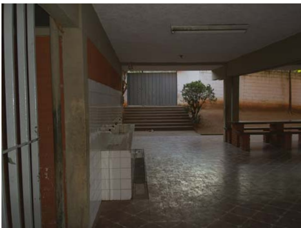
FIGURA 20: Vista do acesso de pedestres à escola a partir do refeitório, à esquerda bebedouros. FONTE: Levant. fotográfico realizado pela autora.
