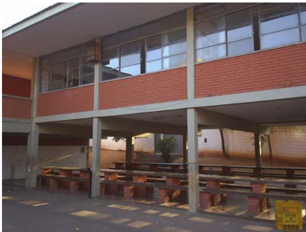
FIGURA 12: Vista bloco 01, abaixo refeitório, acima salas 09 e 10 e ao fundo acesso de pedestres à escola. FONTE: Levant. fotográfico realizado pela autora.
