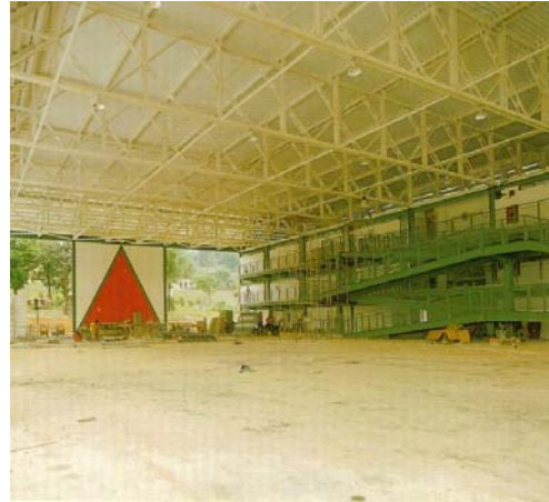
FIGURA 48: Vista interna do varandão e bloco de salas de aula. FONTE: MINAS GERAIS, 1988.
