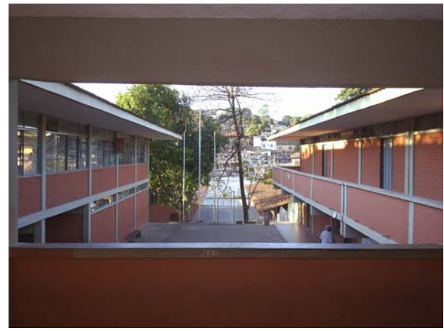
FIGURA 13: Vista geral da escola mostrando no primeiro plano os blocos 01 e 02 e ao fundo 03 e 04. FONTE: Levant. fotográfico realizado pela autora.
