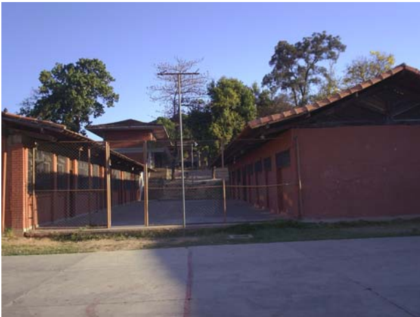
FIGURA 10: Vista geral da escola mostrando no primeiro plano os bl. 03 e 04 e ao fundo os bl. 01 e 02. FONTE: Levant. fotográfico realizado pela autora.
