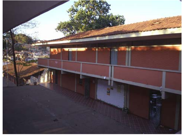
FIGURA 17: Vista circulação do bloco 02, salas 03 e 04 e abaixo salas diretoria e secretaria. FONTE: Levant. fotográfico realizado pela autora.
