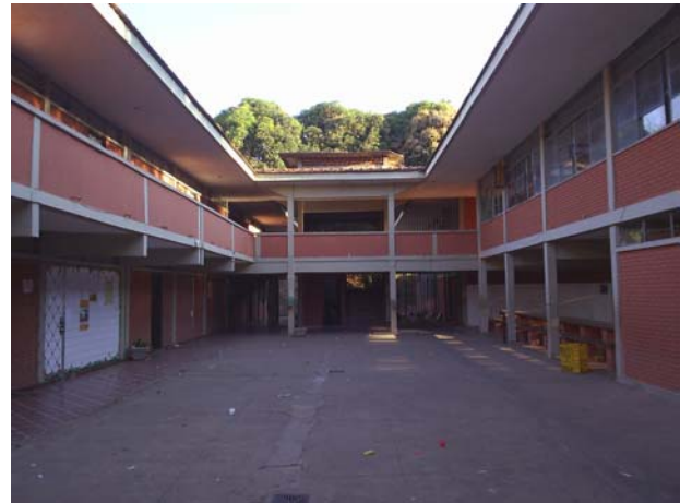
FIGURA 11: Vista do pátio entre os blocos 01 e 02 e ao fundo bloco de circulação vertical. FONTE: Levant. fotográfico realizado pela autora.
