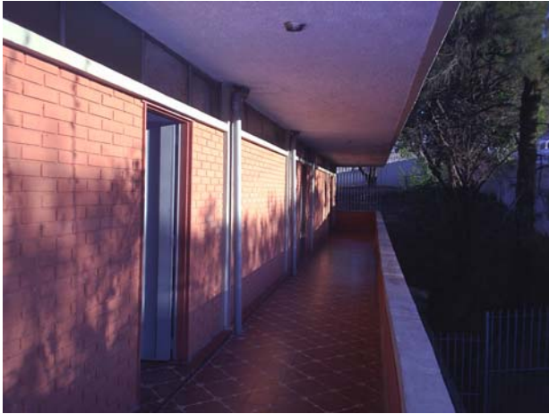
FIGURA 16: Vista circulação do bloco 01, sala da orientadora e salas 11 e 12 ao fundo. FONTE: Levant. fotográfico realizado pela autora.
