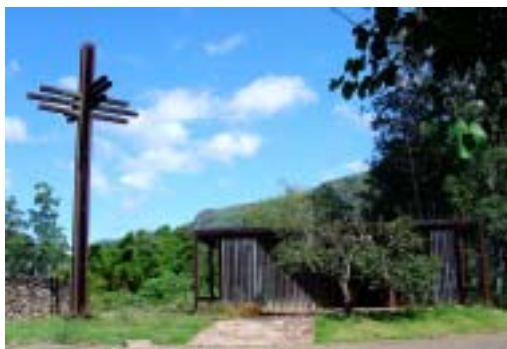
Figura 5.7 – Vista fachada sudeste. Fonte: foto do autor, 2004.
