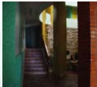
Figura 3.19 – Acesso apartamentos. Fonte: foto do autor, 2004.
