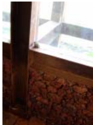
Figura 5.29 - Arremate da estrutura com o embasamento. Fonte: foto do autor, 2004.
