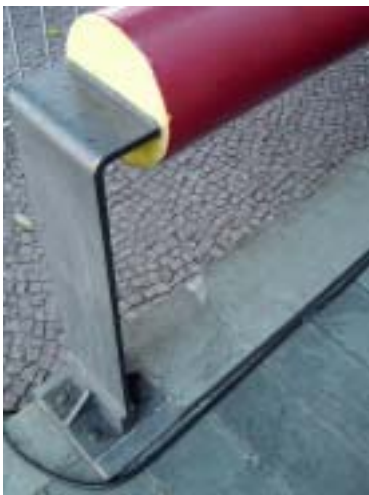
Figura 6.55 – Detalhe do guarda-corpo. Fonte: foto do autor, 2004.
