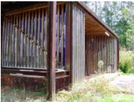
Figura 5.24 – Vista da entrada da Capela. Fonte: foto do autor, 2004.
