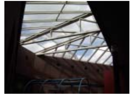
Figura 6.44 – Iluminação zenital do vazio central. Fonte: foto do autor, 2004.
