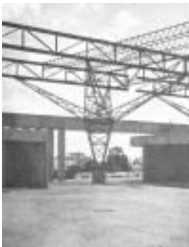
Figura 2.11c - Mercado Distrital do Cruzeiro (1972): detalhe dos pilares metálicos. Fonte: VAO LIVRE. Ano II, n. 18, 15 dez. 1980
