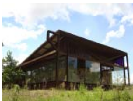
Figura 5.11 - Vista externa. Fonte: foto do autor, 2004.
