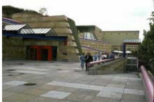
Figura 6.54 – Marquises do Museu de Stuttgart, na Alemanha (1977-84), James Stirling. Fonte: DECLERCQ, S. Architektur van de 20e eeuw. Disponível em: http://users.compaqnet.be/architectuur20/postm/index.htm . Acesso em: 18 de ago./2004.
