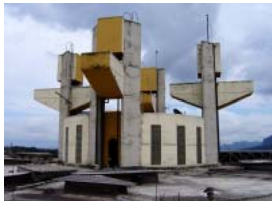
Figura 3.54 – Volumes dos reservatórios superiores. Fonte: foto do autor, 2004.
