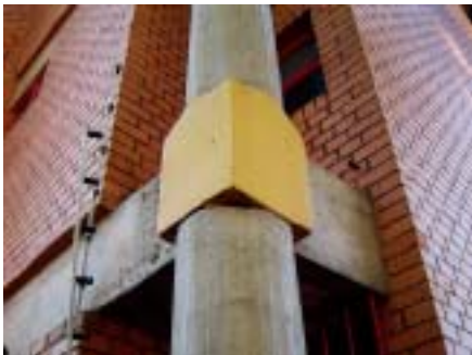
Figura 4.21 - Detalhe pilares externos. Fonte: foto do autor, 2004.
