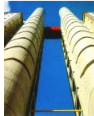
Figura 2.36d – Centro Empresarial Raja Gabaglia (1989-93): foto da caixa de escada. Fonte: PEREIRA, 1991.
