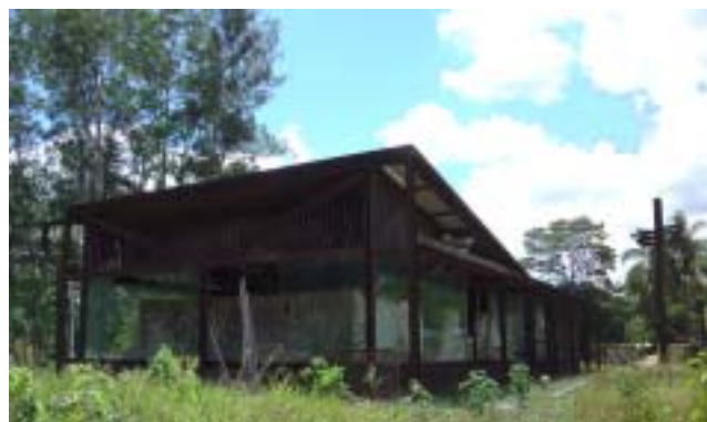
Figura 5.10- Vista externa. Fonte: foto do autor, 2004.
