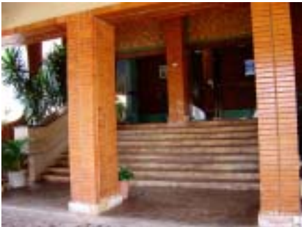
Figura 3.14 – Escadaria de acesso. Fonte: foto do autor, 2004.
