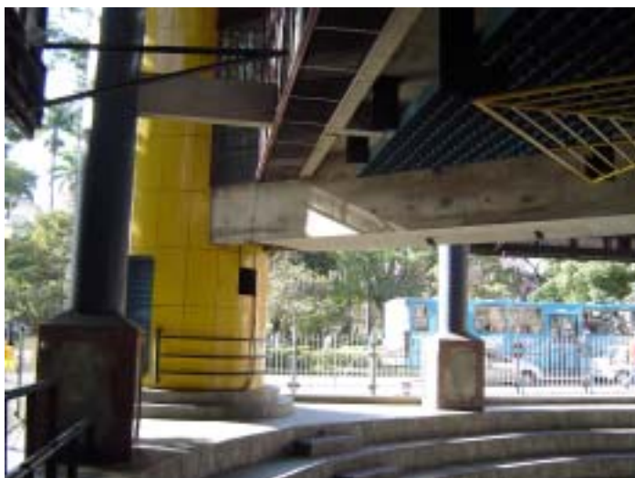
Figura 6.23 – Vista da cabine de projeção. Fonte: foto do autor, 2004.
