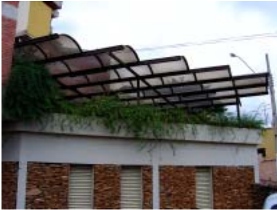
Figura 3.56 – Cobertura sobre o terraço do restaurante. Fonte: foto do autor, 2004.
