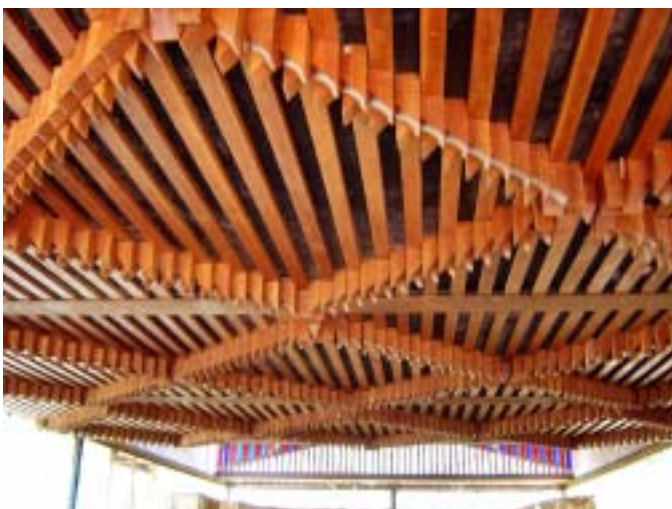
Figura 5.31 - Vista do forro. Fonte: foto do autor, 2004.
