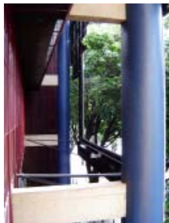
Figura 6.34 – Vista a partir do 1º pavimento. Fonte: foto do autor, 2004.
