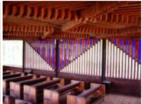
Figura 5.34 – Vista dos painéis de fechamento laterais. Fonte: foto do autor, 2004.
