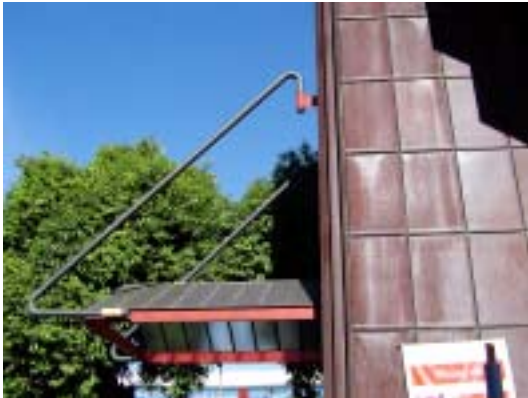
Figura 6.53 – Marquise de entrada do edifício. Fonte: foto do autor, 2004.
