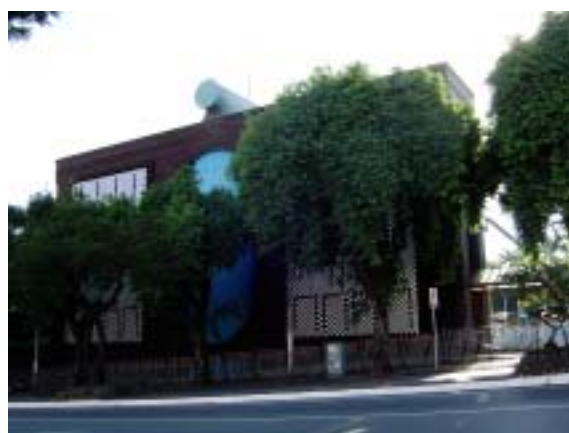
Figura 6.6 – Vista desde a Avenida Bias Fortes. Fonte: foto do autor, 2004
