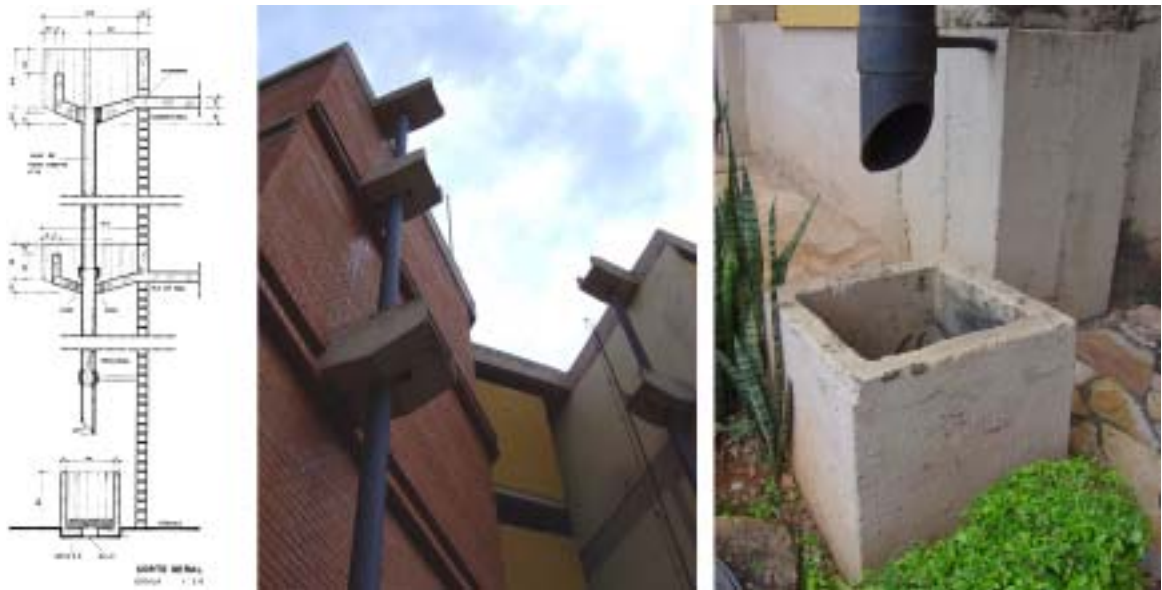
Figura 3.43 – Detalhe das gárgulas.
