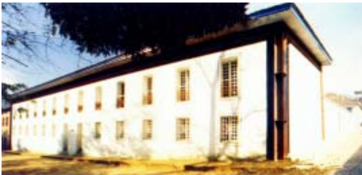
Figura 2.34a – Residência do Arcebispo de Mariana (1982-87): foto. Fonte: PODESTÁ, 2000.
