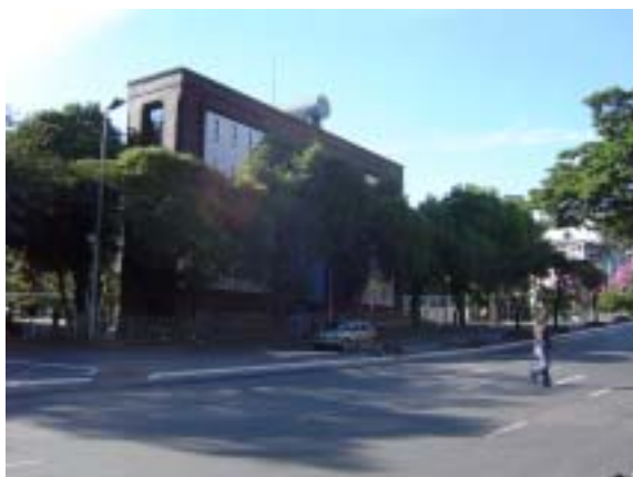
Figura 6.7 – Vista desde a Avenida Bias Fortes. Fonte: foto do autor, 2004
