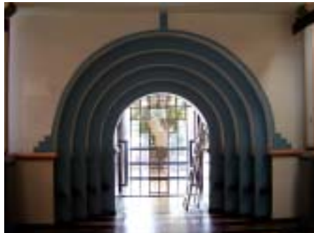
Figura 6.62 – Arcada da extremidade oposta à entrada. Fonte: foto do autor, 2004.
