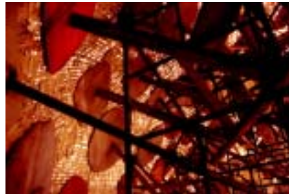
Figura 2.45b – Academia Wanda Bambirra (1997-98): foto do escoramento das formas da casca externa. Fonte: imagem cedida por Jô Vasconcellos.
