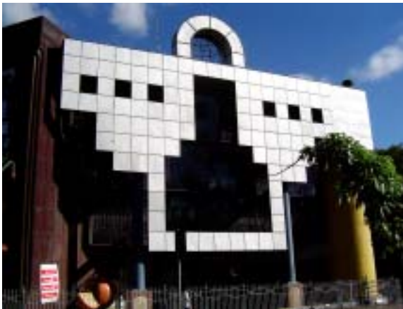
Figura 6.49 – Arco metálico que encima o edifício. Fonte: foto do autor, 2004.
