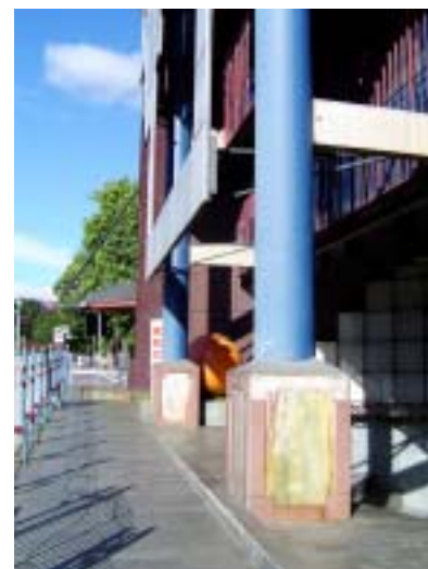
Figura 6.24 – Vista externa. Fonte: foto do autor, 2004.
