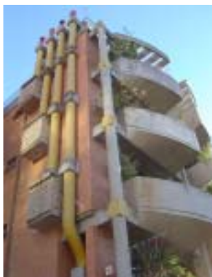
Figura 4.27 – Continuidade dos pilares externos. Fonte: foto do autor, 2004.
