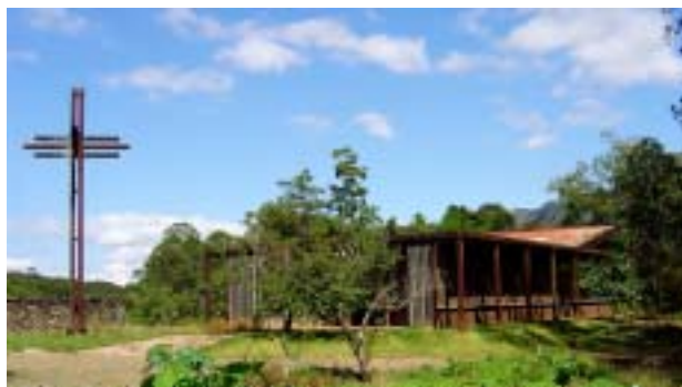
Figura 5.8 – Vista externa. Fonte: foto do autor, 2004.
