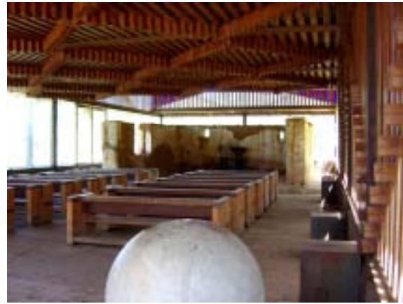
Figura 5.16 – Vista interna. Fonte: foto do autor, 2004.
