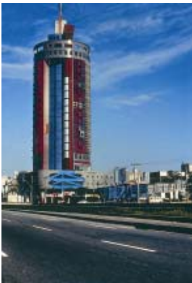
Figura 2.38a – Condomínio Officenter (1989): foto. Fonte: imagem cedida por Jô Vasconcellos.
