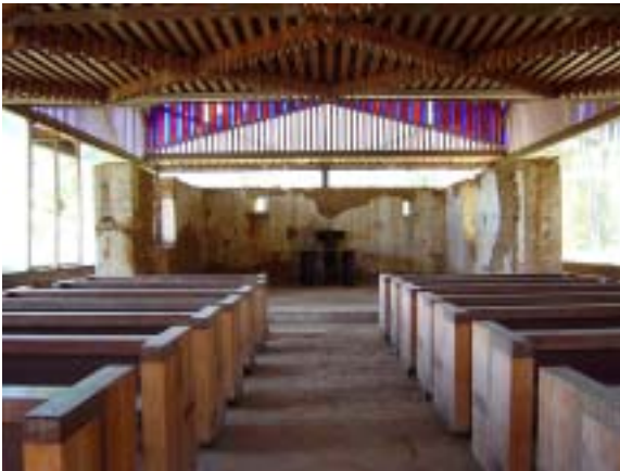
Figura 5.15 – Corredor central. Fonte: foto do autor, 2004.
