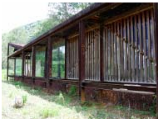
Figura 5.9 – Vista da fachada sudoeste. Fonte: foto do autor, 2004.
