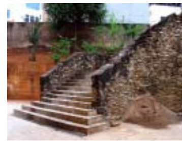
Figura 3.27 – Escada externa. Fonte: foto do autor, 2004.
