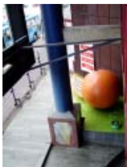
Figura 6.35 – Vista a partir do 1º pavimento. Fonte: foto do autor, 2004.
