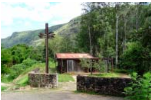
Figura 2.25 – Capela de Santana do Pé do Morro (1978-80): vista externa. Fonte: foto do autor, 2004.
