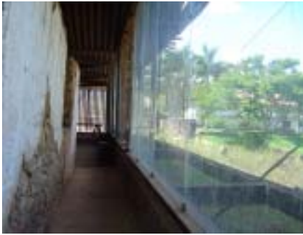
Figura 5.19 – Vista do deambulatório. Fonte: foto do autor, 2004.
