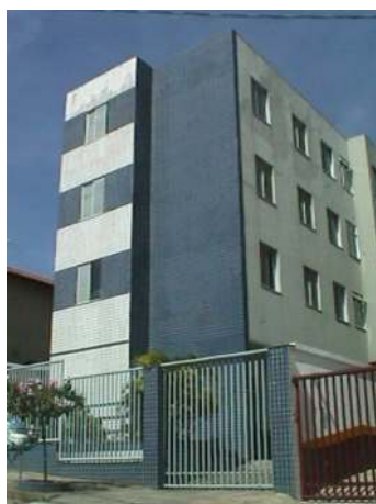
FIGURA 43- Edifício onde o emprego de cores está associado aos diversos planos e volumes que compõem as fachadas.
