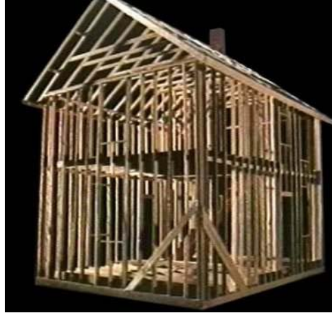
FIGURA 20- Estrutura típica do sistema balloon frame .
