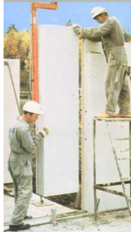
FIGURA 6- Elementos estruturados pré-moldados em concreto celular autoclavado para vedação.
