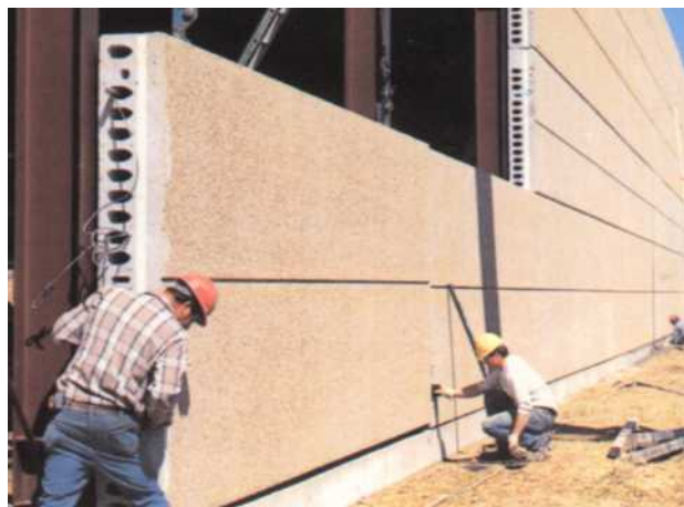
FIGURA 5- Elementos estruturados em concreto pré-moldado para vedação. FONTE- Catálogo “Painéis de Fechamento com Isolamento Termo-acústico”, fabricante Reago.
