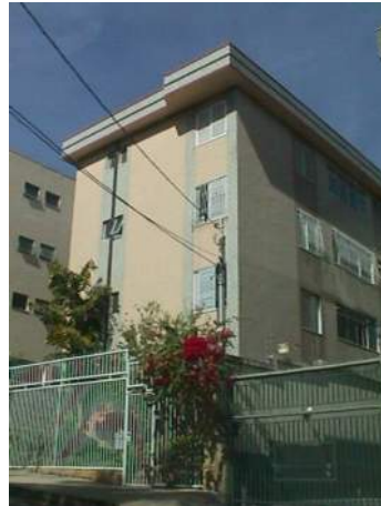
FIGURA 38- Edifício com coroamento em platibanda saliente e frisada.
