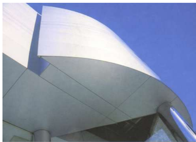
FIGURA 8- Revestimento de fachada em painéis de alumínio.
