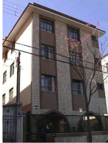
FIGURA 37- Edifício com coroamento em marquise e platibanda.
