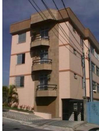
FIGURA 34- Edifício com posicionamento de varandas variável nos diversos pavimentos.
