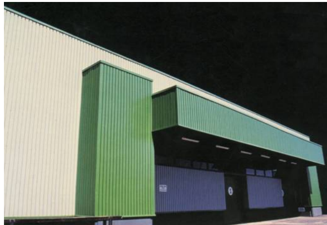
FIGURA 7- Revestimento de fachada em tiras de alumínio.
