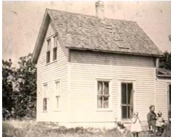
FIGURA 21- Aparência externa de uma residência construída através do sistema balloon frame .
