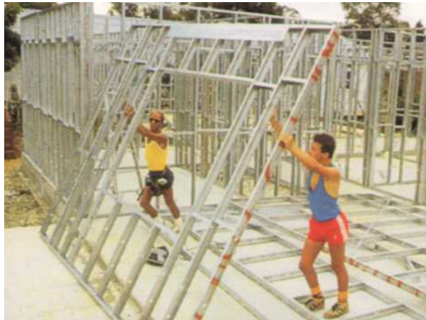
FIGURA 4- Sistema de estrutura para painéis de vedação do tipo wire frame . FONTE- Catálogo “O Futuro Agora”, fabricante Kofar.
