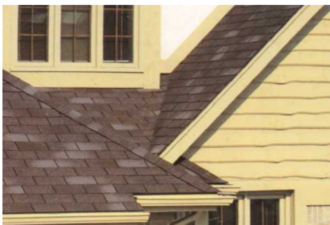
FIGURA 10- Telhas tipo shingle . FONTE- Publicação RS C&C-P-0998, fabricante Owens Corning.
