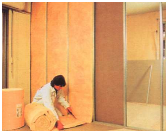
FIGURA 13- Enchimento em placas de lã de rocha para isolamento acústico das paredes construídas em sistema de dry-wall .
