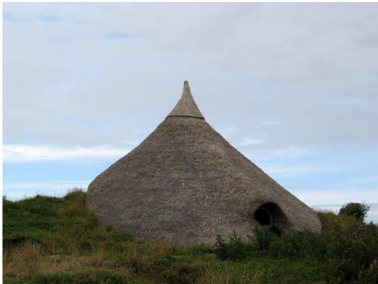
Figura 15 – Construção circular da comunidade de Menter Y Felin Uchaf Fonte: UCHAF, 2005.
