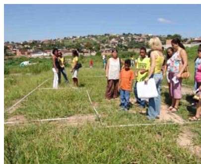
FIGURA 29 - Demarcação da planta do apartamento no terreno. Fonte: arquivo particular da equipe de assessoria técnica do Conjunto Diamante II.
