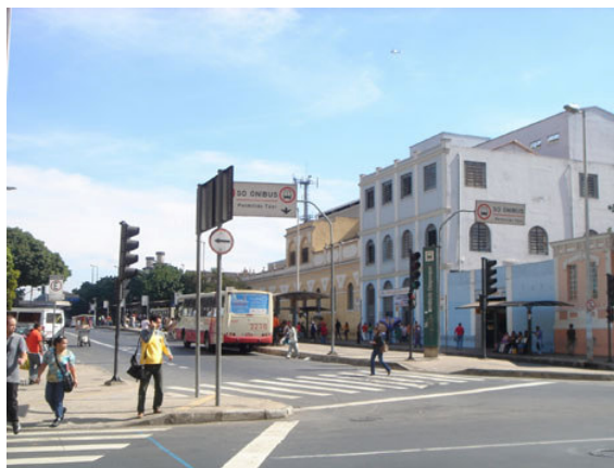
FIG. 19 – Vista parcial da fachada do conjunto tombado e terminal de ônibus da Av. Oiapoque Foto: Selena Lage / julho 2007
