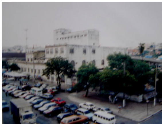
FIG. 2 – Vista parcial da Rua Oiapoque e da Antiga Cervejaria Antártica em 2003
