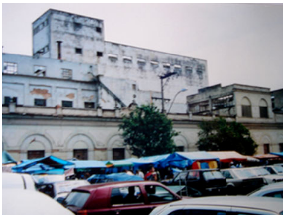
FIG. 1 – Vista parcial da Rua Oiapoque e da Antiga Cervejaria Antártica em 2003
