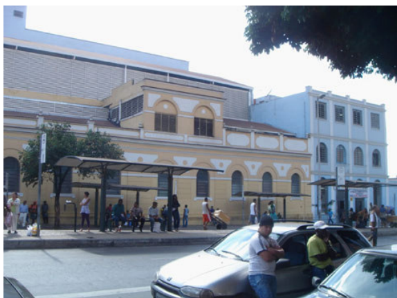
FIG. 18 – Vista parcial da fachada do conjunto tombado e terminal de ônibus da Av. Oiapoque Foto: Selena Lage / julho 2007
