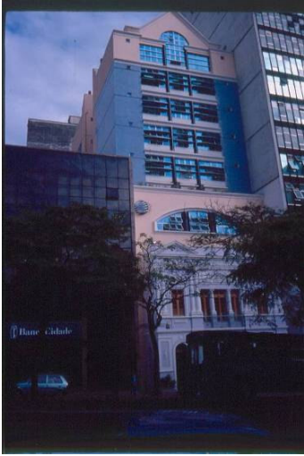
FIGURA 7.8: O antigo casarão (base do prédio) serve como “inspiração” para as novas formas, numa releitura que banaliza a pré-existência. Colégio Promove (Belo Horizonte, MG). Arquiteto: Gabriel Aun (década de 90, FOTO: Flavio Carsalade)
