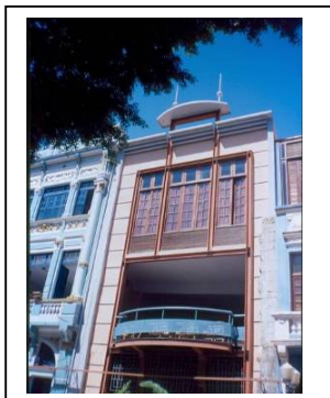
FIGURA 7.15: A estrutura metálica lembra a tradicional estrutura em madeira, realizando uma ponte entre o antigo e o contemporâneo: Edifício comercial no Pólo Bom Jesus (Recife, PE, década de 90) (Foto: Flavio Carsalade)
