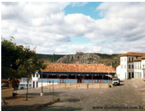
FIGURA 6.14: Restauo da Praça Barão de Guaicuí em Diamantina: O IPHAN sugere a construção de uma quase réplica de coreto anteriormente existente na cidade, com grande dificuldade em aceitar um design mais contemporâneo, embora este esteja localizado em área de renovação visual do contexto. Parece haver um cuidado excessivo com a “historicidade” do lugar, que lhe tire o “ar antigo de foto”. (Foto: Prefeitura de Diamantina)
