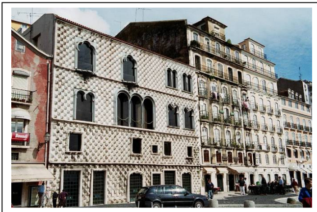
FIGURA 7.18: A reconstrução “científica” da Casa dos Bicos tem todo um aparato de pesquisa, mas chega a uma conclusão esquisita: não é o edifício antigo, nem é um edifício moderno: Casa dos Bicos, Lisboa (Fonte: Internet)
