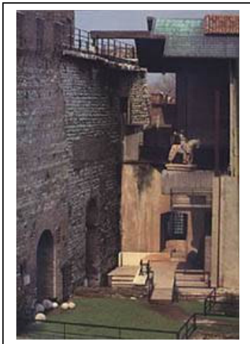
FIGURA 7.24: A intervenção no Castelvecchio Museum (Verona, Itália) do Arquiteto Carlo Scarpa, 1956, recria a Arquitetura mas conserva e distingue com clareza a pré-existência. (Fonte: www.studiocleo.com/gallery )
