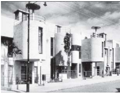
FIGURA 33- Casas da Alameda Lorena.
