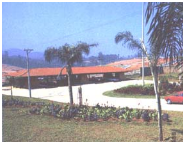
FIGURA 55- Portaria do Residencial 1 - fase final das obras de construção, 1975.
