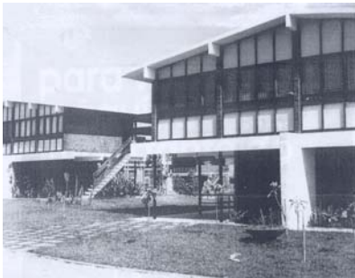
FIGURA 39- Casas geminadas, construídas sob pilotis.
