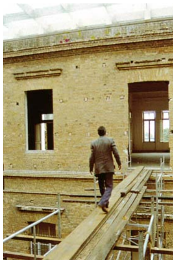
FIGURA 40 – Construção e instalação das passarelas. Fonte: ARAUJO, 2002, p. 60.
