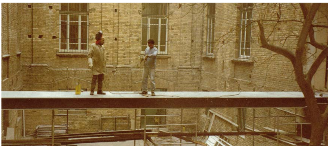
FIGURA 42 – Construção e instalação das passarelas. Fonte: ARAUJO, 2002, p. 61.
