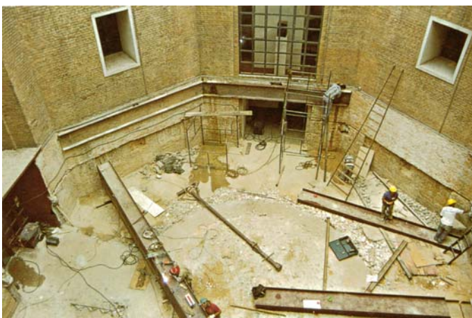
FIGURA 58 – Construção da cobertura do auditório (1996). Fonte: ARAUJO, 2002, p. 90.
