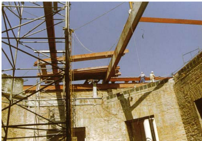
FIGURA 50 – Construção e instalação da nova cobertura (1997). Fonte: ARAUJO, 2002, p. 78.
