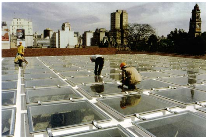
FIGURA 54 – Construção e instalação da nova cobertura (1997). Fonte: ARAUJO, 2002, p. 80.
