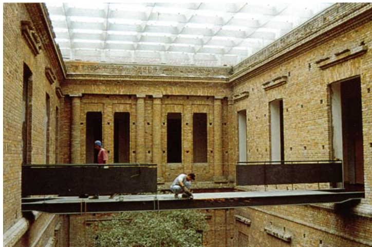
FIGURA 44 - Construção e instalação das passarelas. Fonte: ARAUJO, 2002, p. 62.
