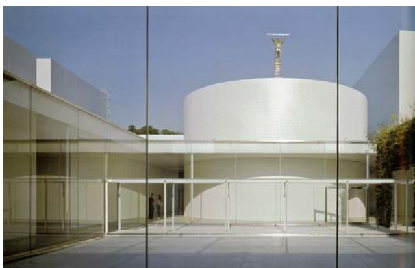
FIGURA 163 – Vista do pátio.
