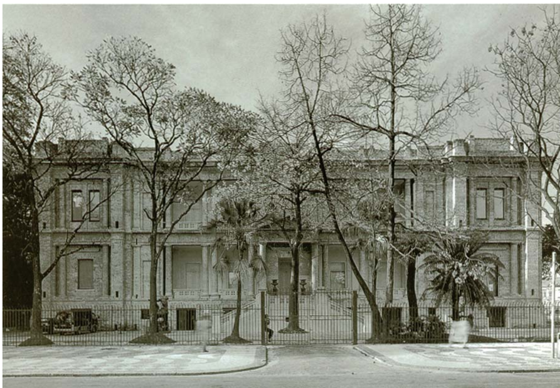
FIGURA 21 – Vista da nova entrada junto à Estação da Luz
