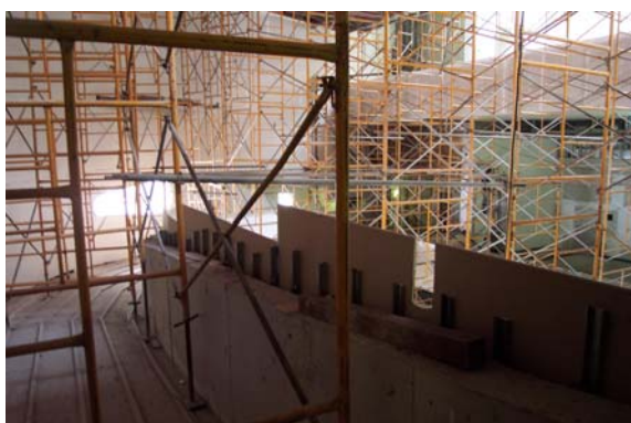
FIGURA 103 - Execução do revestimento interno em painéis de gesso acartonado (25/06/07). Fonte: Arquivo particular da autora.
