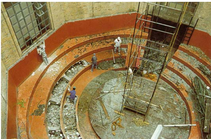
FIGURA 57 – Desmontagem do teatro de arena no piso térreo do octógono (1996). Fonte: ARAUJO, 2002, p. 90.
