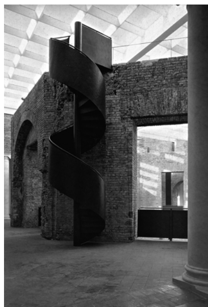
FIGURA 32 – Vista da escada de serviço. Fonte: ARAUJO, 2002, p. 101.
