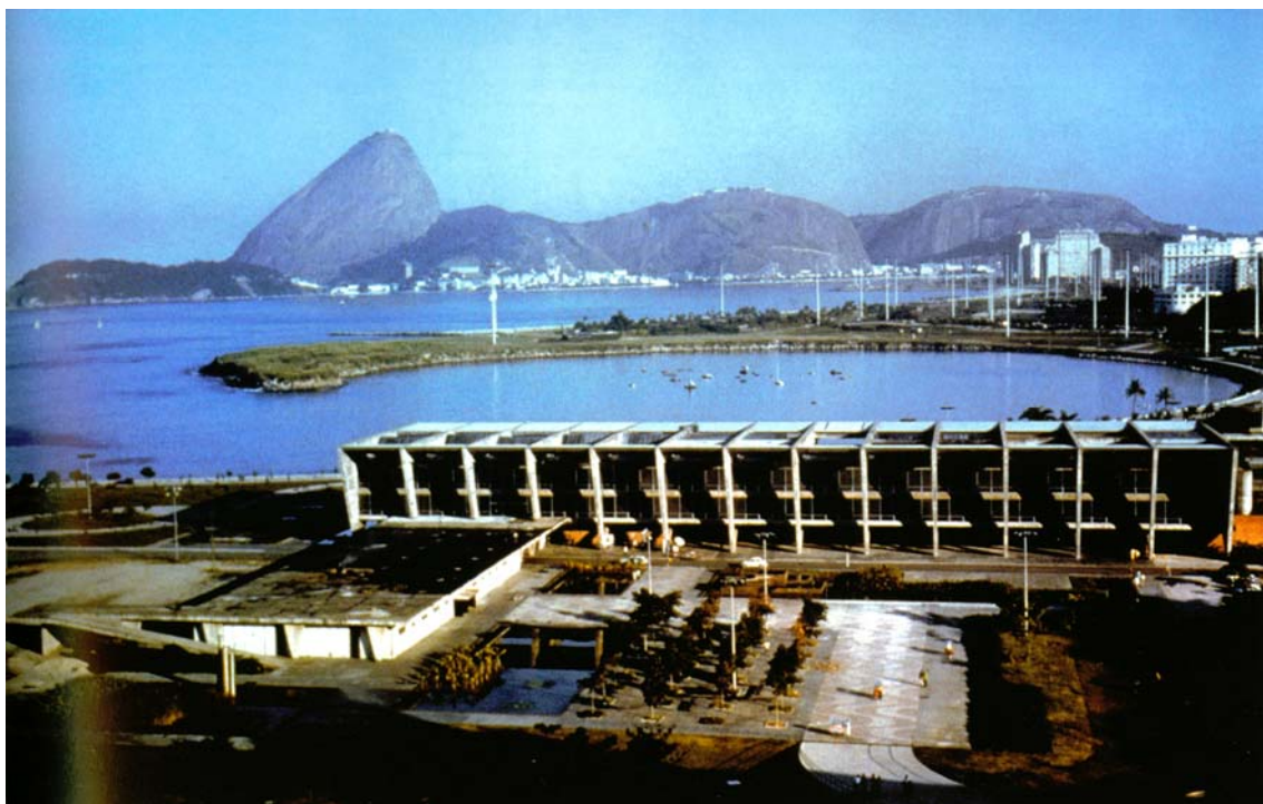
FIGURA 3 – MAM RJ. Vista do conjunto. Fonte: BONDUKI, 2000, p. 165.
