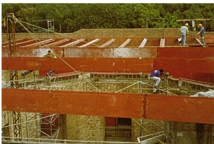
FIGURA 52 – Construção e instalação da nova cobertura (1997). Fonte: ARAUJO, 2002, p. 79.
