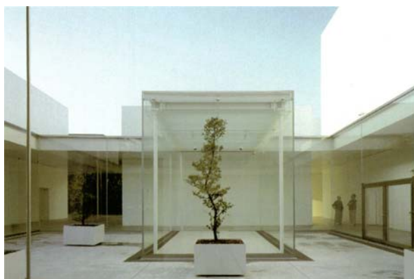
FIGURA 162 – Vista do pátio.
