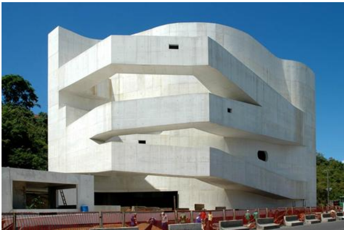
FIGURA 75 - Vista da fachada.
