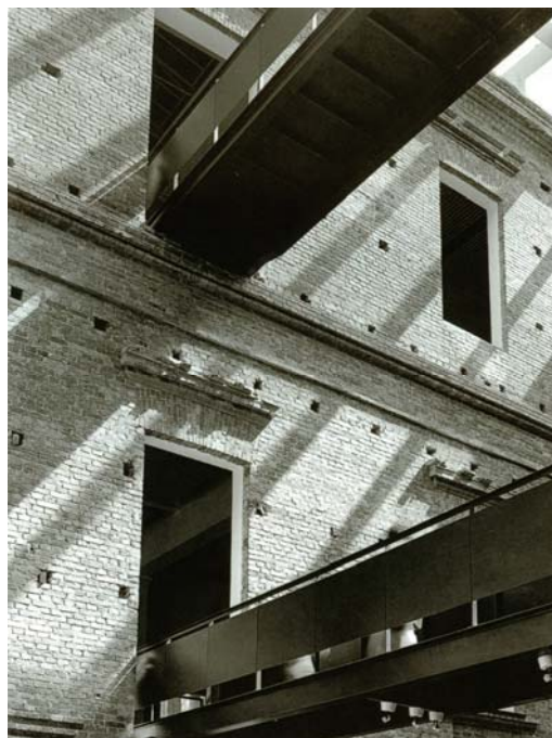
FIGURA 29 – Vista das passarelas metálicas. Fonte: ARTIGAS, 2000, p. 213.
