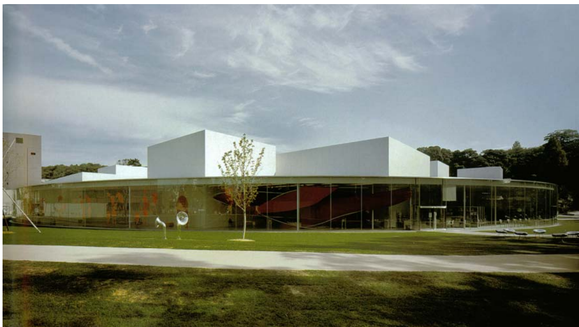
FIGURA 141 – Vista externa. Fonte: HASEGAWA, 2006, p. 79.
