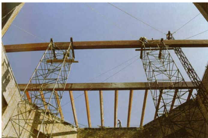
FIGURA 51 – Construção e instalação da nova cobertura (1997). Fonte: ARAUJO, 2002, p. 79.
