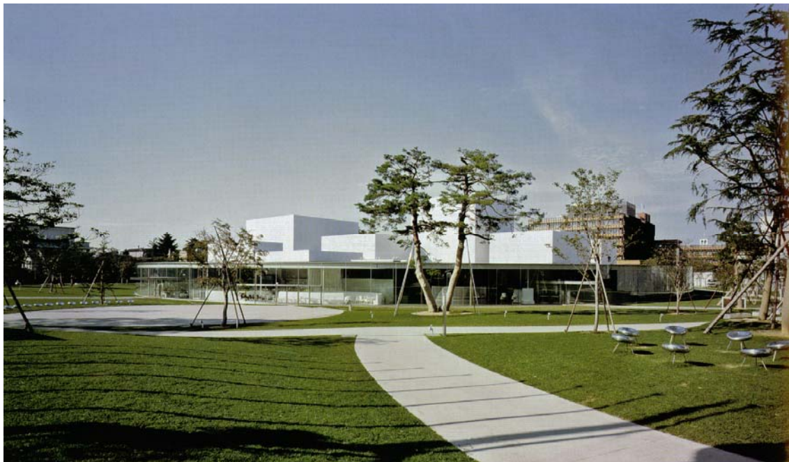
FIGURA 140 – Vista externa. Fonte: HASEGAWA, 2006, p. 78.
