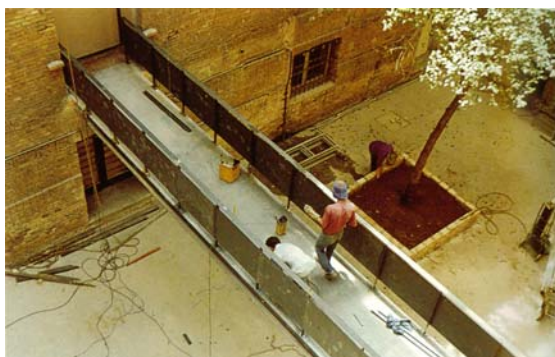
FIGURA 45 - Construção e instalação das passarelas. Fonte: ARAUJO, 2002, p. 62.
