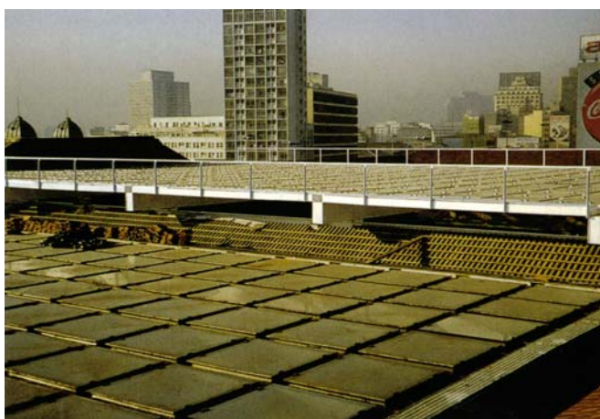
FIGURA 55 – Construção e instalação da nova cobertura (1997). Fonte: ARAUJO, 2002, p. 80.
