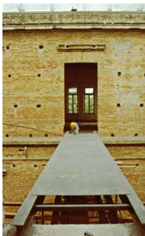
FIGURA 43 - Construção e instalação das passarelas. Fonte: ARAUJO, 2002, p. 61.
