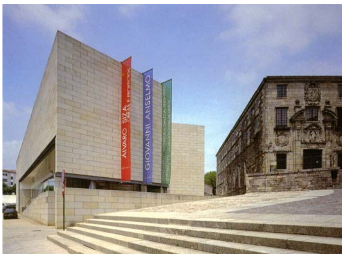
FIGURA 117 - Centro de Arte Contemporânea da Galícia. Vista do conjunto. Fonte: TRIGUEIROS, 1993, p. 89.
