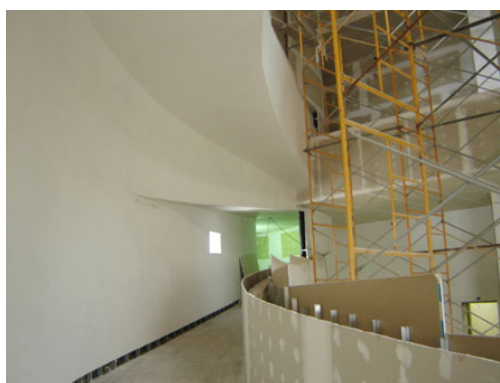
FIGURA 104-Execução do revestimento interno em painéis de gesso acartonado (22/08/07). Fonte: FUNDAÇÃO IBERÊ CAMARGO, 2007.
