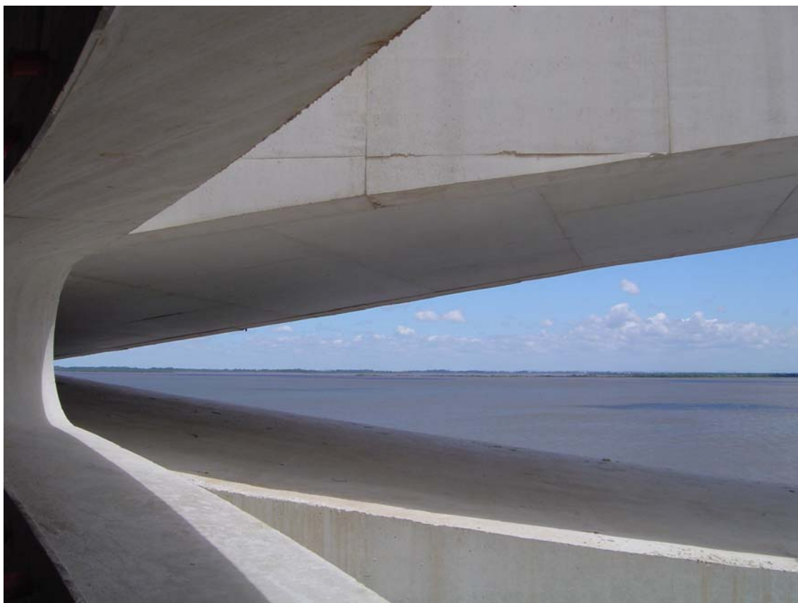
FIGURA 101 - Vista desde a abertura da rampa interna entre o 3º e o 4º pavimento. Fonte: Arquivo particular de Alexandre Brasil.
