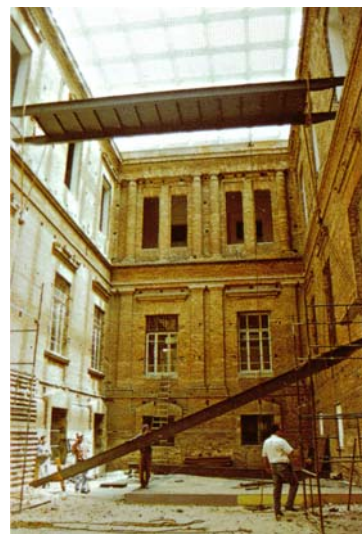
FIGURA 41 – Construção e instalação das passarelas. Fonte: ARAUJO, 2002, p. 61.
