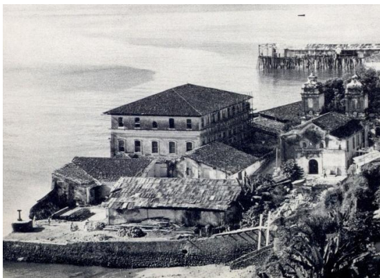
FIGURA 22 – Solar do Unhão, em Salvador, 1959, antes da restauração
