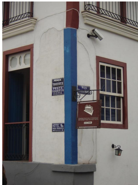
FIGURA 92 – [Parte remanescente da antiga construção, com textura diferente]
