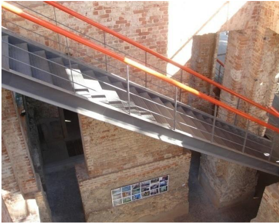
FIGURA 77 – [Parque das Ruínas, Rio de Janeiro: material das escadas e passarelas contrastam com a alvenaria de tijolo]
