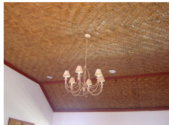
FIGURA 29 – [Uso de esteira como forro, que recebe luminárias embutidas]
