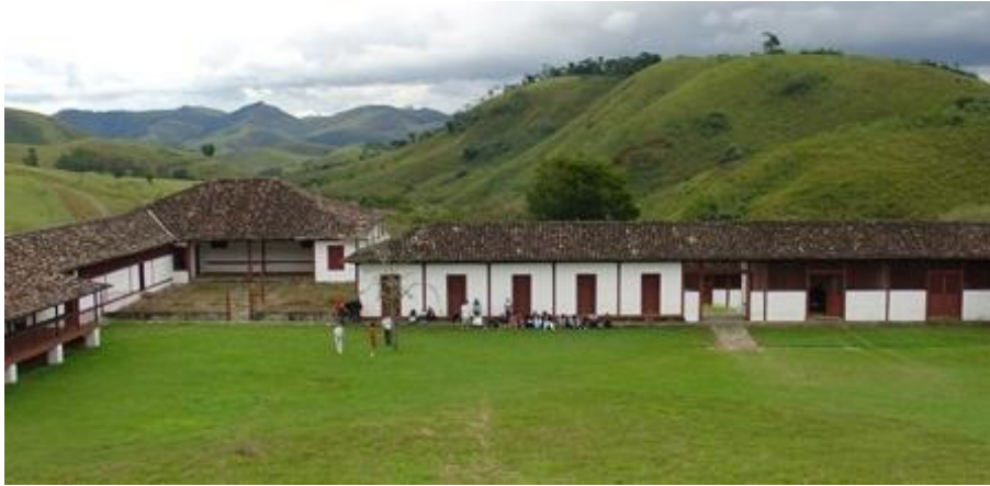
FIGURA 35 – [Fazenda Pau D'Alho, vista da Casa Grande: não-distinção entre os trechos reconstruídos (interferência contemporânea, principalmente estrutural) e os trechos apenas consolidados]
