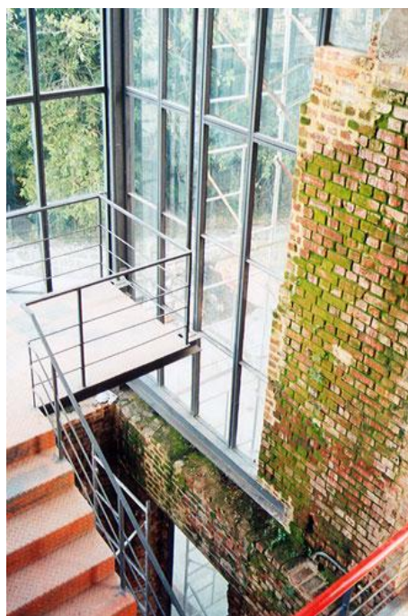
FIGURA 76 – [Parque das Ruínas, Rio de Janeiro: fechamento em aço e vidro, que protegem as plataformas dos mirantes]
