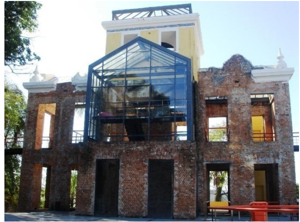
FIGURA 78 – [Parque das Ruínas, Rio de Janeiro: contraste no diálogo do aço e vidro com os materiais e elementos da fachada (pináculos e a parte remanescente das cornijas)]
