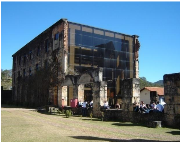
FIGURA 61 – [Fachadas norte (pano de vidro) e leste]
