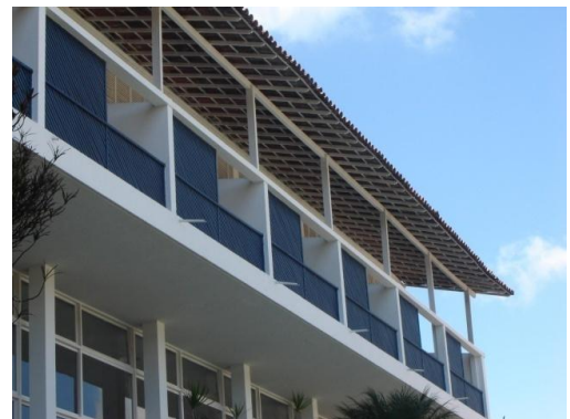
FIGURA 17 – [Detalhe do avarandado trabalhado em cheios e vazios com a utilização de muxarabis, pintados de azul escuro, que contrasta com o branco da alvenaria]
