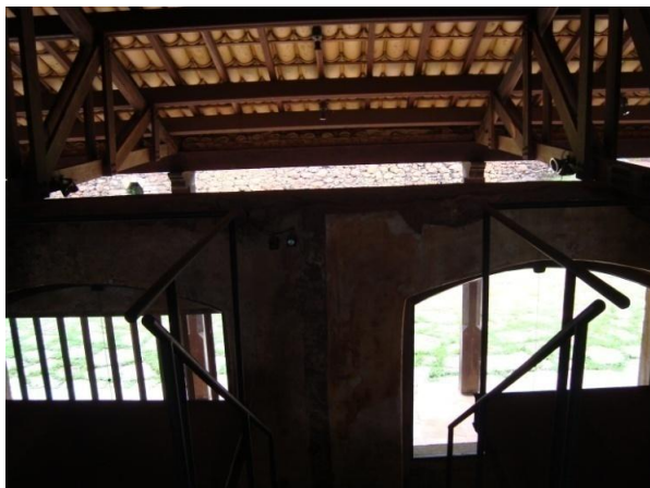
FIGURA 81 – [Sede da fazenda São José do Manso, Ouro Preto: estrutura da cobertura nova, independente, que poupa a edificação de cargas do telhado]
