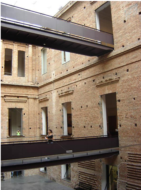
FIGURA 71 – [Pinacoteca de São Paulo: passarelas metálicas cruzando o pátio em dois níveis e janelas internas sem as esquadrias]
