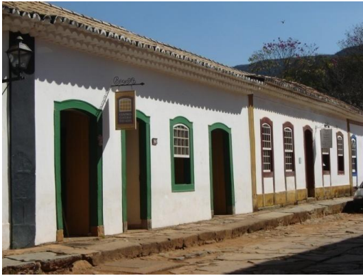
FIGURA 26 – [Fachada da sede do Centro Cultural Yves Alves com alguns dos seus elementos construtivos (baldrame) preservados]
