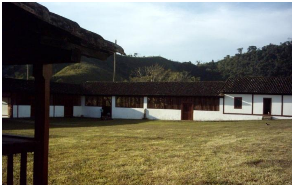
FIGURA 34 – [Não-distinção entre os trechos reconstruídos (interferência contemporânea, principalmente estrutural) e os trechos apenas consolidados]
