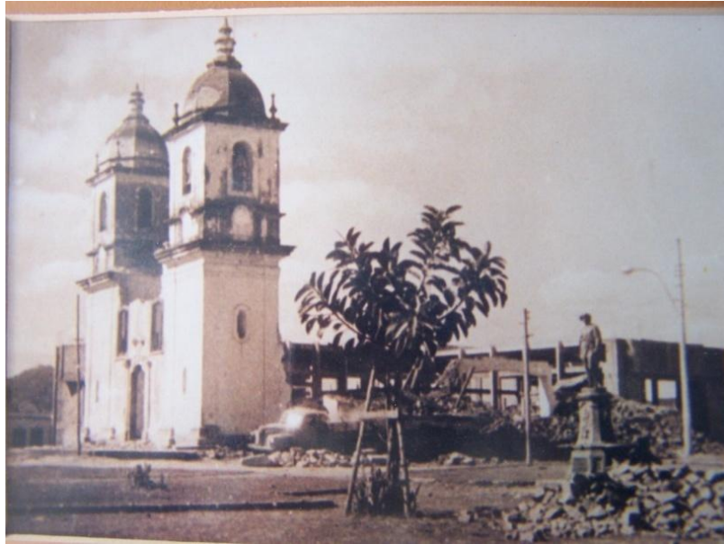
FIGURA 31 – [Demolição da Igreja de Matozinhos em São João del Rei, em 1970]
