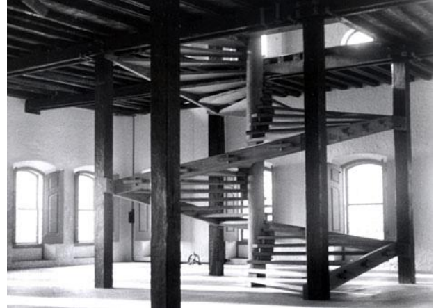
FIGURA 25 – Solar do Unhão, em 1963
