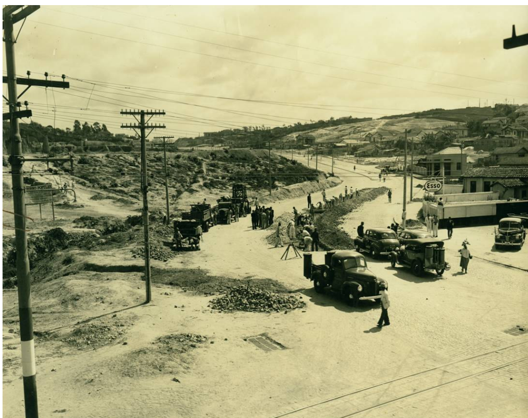
FIGURA 3 – Abertura da Avenida Antonio Carlos, note-se à esquerda, a área destinada à implantação do Conjunto IAPI.
