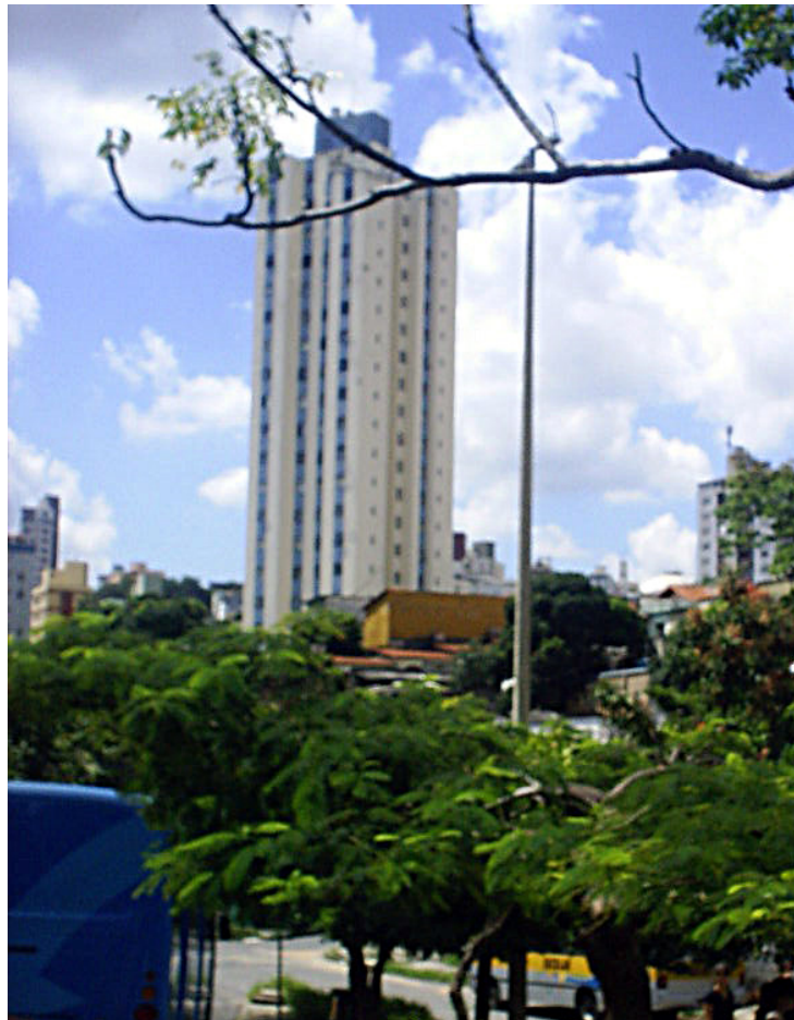
FIGURA 23 – Vista do único edifício mais alto do bairro, à Rua Jacuí, na divisa com o Bairro Renascença.
