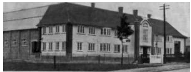
FIGURA 75 - Letchworth, Fábrica de Motores Phoenix. Em 1911 haviam onze indústrias instaladas na cidade. Fonte: KNIGHTON; CUTTS, 1911, p. 71.
