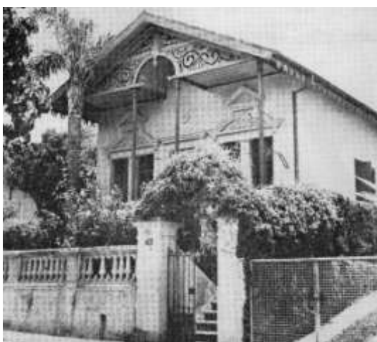
FIGURA 207 – Residência à Rua Alagoas, 736. Fonte: PROJETOS HISTÓRICO ..., 1977
