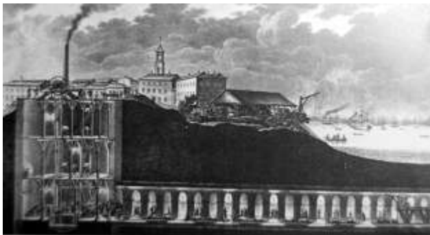
FIGURA 131 – Túnel sob o Rio Tamisa. Litografia de Bonisch (1843) , mostrando as escavações. Fonte: BENNETT, 2004, p. 16.
