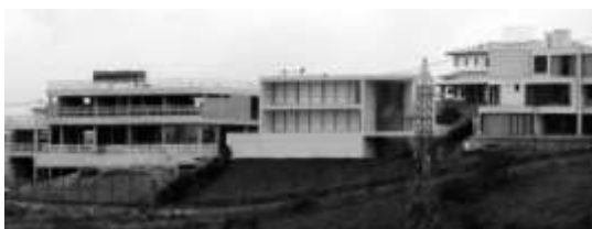
FIGURA 300 - Alphaville, Lagoa dos Ingleses, Residencial 3. Vista de três casas, observa-se a tipologia predominante de 2 pavimentos, com exemplos de até 3 pavimentos. Fonte: FOTO DO AUTOR, 2008.
