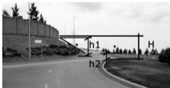
FIGURA 292 – Vista do desnível entre o residencial 3 e a avenida Wimbledon e também entre o residencial 1 e a mesma avenida. Em razão desta altura eventual via de ligação teria declividade acima do permitido pela legislação urbana. Fonte: FOTO DO AUTOR, 2008.
