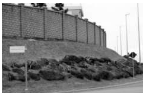
FIGURA 296 - Alphaville, Lagoa dos Ingleses, muro de divisa do Residencial 3 com avenida Wimbledon.
