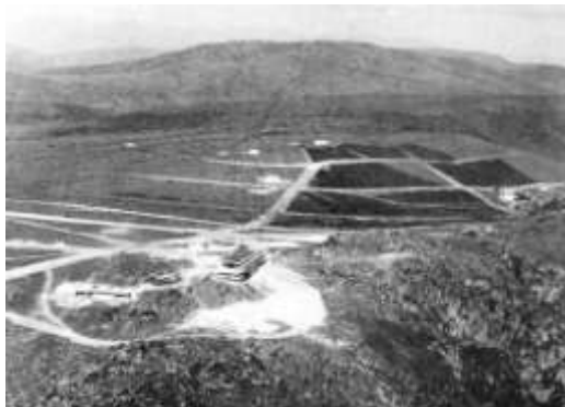
FIGURA 254 – Construção do loteamento do Retiro das Pedras, em primeiro plano o clube recreativo. Fonte: CONDOMÍNIO RETIRO DAS PEDRAS, 2009.
