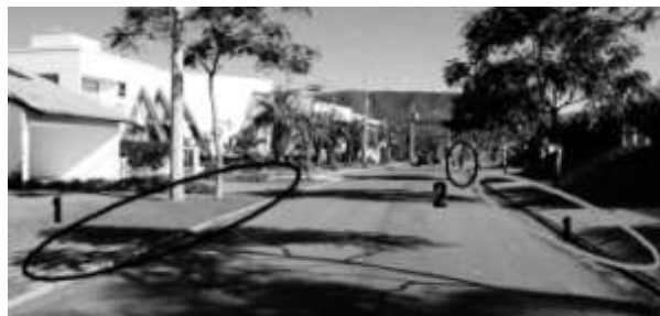
FIGURA 299 - Alphaville, Lagoa dos Ingleses, Residencial 1. A ausência de calçadas (1) dificulta a circulação de pedestres, que, na maioria das vezes, optam por circular pela via de veículos. Fonte: FOTO DO AUTOR, 2008.
