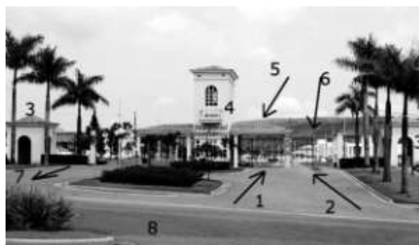
FIGURA 295 - Alphaville, Lagoa dos Ingleses, portaria de acesso ao Residencial 1, com acessos para veículos de moradores (1) e para veículos de convidados e prestadores de serviço (2) e guaritas de controle de pedestres (3) e veículos (4), saída de veículos (7) e avenida externa (8).
