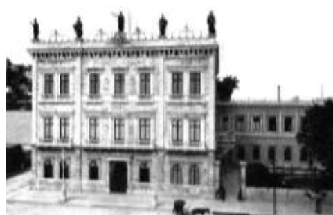
FIGURA 200 – Residência do Barão de Nova Friburgo, Rio de Janeiro, Ca. 1897, atual Palácio do Catete. Observa-se nesta fachada a presença de esculturas de musas compradas da Fundação Val D'Osne, na França, substituídas, no início do século XX por esculturas de águias. Fonte: FERREZ, [1897] 2009
