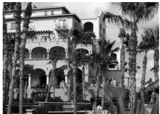
FIGURA 264 – Edifício em Los Angeles, no chamado "Estilo colonial Espanhol" Fonte: PLANET WARE, 2009
