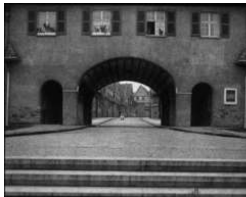
FIGURA 84 – Margarethenhöhe, portada de entrada para a Steiller Strasse. Fonte: LEJEUNE, 1996, p.55.
