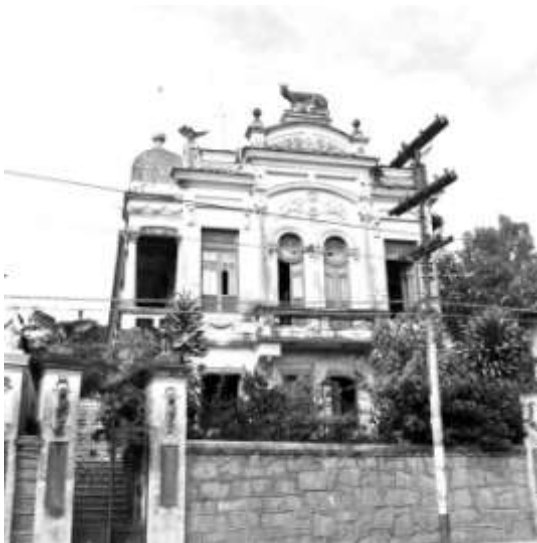
FIGURA 217 – Casa da Loba, Rua Itapecerica, 579, na Lagoinha, Belo Horizonte, 1960. Fonte: MAZONNI (1), 2009
