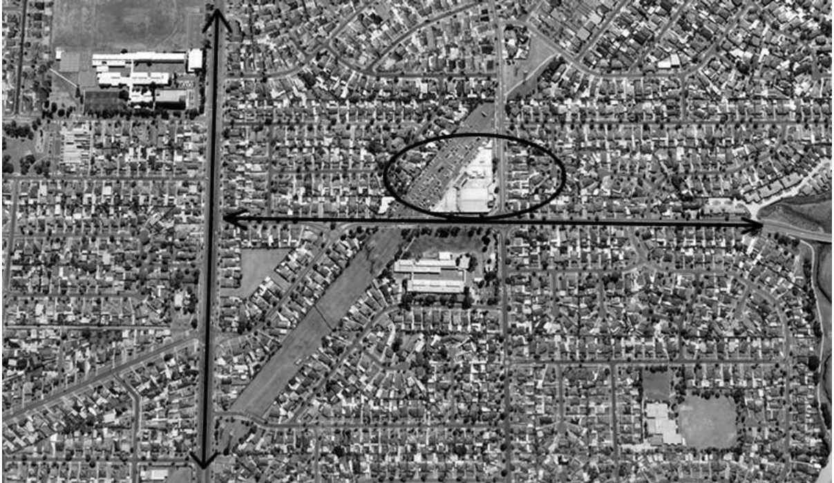
FIGURA 175 - Imagem de satélite de um subúrbio na região de Melbourne, Austrália. Pode-se observar o maior adensamento, a presença de Shopping Centers junto às artérias de ligação com a região central. Fonte: GOOGLE EARTH, 2008
